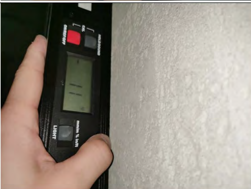
Фото №9. Измерение уровня стен в санузле.
