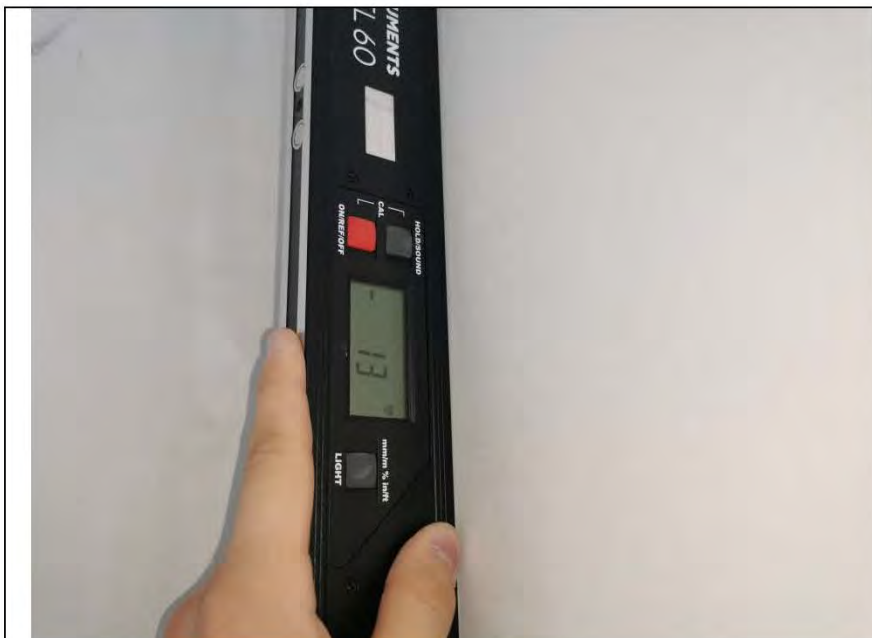
Фото №10. Измерение уровня стен в кухне.
