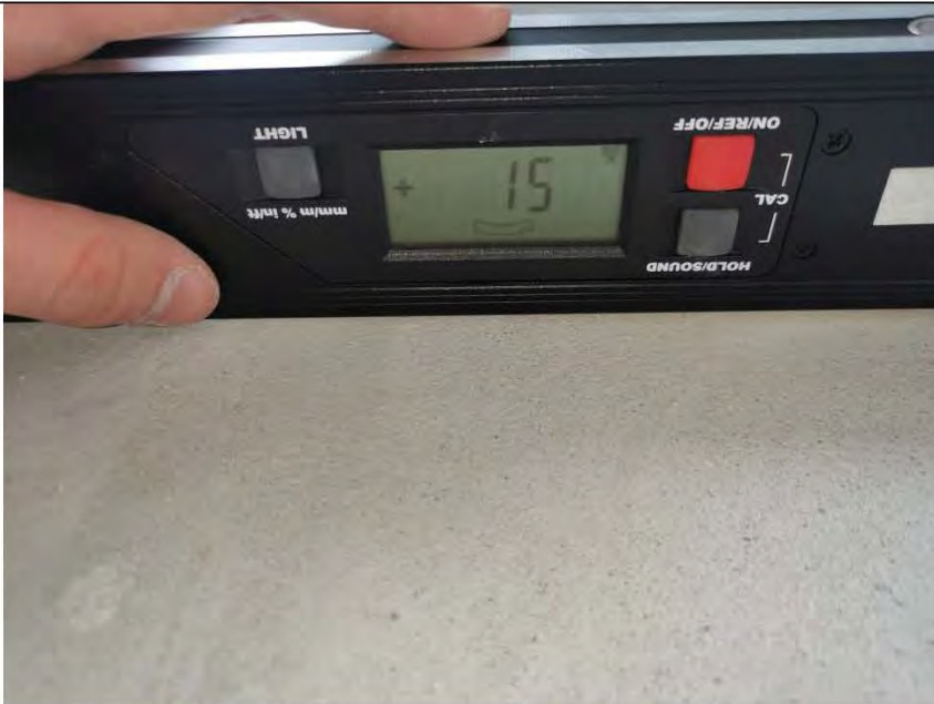
Фото №16. Измерение уровня пола в кухне.
