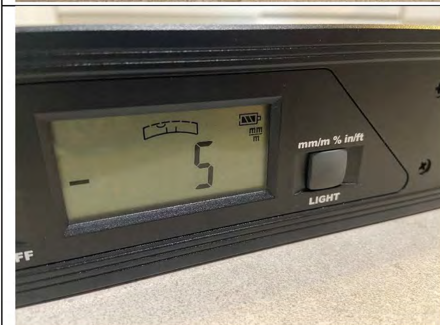
Фото №17. Отклонение поверхности напольного покрытия из керамической плитки в кухне.
