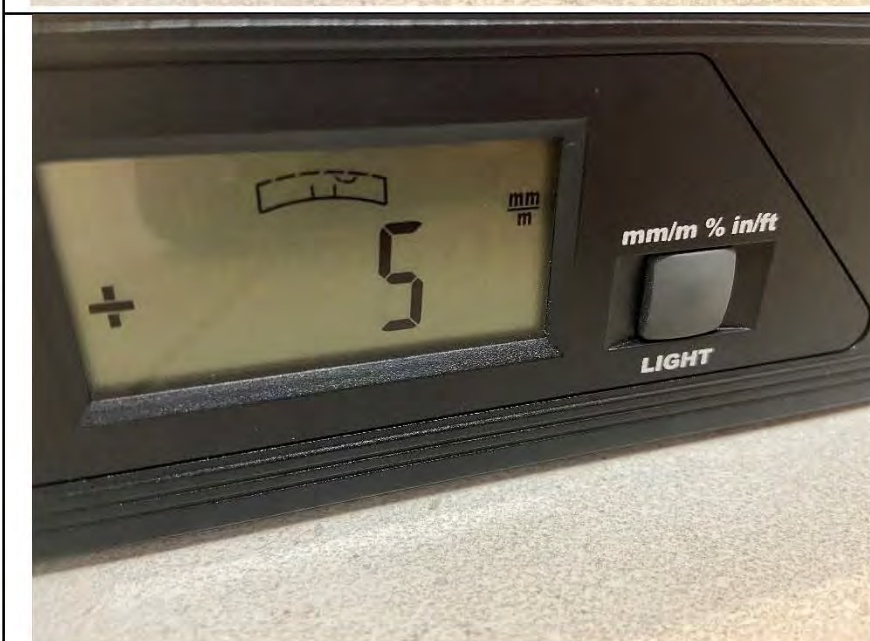
Фото №18. Отклонение поверхности напольного покрытия из керамической плитки в ванной комнате.
