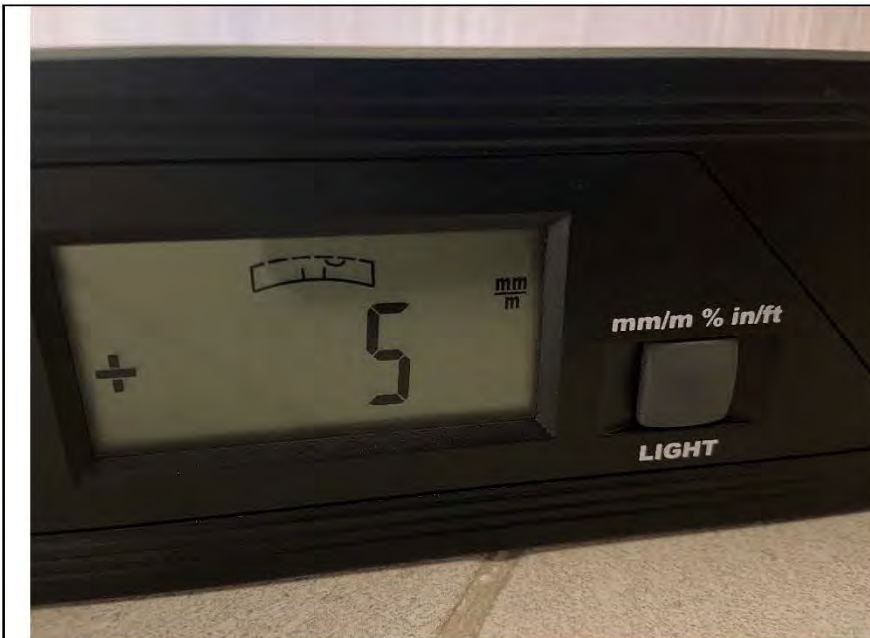
Фото №16. Отклонение поверхности напольного покрытия из керамической плитки в коридоре.
