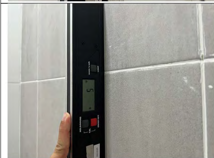
Фото №12. Измерение уровня стен в санузле.
