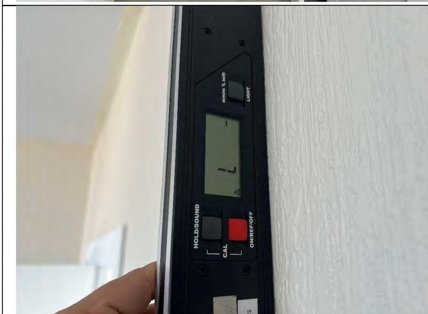
Фото №8. Измерение уровня стен в спальне.
