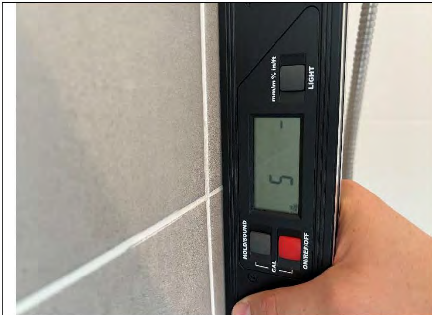
Фото №13. Измерение уровня стен в ванной комнате.
