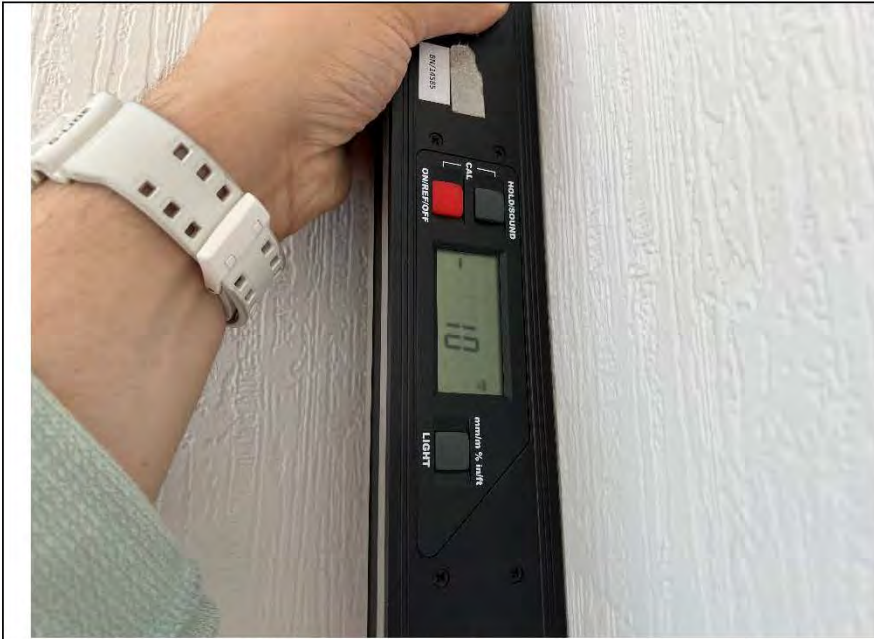
Фото №10. Измерение уровня стен в кухне.
