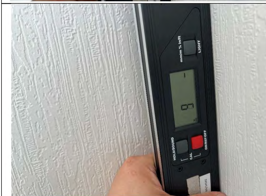
Фото №9. Измерение уровня стен в гостиной.
