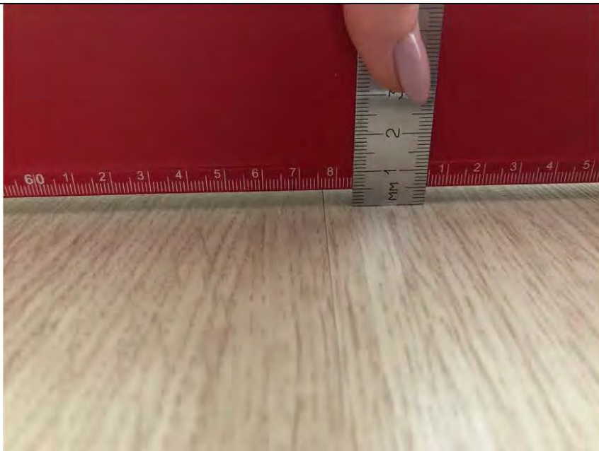
Фото №10. Измерение уровня ламината пола спальни в квартире.
