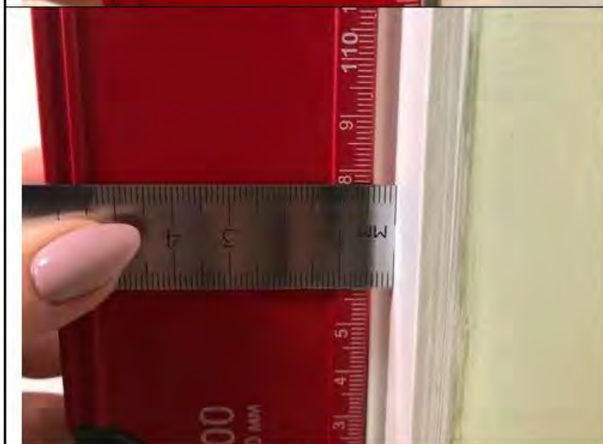
Фото №5. Отклонение наличника дверного блока кухни в квартире.
