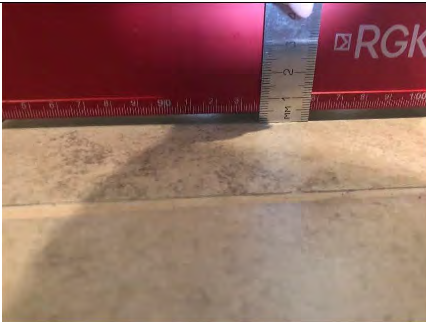
Фото №13. Измерение уровня плитки пола коридора в квартире.
