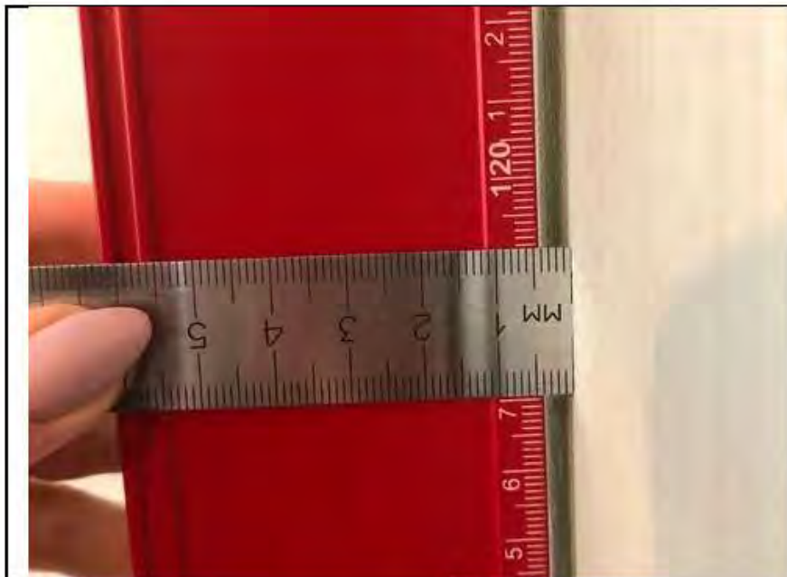
Фото №4. Измерение уровня стен детской в квартире.
