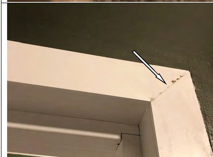
Фото №51. Дефект наличника дверного блока ванной комнаты в квартире.
