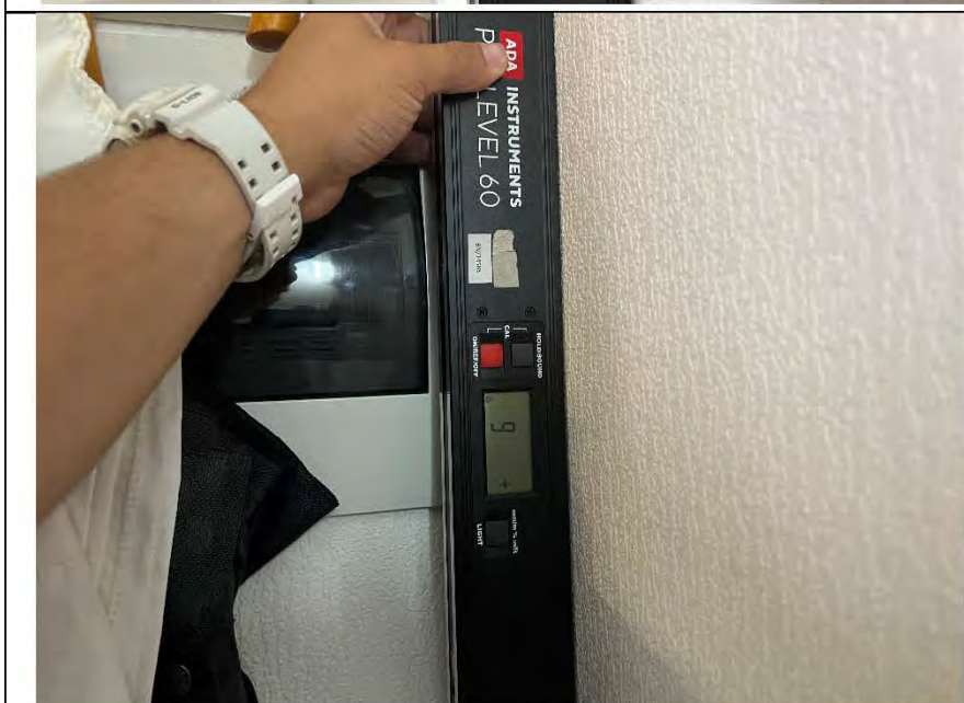
Фото №5. Измерение уровня стен в коридоре.
