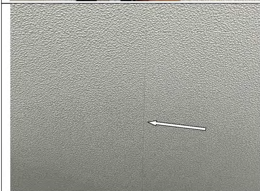
Фото №11. Читаемые обойные стыки в кухне.
