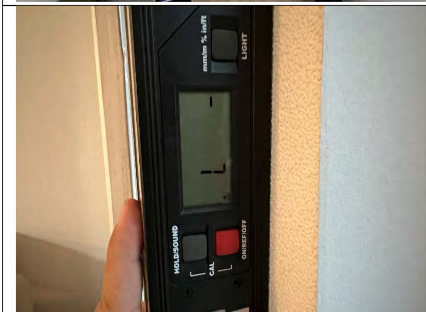
Фото №8. Измерение уровня стен в кухне.
