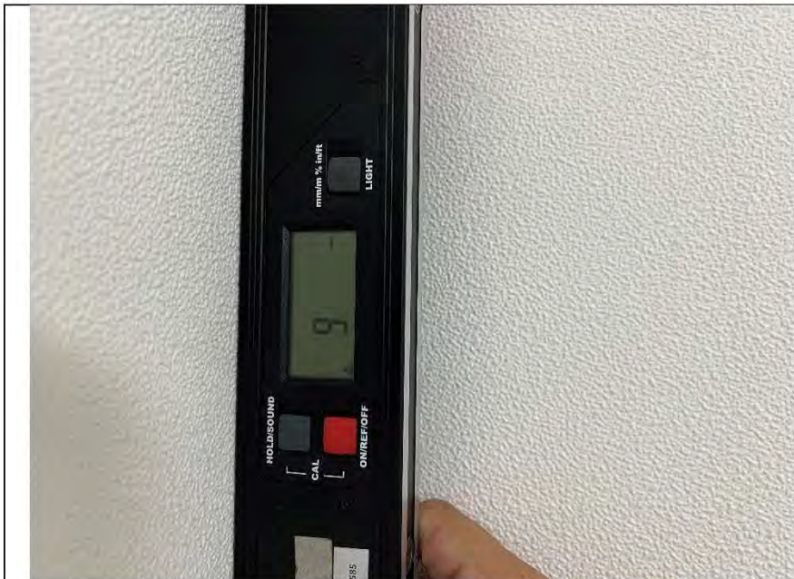
Фото №10. Измерение уровня стен в коридоре.
