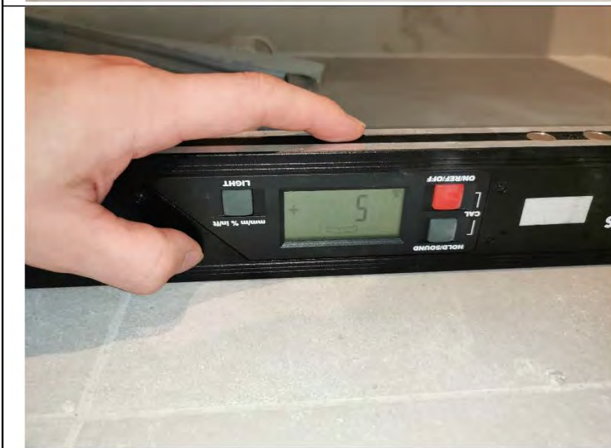
Фото №30. Измерение уровня пола в санузле.
