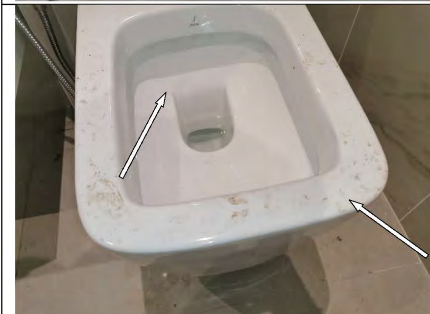
Фото №77. Загрязнение на унитазе в ванной комнате.
