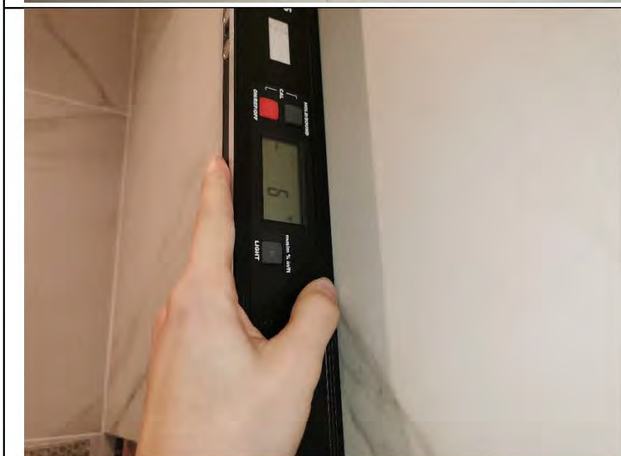
Фото №17. Измерение уровня стен в ванной комнате.
