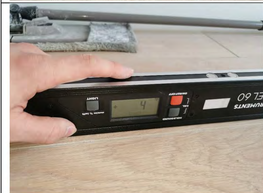
Фото №24. Измерение уровня пола в спальне.
