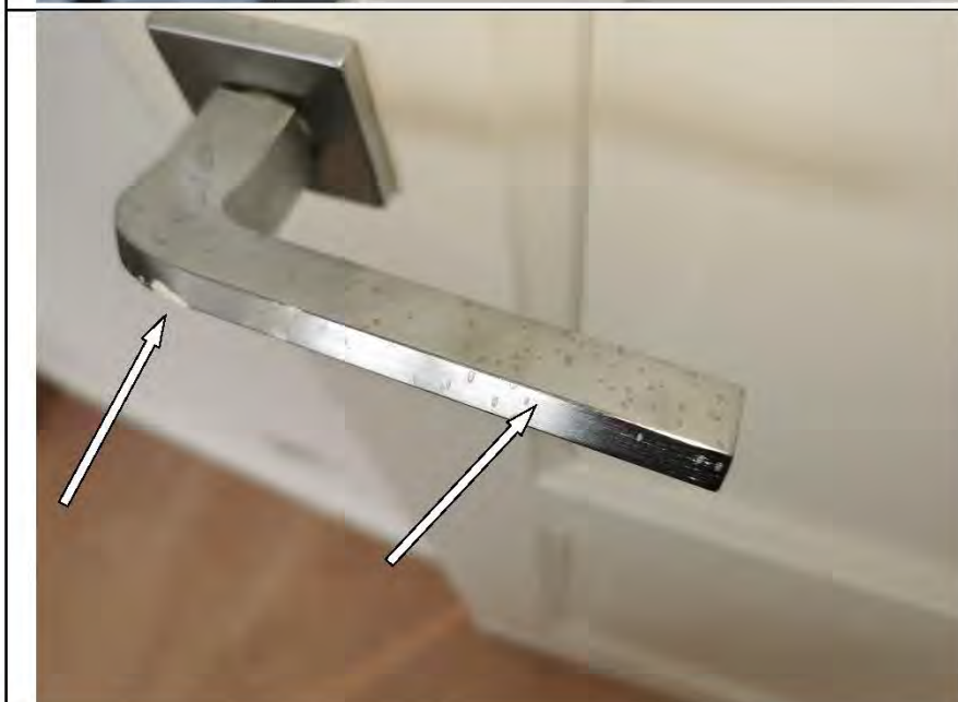
Фото №66. Загрязнения на фурнитуре деревянного дверного блока в детской.
