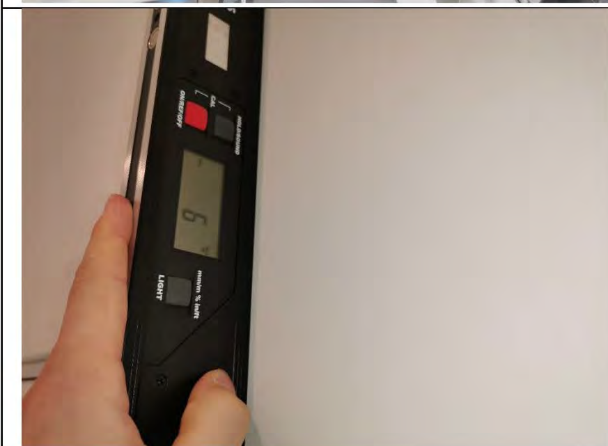
Фото №9. Измерение уровня стен в коридоре.
