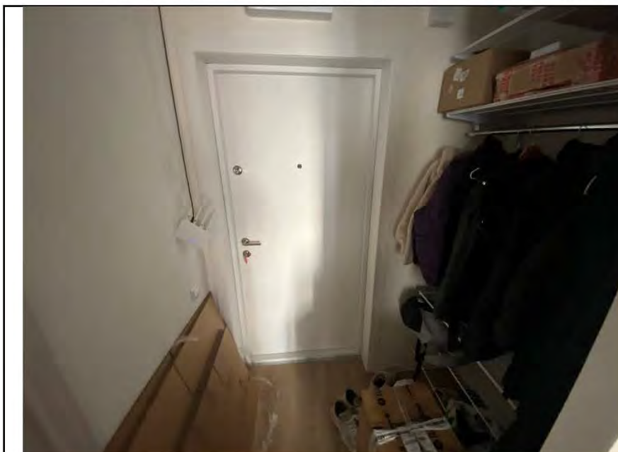
Фото №1. Общий вид коридора.
