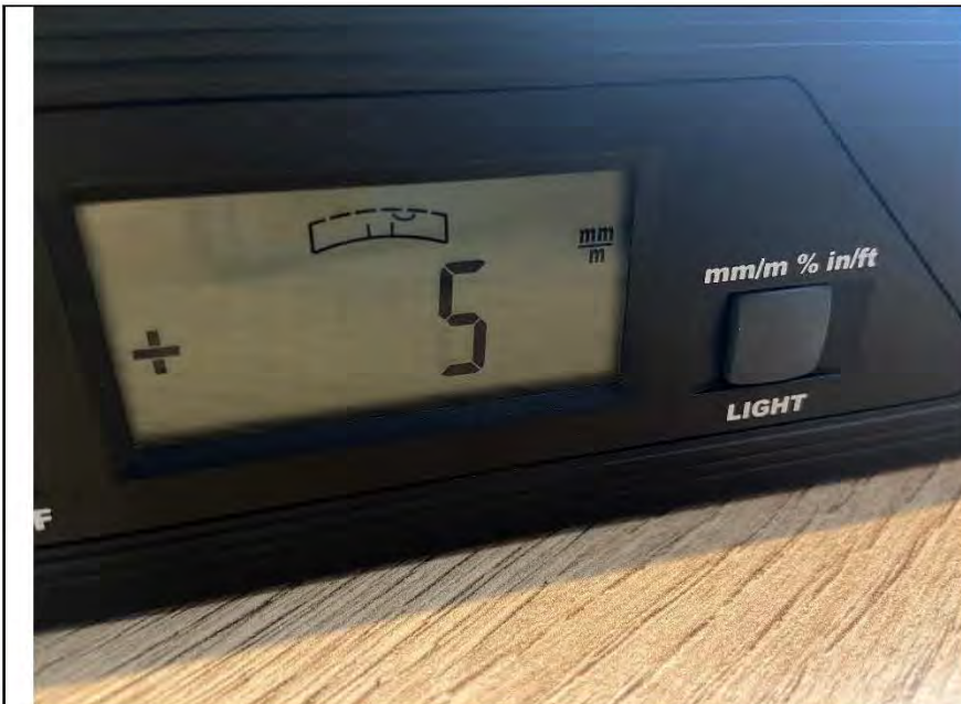
Фото №16. Отклонение поверхности напольного покрытия из ламината в кухне.
