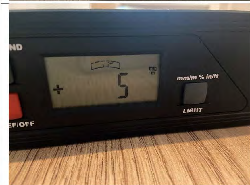
Фото №14. Отклонение поверхности напольного покрытия из ламината в коридоре.
