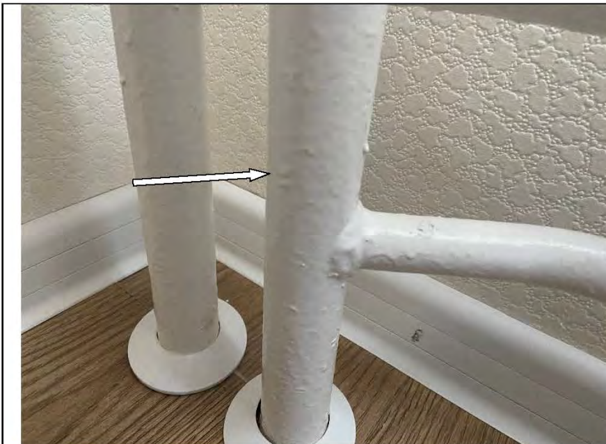
Фото №43. Неровности, подтеки, раковины на окрашенных трубах отопления в кухне.
