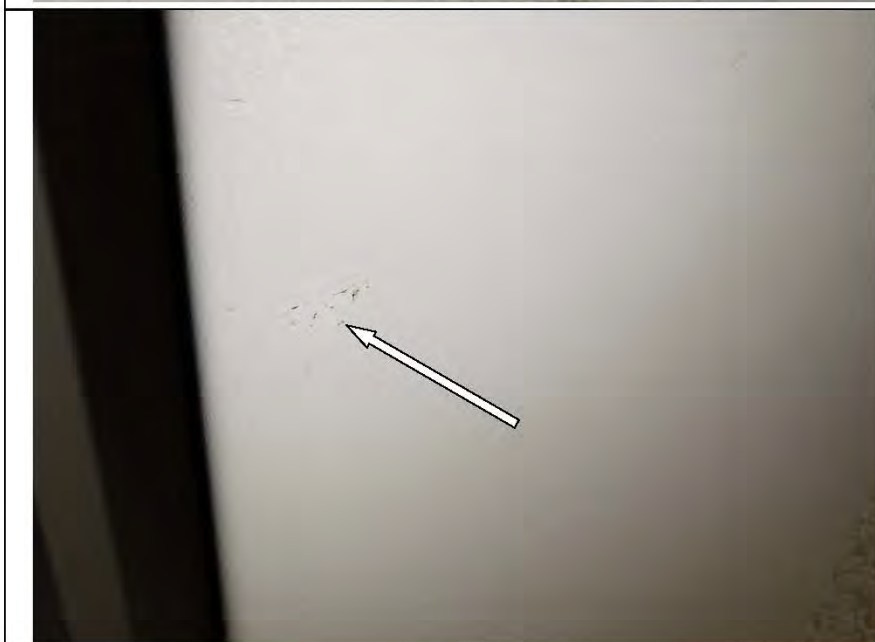
Фото №42. Царапины на коробке входного дверного блока.
