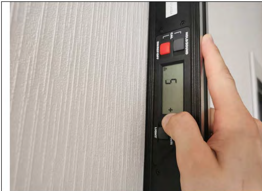
Фото №7. Измерение уровня стен в коридоре.
