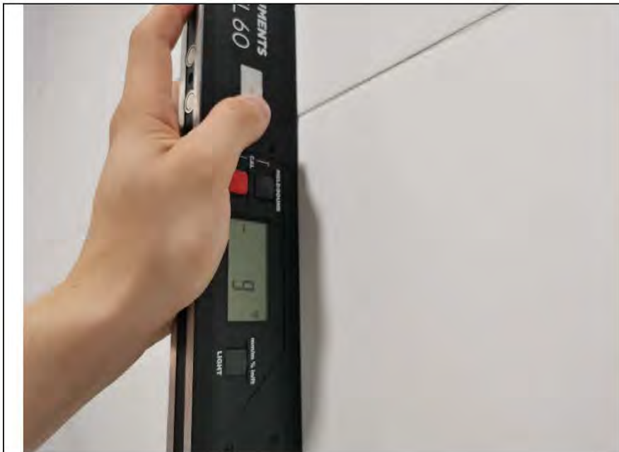
Фото №13. Измерение уровня стен в ванной комнате.
