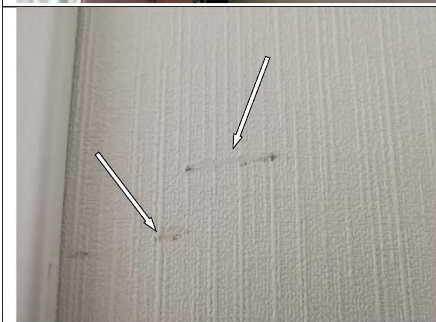
Фото №9. Потертости обойного полотна в коридоре.
