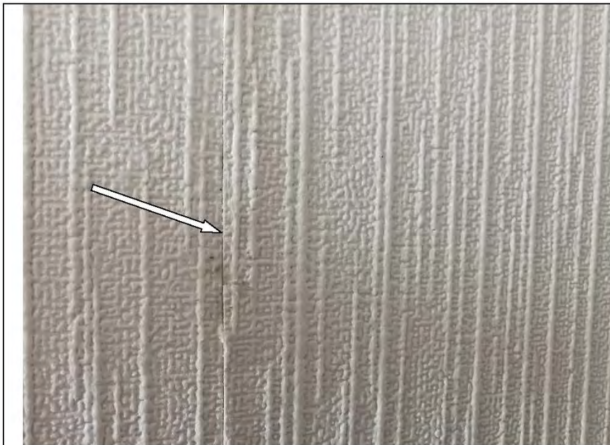
Фото №10. Читаемые обойные стыки в коридоре.
