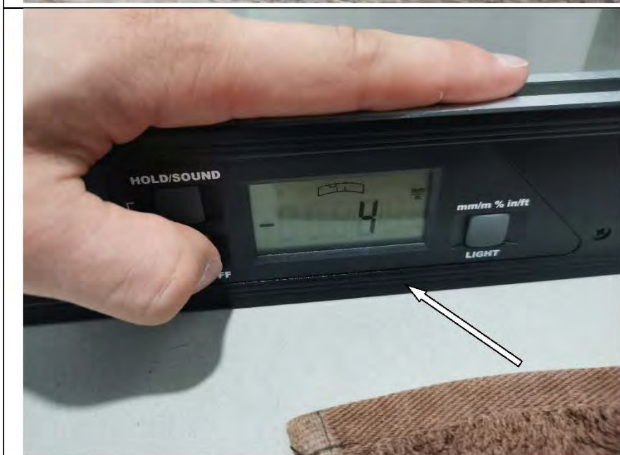
Фото №21. Измерение уровня пола в ванной комнате.
