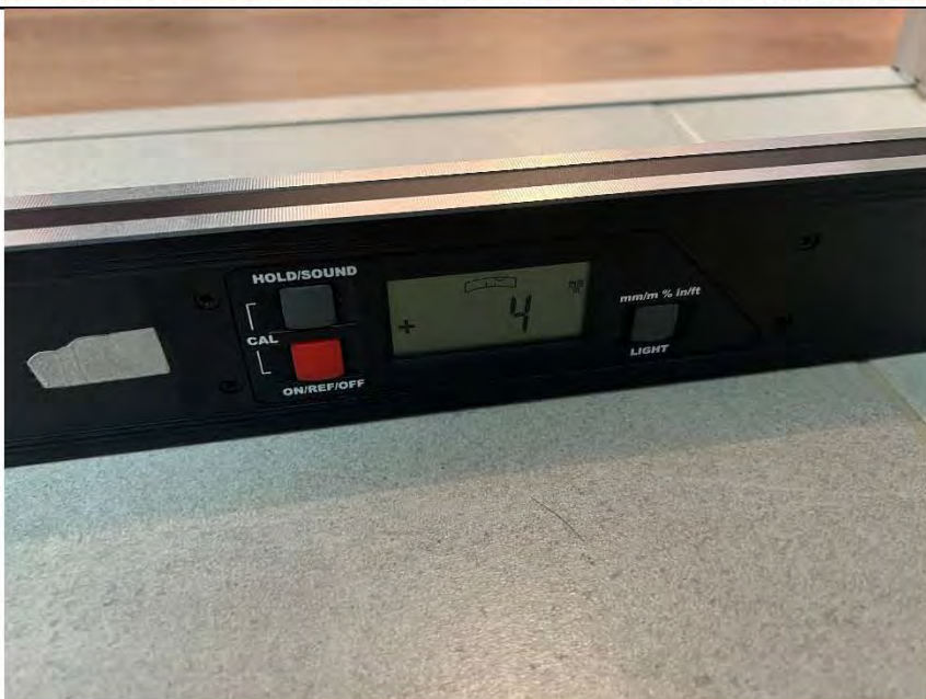
Фото №20. Измерение уровня напольного покрытия в ванной комнате.
