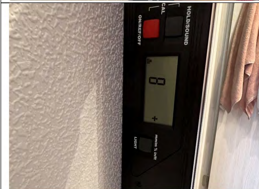
Фото №6. Измерение уровня стен в коридоре.
