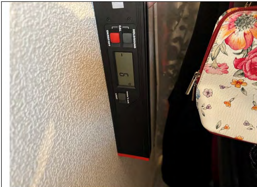
Фото №7. Измерение уровня стен в кухне.
