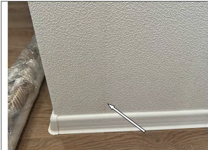
Фото №10. Читаемые обойные стыки в кухне.
