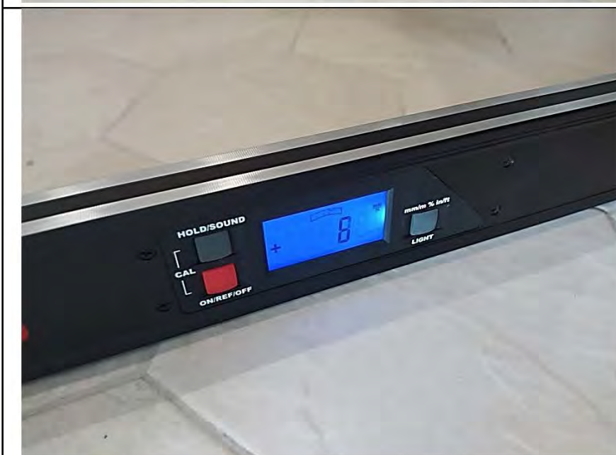
Фото №20. Измерения уровня напольного покрытия в санузле (керамическая плитка).
