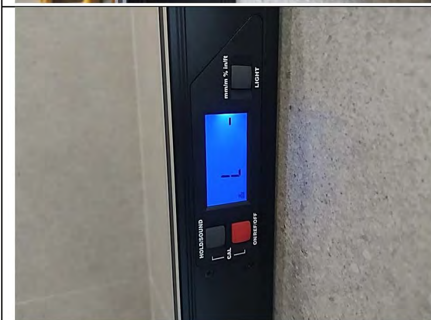
Фото №12. Измерения уровня стен в санузле.
