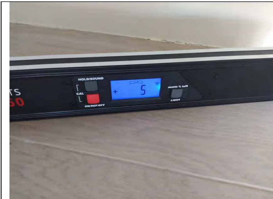
Фото №16. Измерения уровня напольного покрытия в прихожей (паркет).
