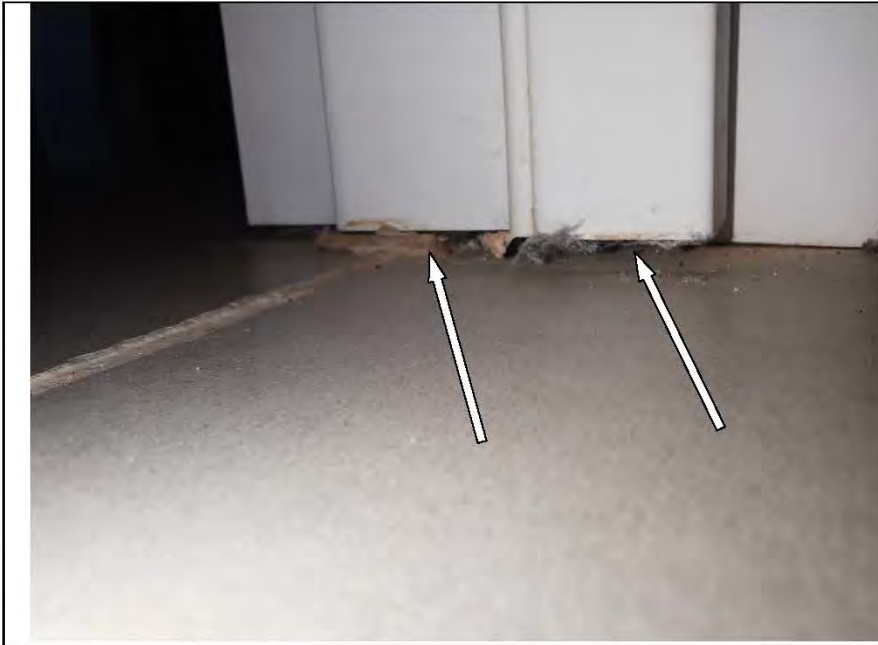
Фото №58. Коротко подрезан короб деревянного дверного блока в санузле.
