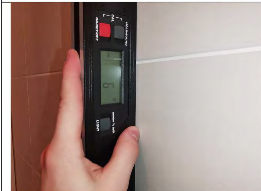
Фото №14. Измерение уровня стен в санузле.
