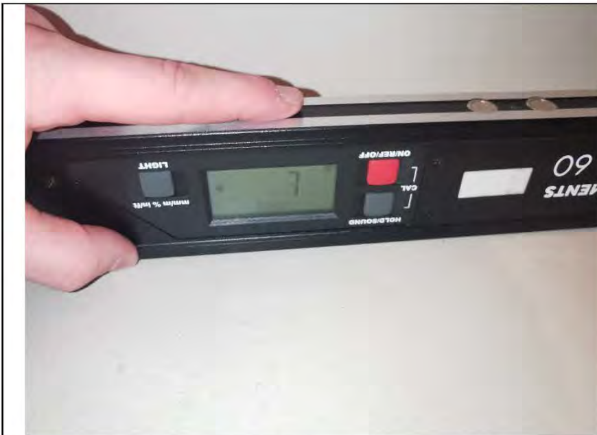
Фото №22. Измерение уровня пола в санузле.
