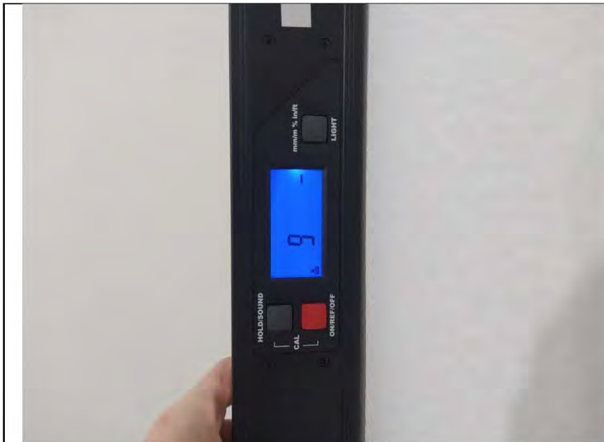
Фото №10. Измерение уровня стен в прихожей.
