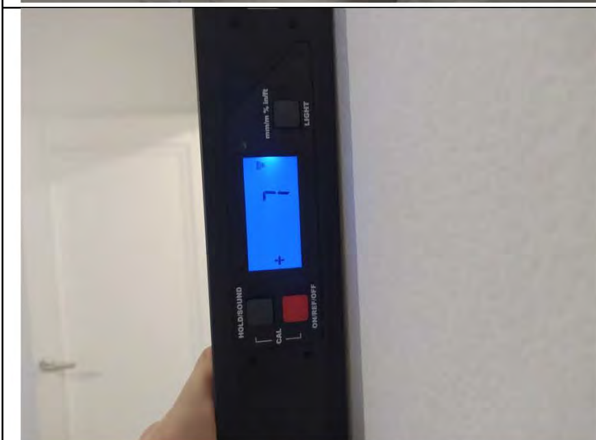
Фото №8. Измерение уровня стен в спальне.
