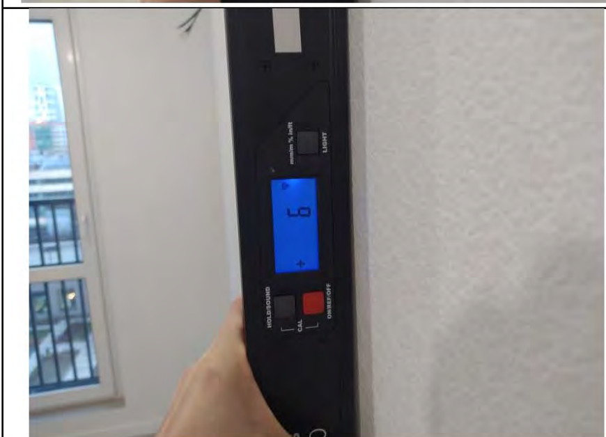
Фото №9. Измерение уровня стен в кухне.
