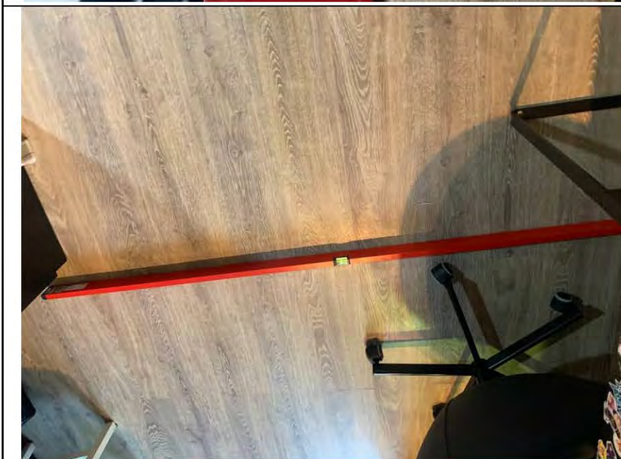
Фото №39. Измерение уровня пола в комнате
