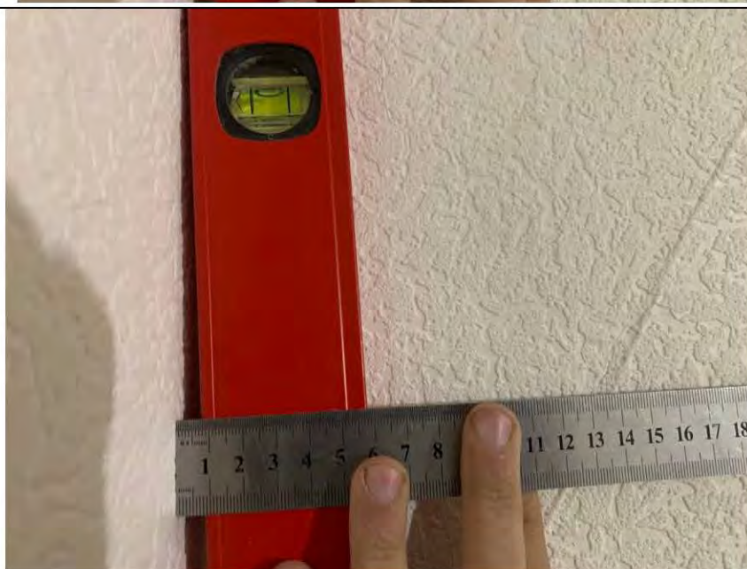
Фото №31. Неровности плавных очертаний на стене кухни
