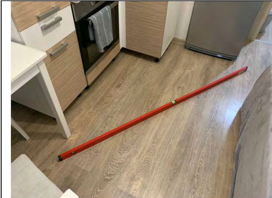
Фото №26. Измерение уровня пола на кухне
