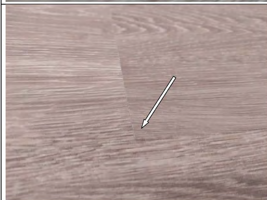
Фото №60. Поднятые кромки досок ламината в прихожей
