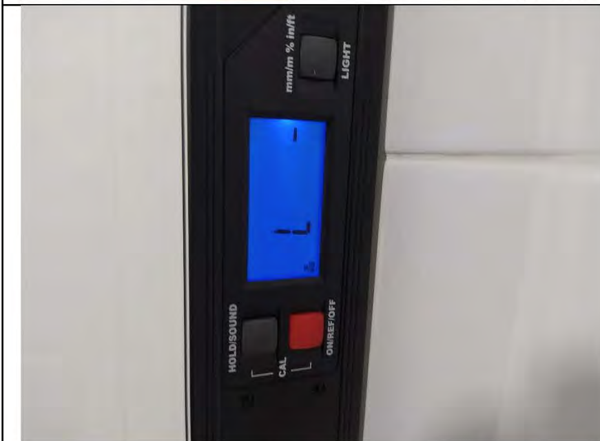
Фото №14. Измерение уровня стен в ванной комнате (керамическая плитка).
