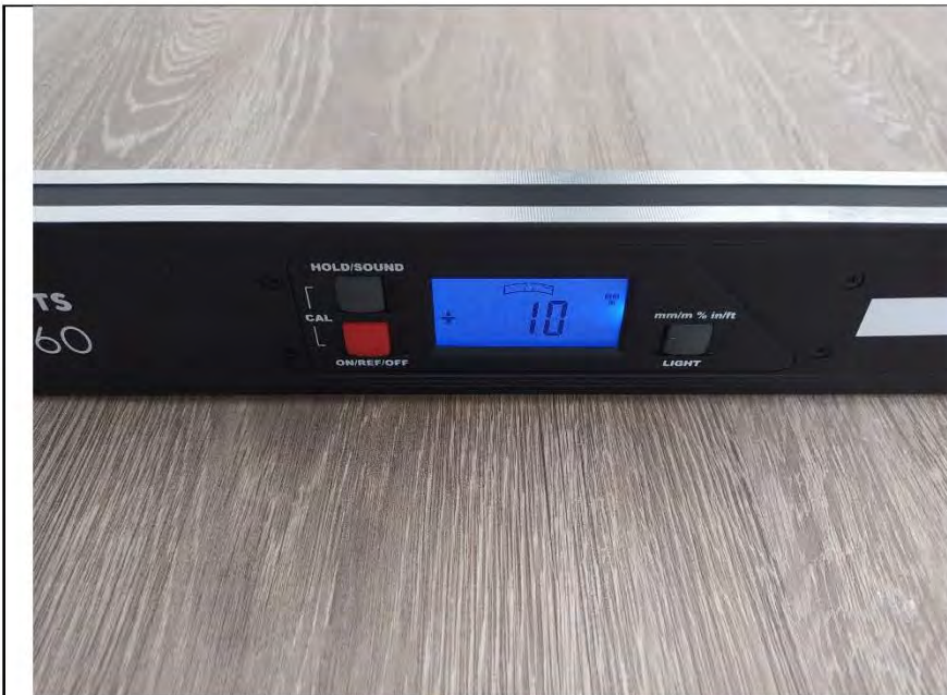
Фото №16. Измерение уровня напольного покрытия в гостиной.
