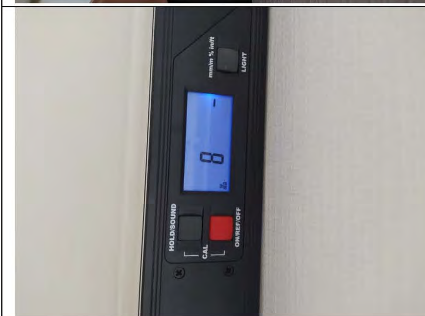
Фото №12. Измерение уровня стен в гостиной.
