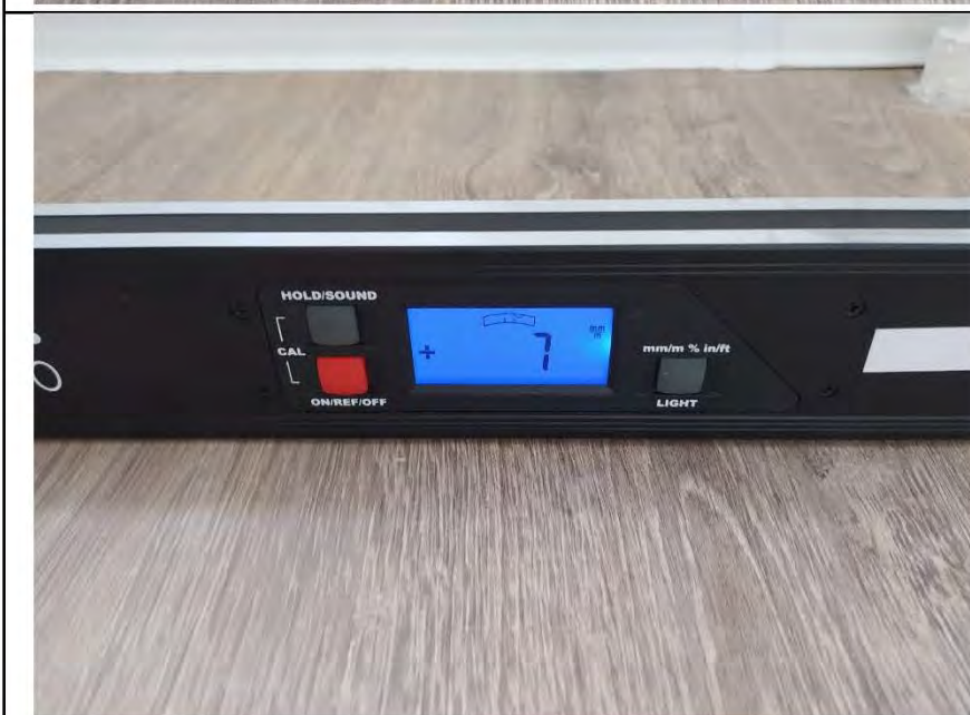
Фото №17. Измерение уровня напольного покрытия в спальне.
