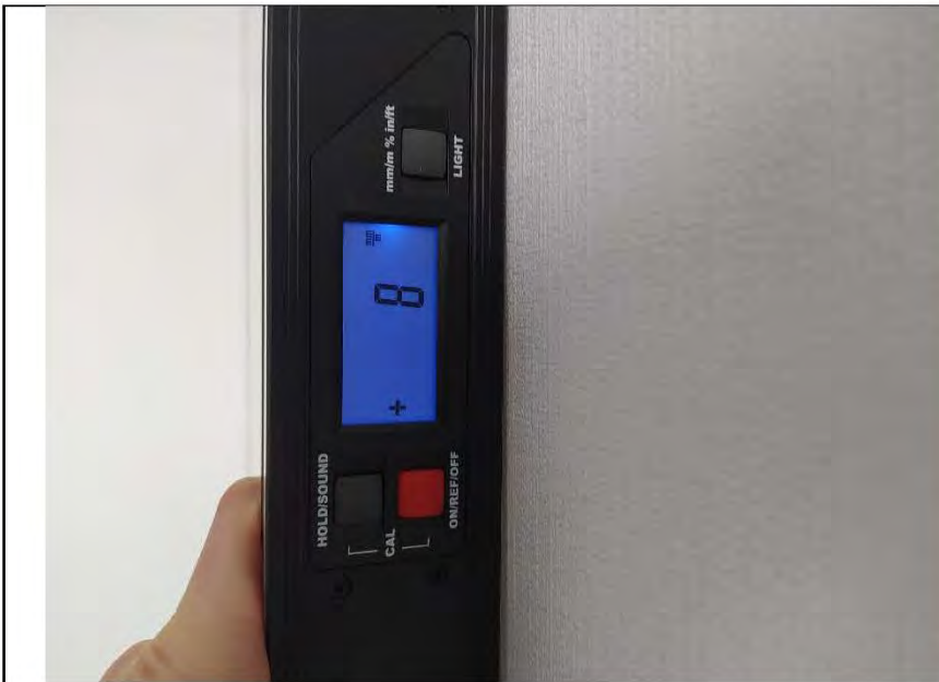
Фото №10. Измерение уровня стен в кухне.
