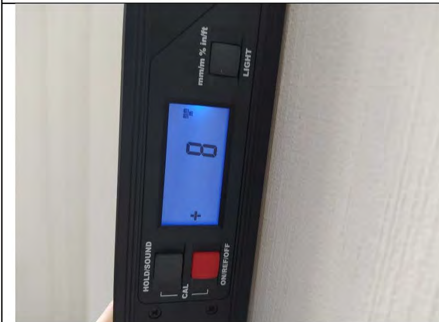
Фото №9. Измерение уровня стен в спальне.
