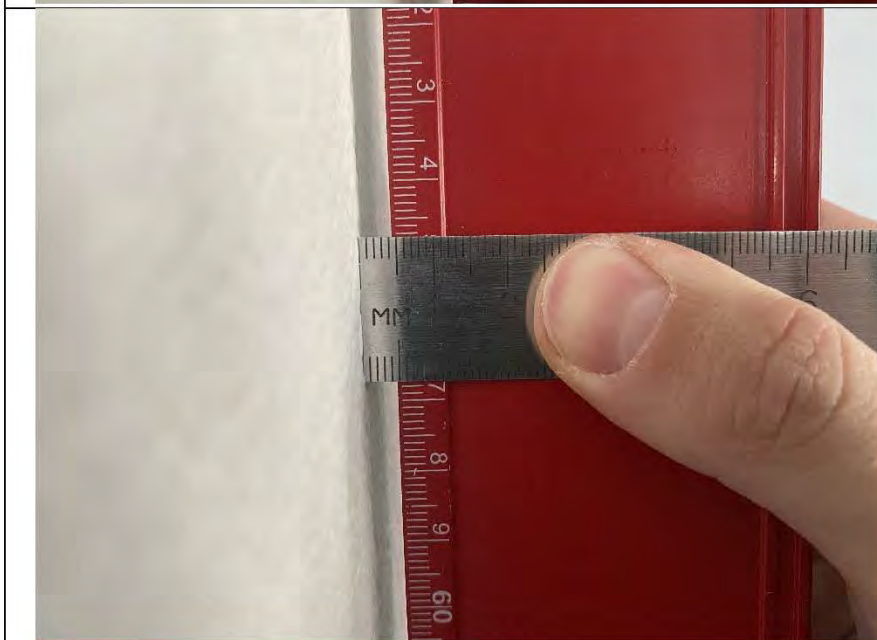
Фото №14. Измерение уровня стен в кухне.
