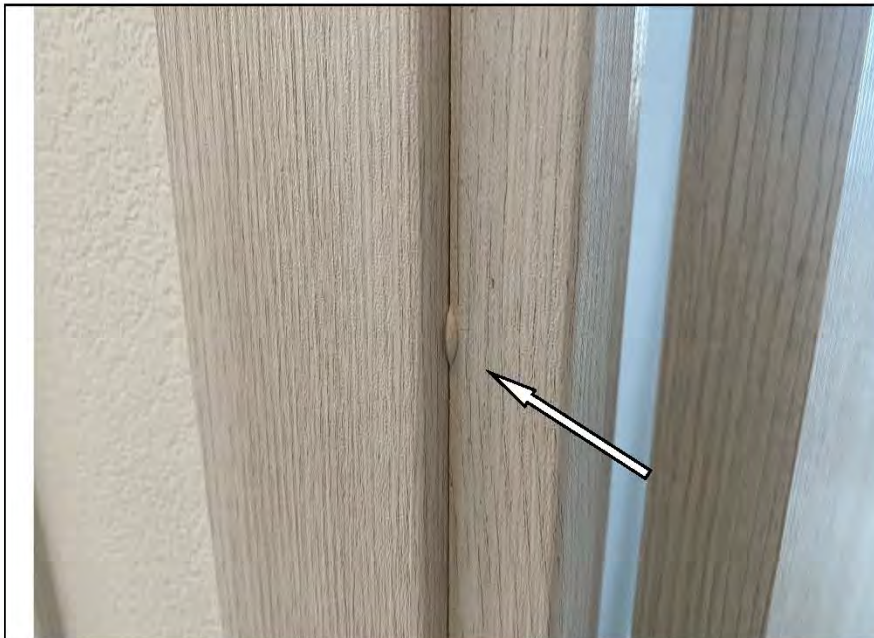
Фото №28. Наличник деревянного дверного блока имеет загрязнения в гостиной.
