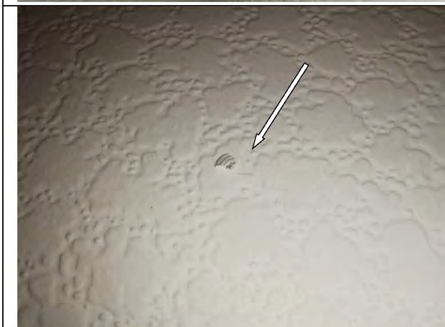
Фото №8. Потертости на обойном полотне в коридоре.
