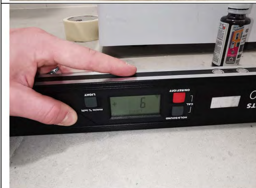
Фото №20. Измерение уровня пола в санузле.
