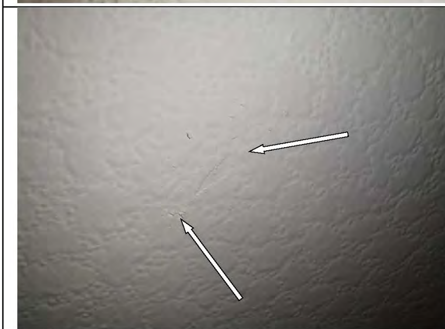
Фото №9. Потертости на обойном полотне в коридоре.
