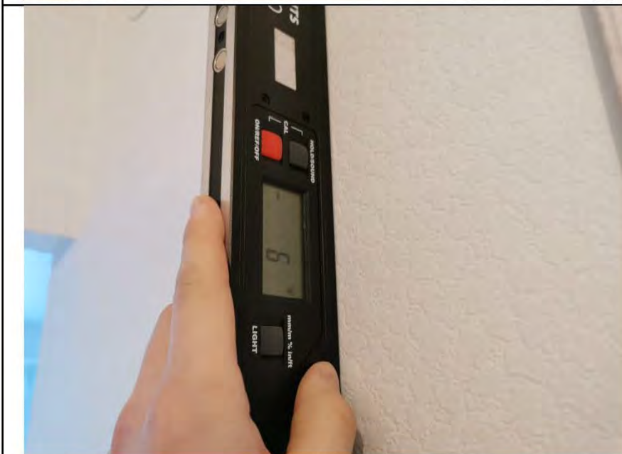
Фото №5. Измерение уровня стен в коридоре.
