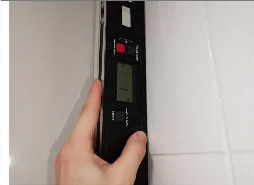
Фото №13. Измерение уровня стен в санузле.
