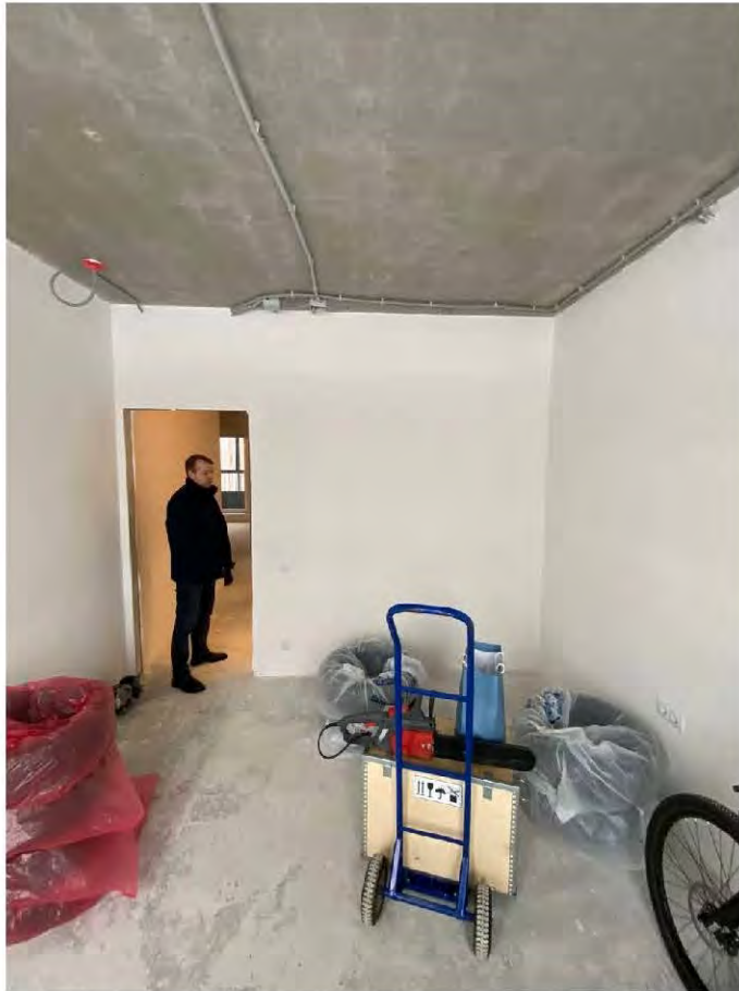
Фото 13. Комната 2. Общий вид помещения.
