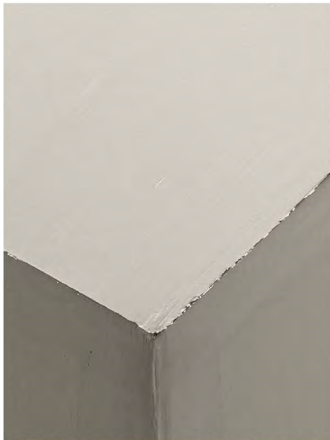
Фото 34. Лоджия. 3.4 Некачественная окраска потолка, имеются разводы и полосы
