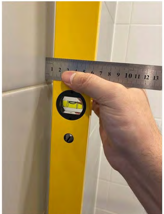
Фото 50, 51. Ванная. 6.2 Отклонение на участках стен из керамической плитки от вертикали 14 мм, 10 мм
