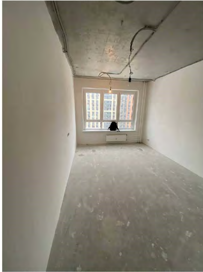
Фото 7. Комната 1. Общий вид помещения.
