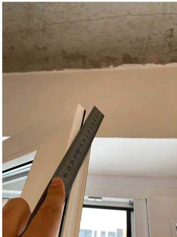
Фото 35-38. Комната 1. 4.1 Множественные повреждения на оконном блоке царапины, сколы, потертости
