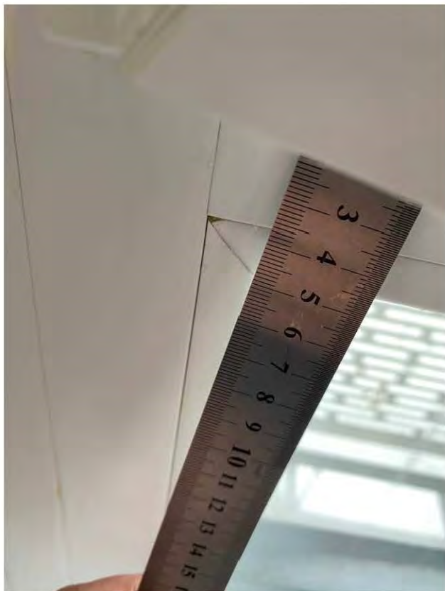
Фото 35-38. Комната 1. 4.1 Множественные повреждения на оконном блоке царапины, сколы, потертости
