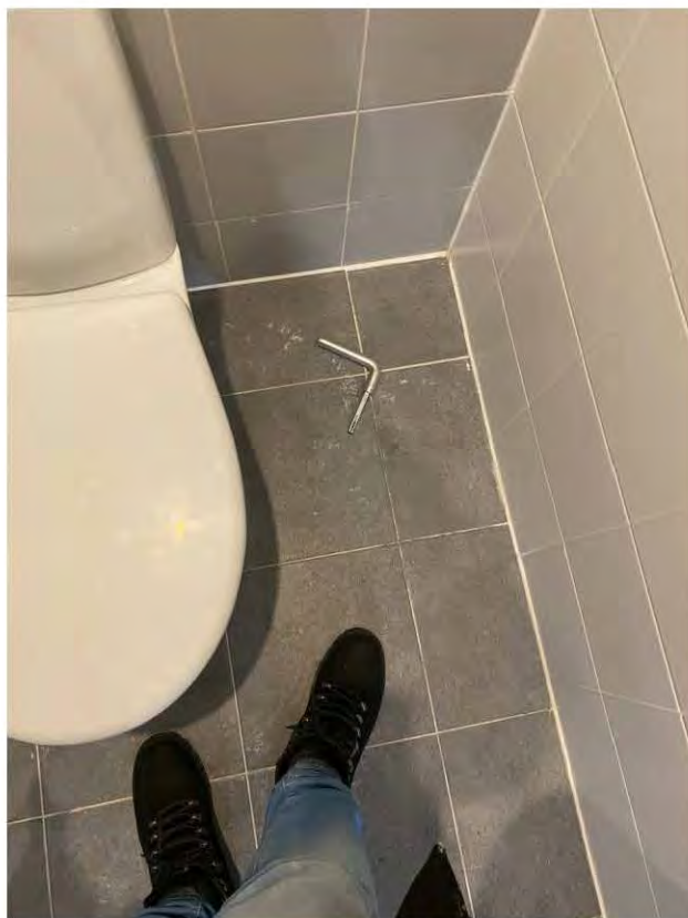
Фото 45, 46. Санузел. 5.1 Изменение характера звука при простукивании плитки (пустоты)
