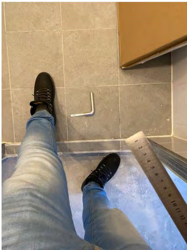
Фото 53, 54. Ванная. 6.4 Изменение характера звука при простукивании плитки (пустоты)
