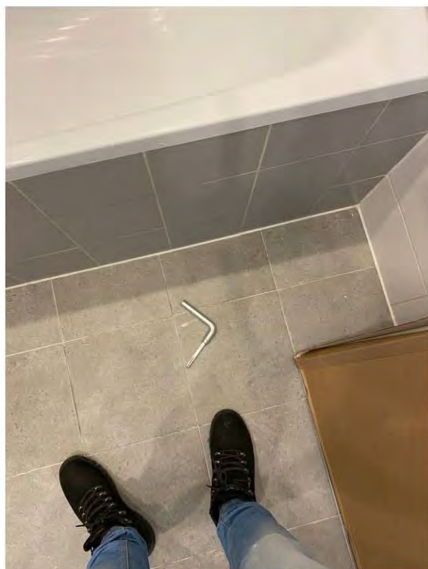
Фото 53, 54. Ванная. 6.4 Изменение характера звука при простукивании плитки (пустоты)
