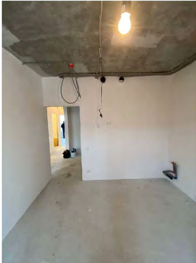
Фото 5. Кухня. Общий вид помещения
