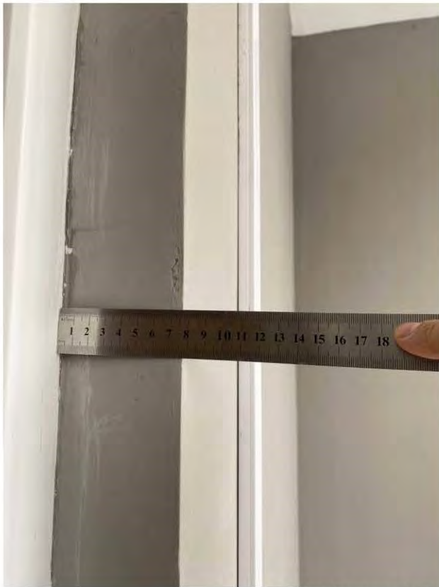
Фото 28, 29. Лоджия. 3.1 Некачественная окраска стен
