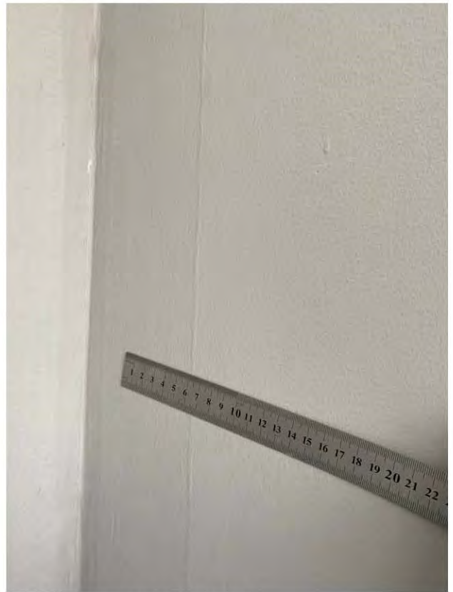
Фото 28, 29. Лоджия. 3.1 Некачественная окраска стен
