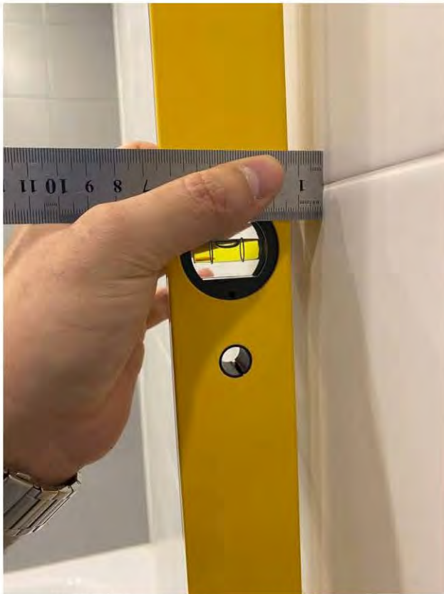
Фото 50, 51. Ванная. 6.2 Отклонение на участках стен из керамической плитки от вертикали 14 мм, 10 мм
