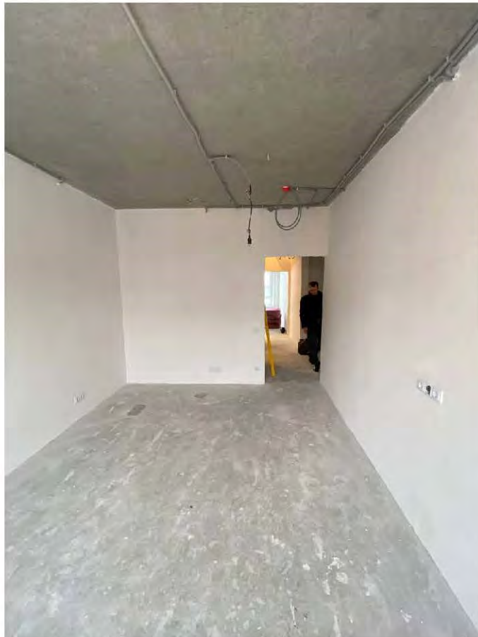
Фото 8. Комната 1. Общий вид помещения.
