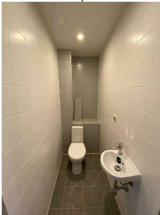
Фото 10. Санузел. Общий вид помещения.
