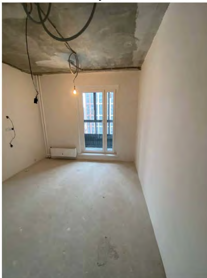
Фото 4. Кухня. Общий вид помещения
