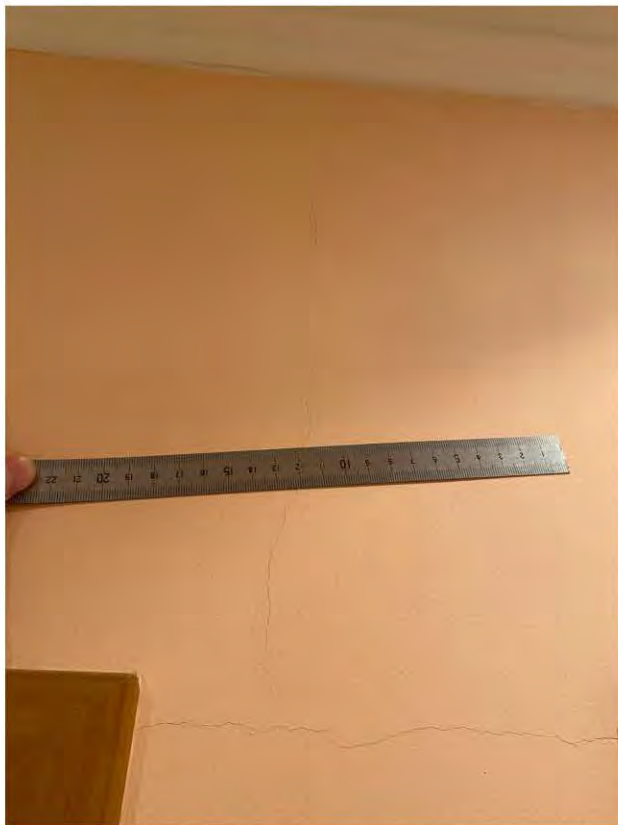
Фото 3, 4. Коридор. Трещины по стене, возникшие в результате залива
