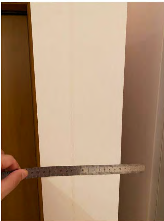
Фото 5, 6. Коридор. Разводы, подтеки по стене после залива
