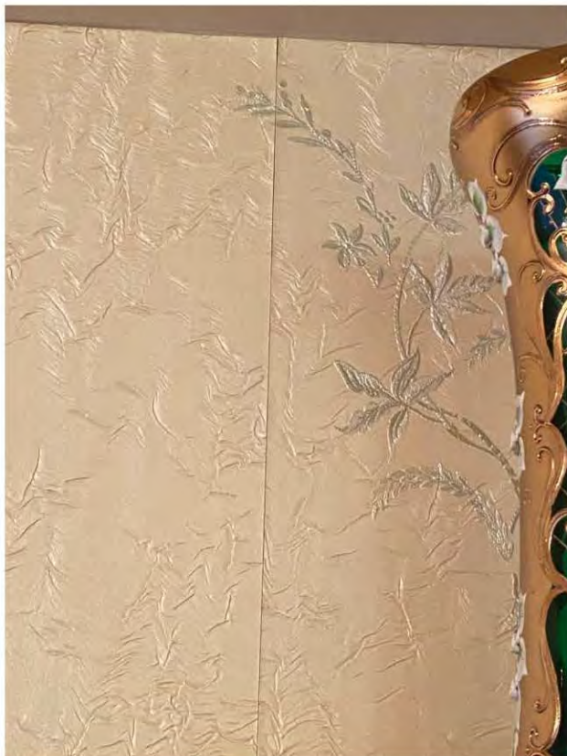
Фото 20, 21. Комната 1. Стены, отслоение обоев
