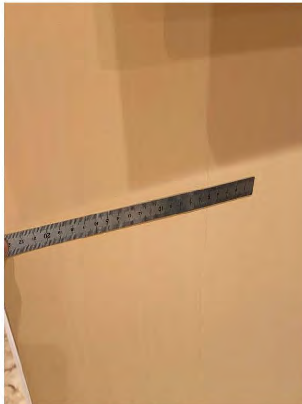
Фото 13, 14. Кухня. Разводы, подтеки по стене после залива
