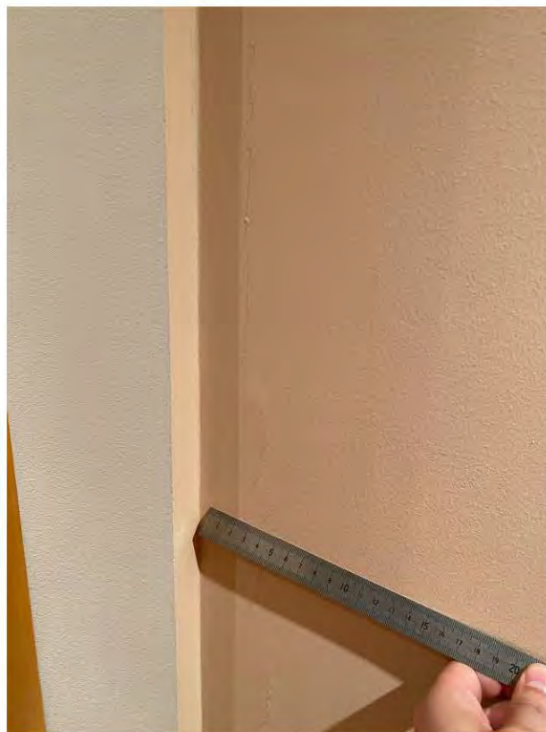
Фото 3, 4. Коридор. Трещины по стене, возникшие в результате залива
