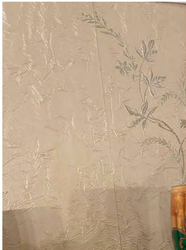
Фото 20, 21. Комната 1. Стены, отслоение обоев
