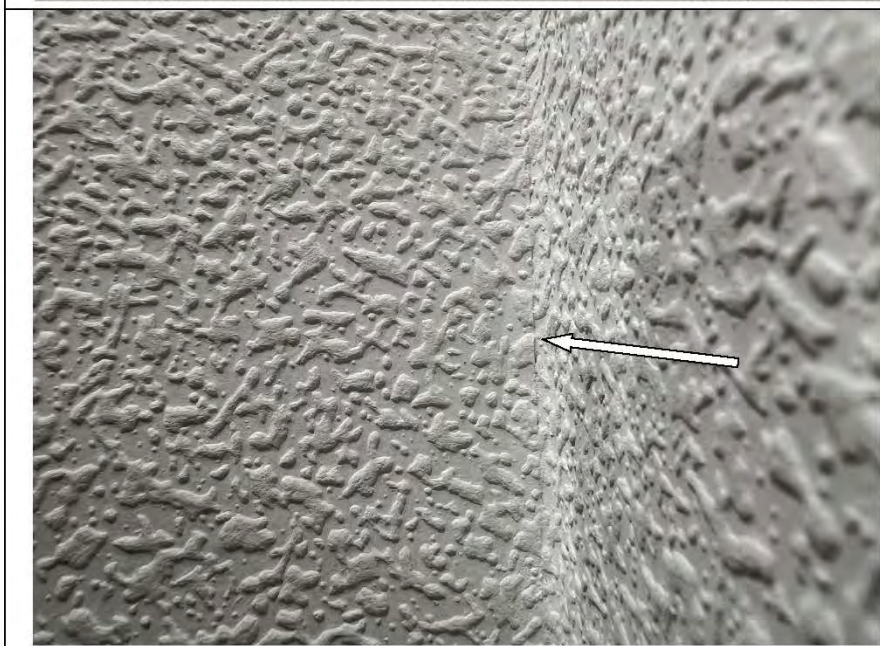
Фото №12. Читаемые обойные стыки в коридоре.
