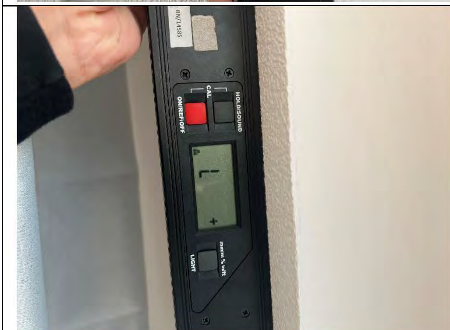
Фото №8. Измерение уровня стен в кухне.
