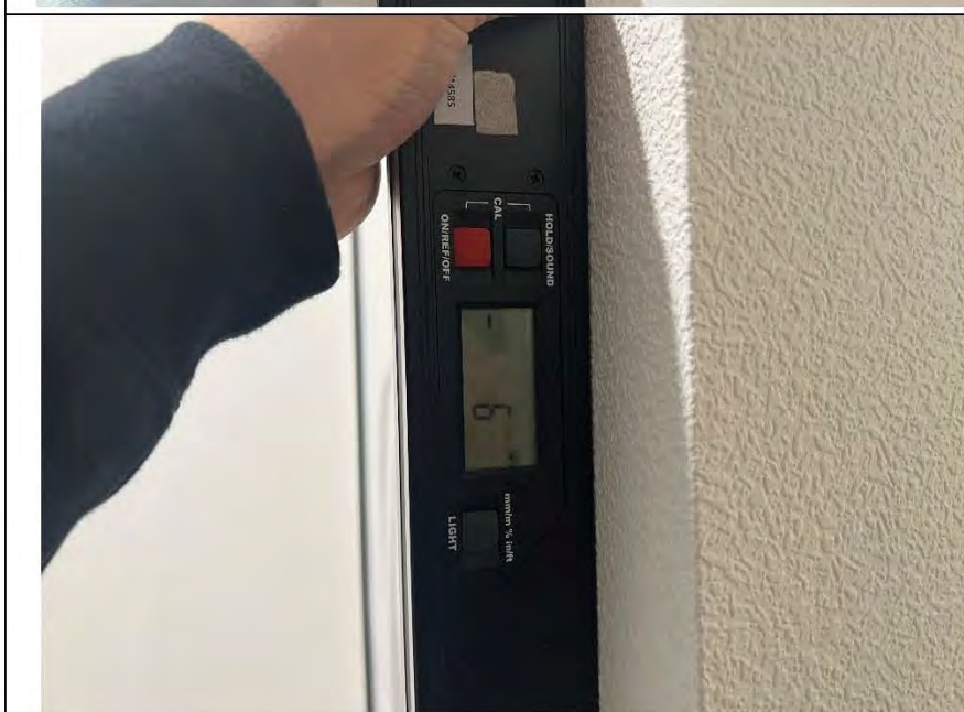
Фото №9. Измерение уровня стен в коридоре.
