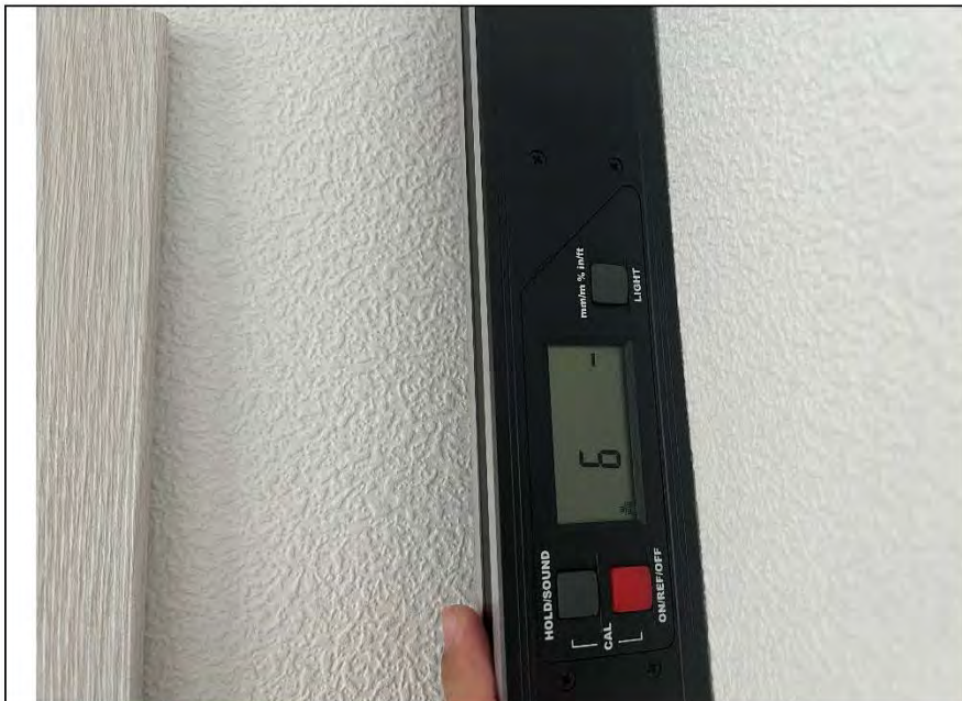
Фото №7. Измерение уровня стен в спальне.
