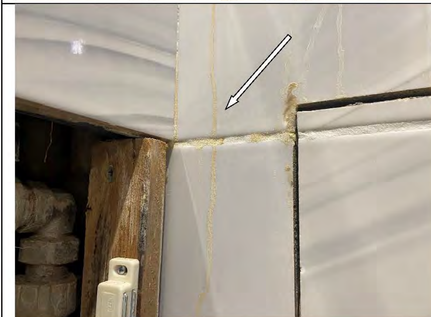
Фото №17. Следы заливия, загрязнения, расслоения, пустоты в швах настенной керамической плитке в санузле в квартире.
