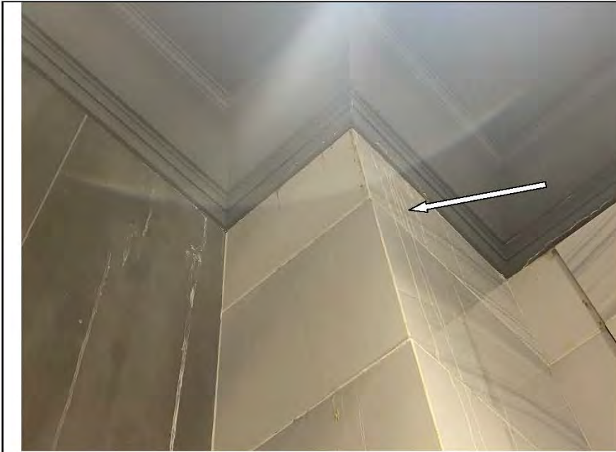
Фото №13. Следы заливия, загрязнения, расслоения, пустоты в швах настенной керамической плитке в санузле в квартире.
