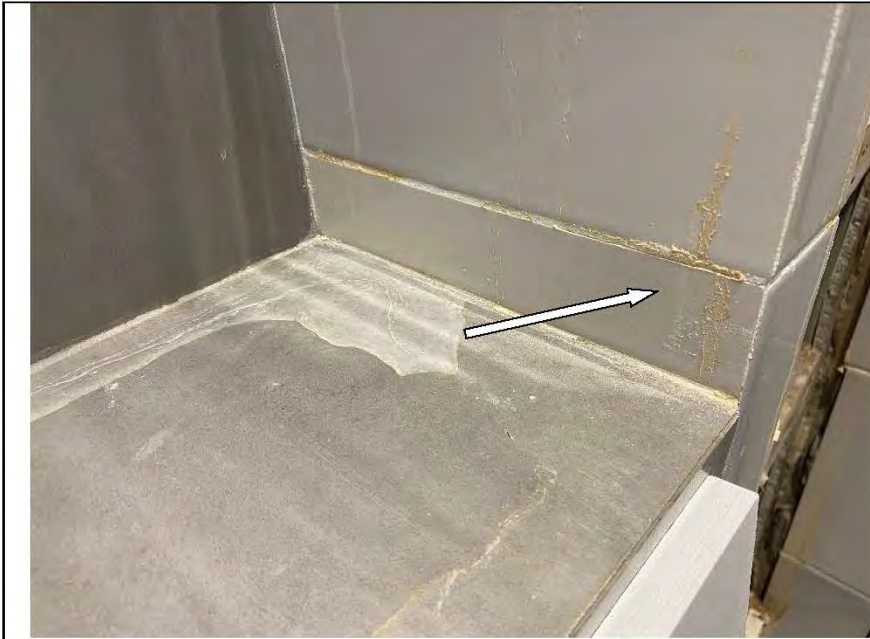
Фото №19. Следы заливия, загрязнения, расслоения, пустоты в швах настенной керамической плитке в санузле в квартире.
