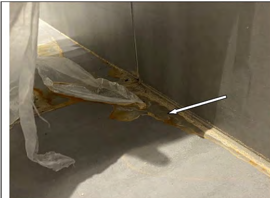
Фото №22. Следы заливия, загрязнения, расслоения, пустоты в швах напольной керамической плитке в санузле в квартире.
