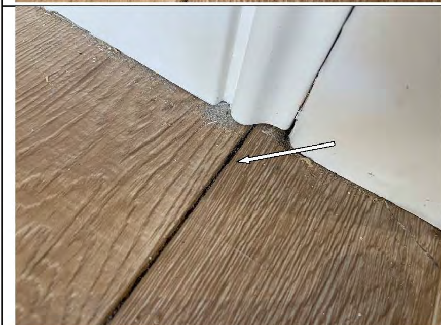
Фото №12. Зазор между досками ламината в результате залива в комнате в квартире.
