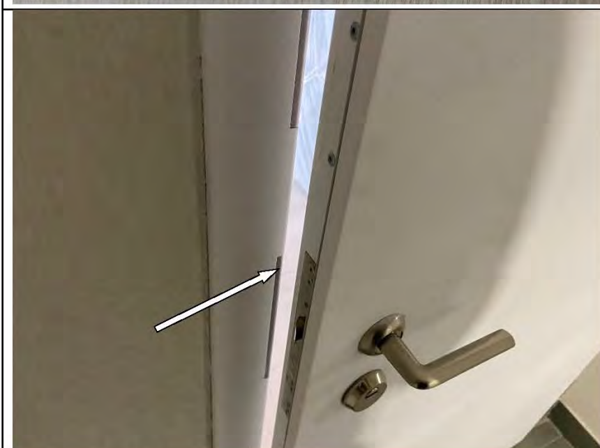
Фото №69. Не закрывается/ открывается свободно входная дверь в прихожей.
