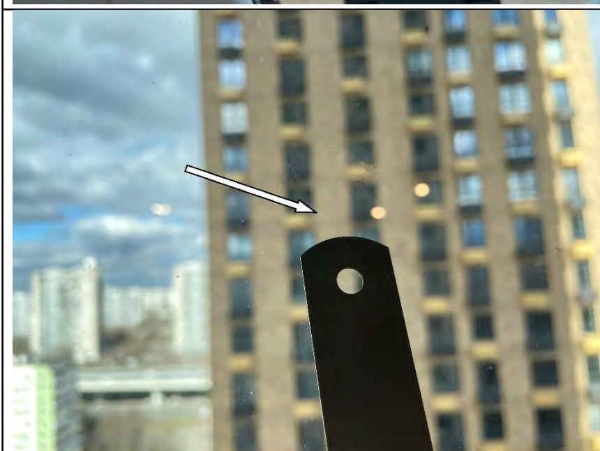
Фото №57. Царапина на стеклопакете оконного блока ПВХ в кухне.
