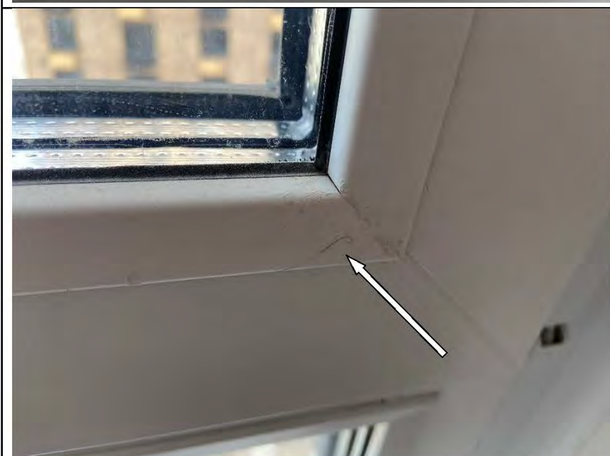
Фото №53. Загрязнения на профиле оконного блока ПВХ в кухне.
