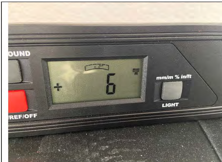
Фото №25. Отклонения напольного покрытия из керамической плитки в кухне.
