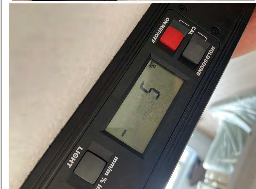
Фото №11. Измерение уровня стен в коридоре.
