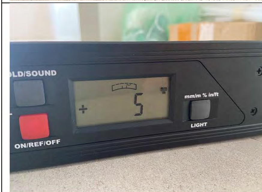
Фото №24. Отклонения напольного покрытия из керамической плитки в прихожей.
