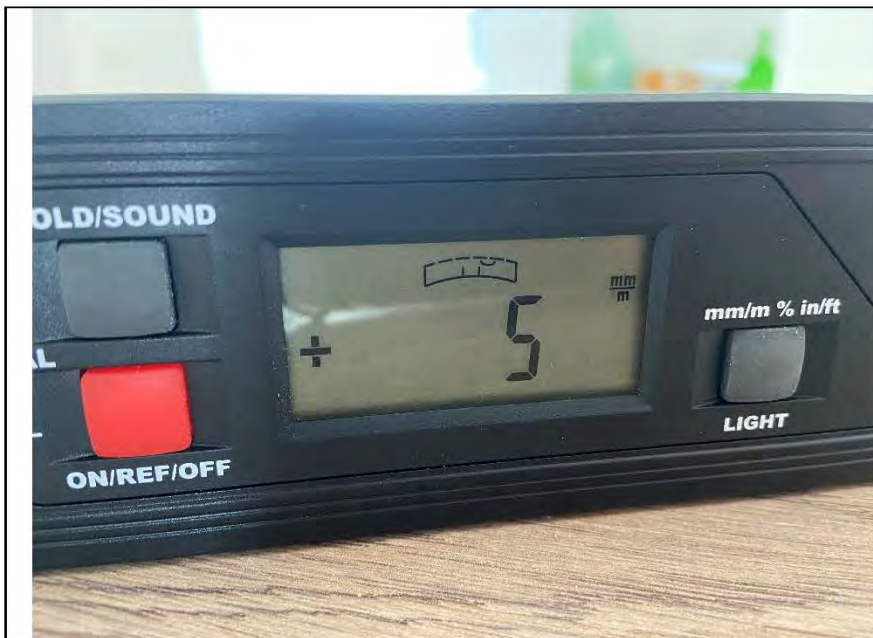
Фото №22. Отклонения напольного покрытия из ламината в спальне.
