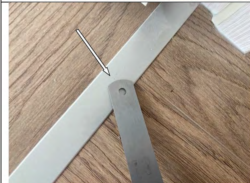
Фото №41. Царапины на напольном металлическом порошке в кабинете.
