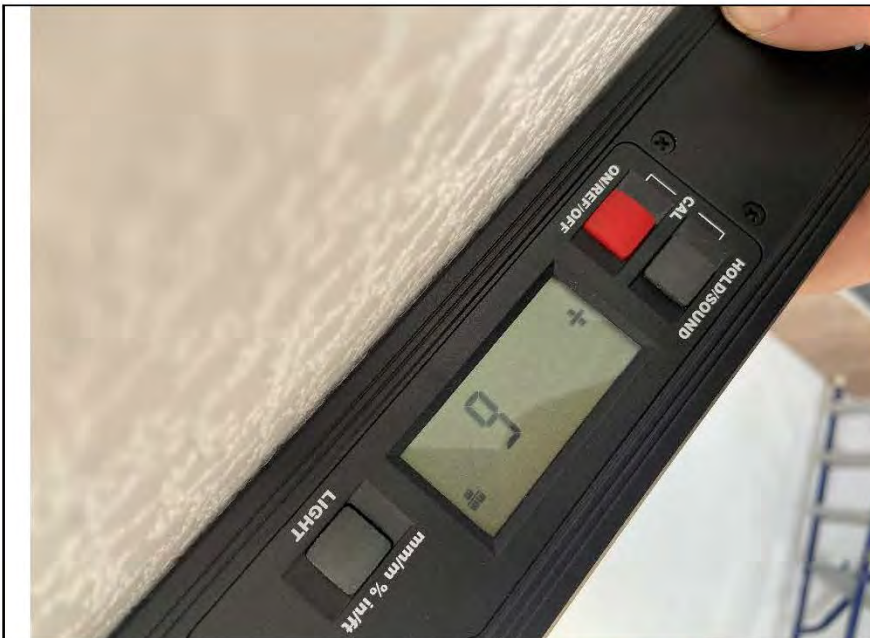
Фото №13. Измерение уровня стен в кабинете.
