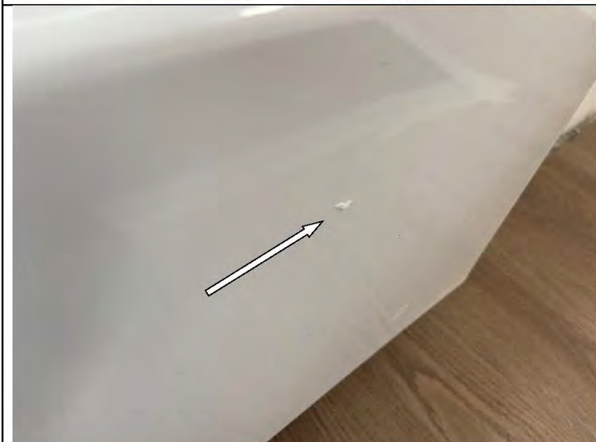
Фото №89. Дефект на металлическом кожухе отопительного прибора в кабинете.
