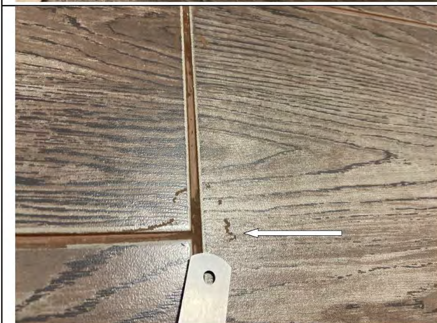
Фото №26. Загрязнения на напольной керамической плитке в санузле.
