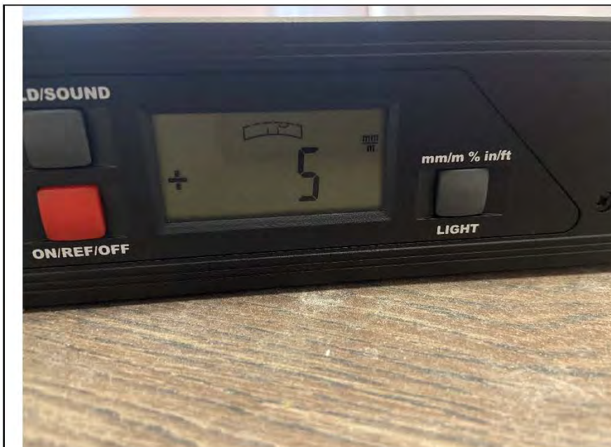
Фото №19. Отклонения напольного покрытия из керамической плитки в санузле.
