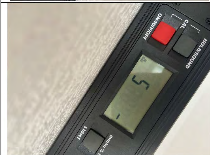
Фото №11. Измерение уровня стен в кабинете.
