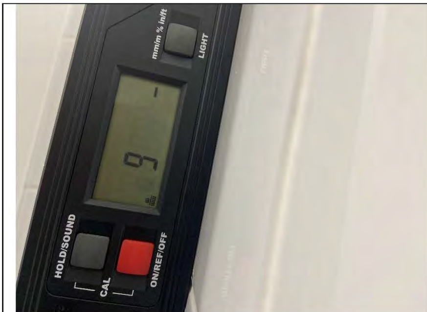
Фото №13. Измерение уровня стен в санузле.
