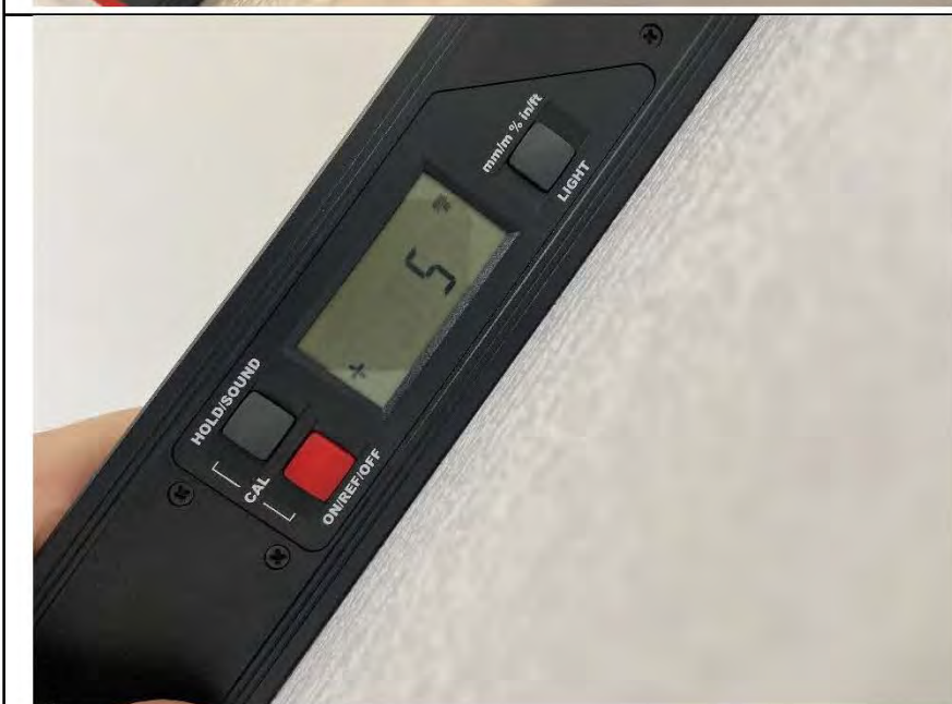
Фото №9. Измерение уровня стен в кухне.
