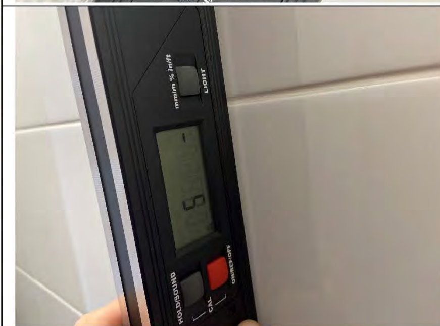
Фото №12. Измерение уровня стен в ванной комнате.
