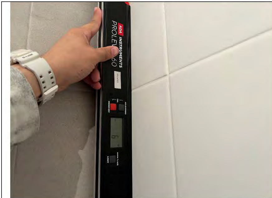
Фото №7. Измерение уровня стен в ванной комнате.
