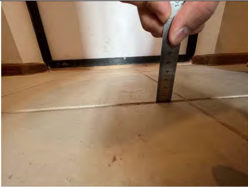
Фото №13. Уступы керамической напольной плитки в коридоре равно 2 мм.
