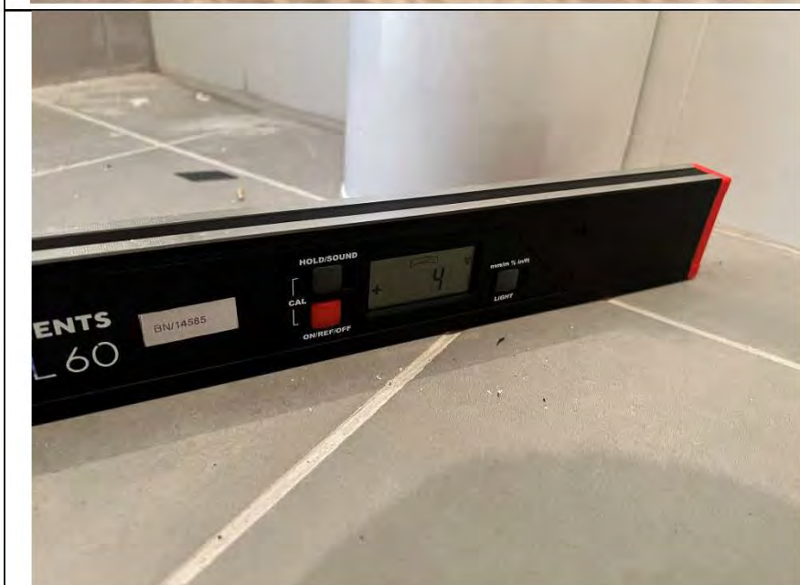
Фото №11. Измерение уровня напольного покрытия в ванной комнате.
