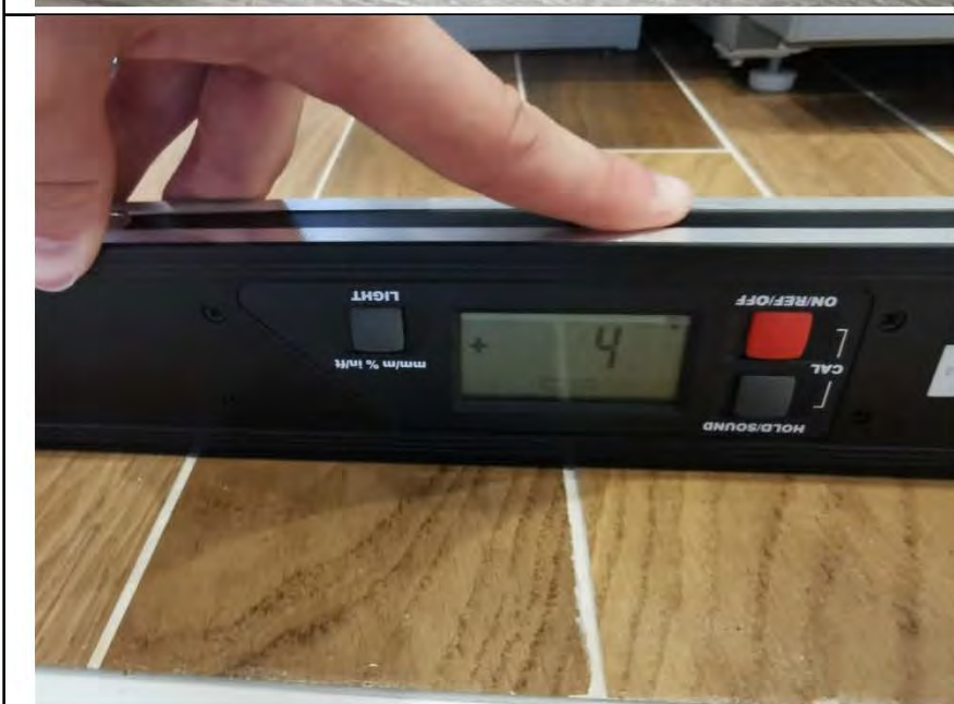
Фото №33. Измерение уровня пола в кухне.
