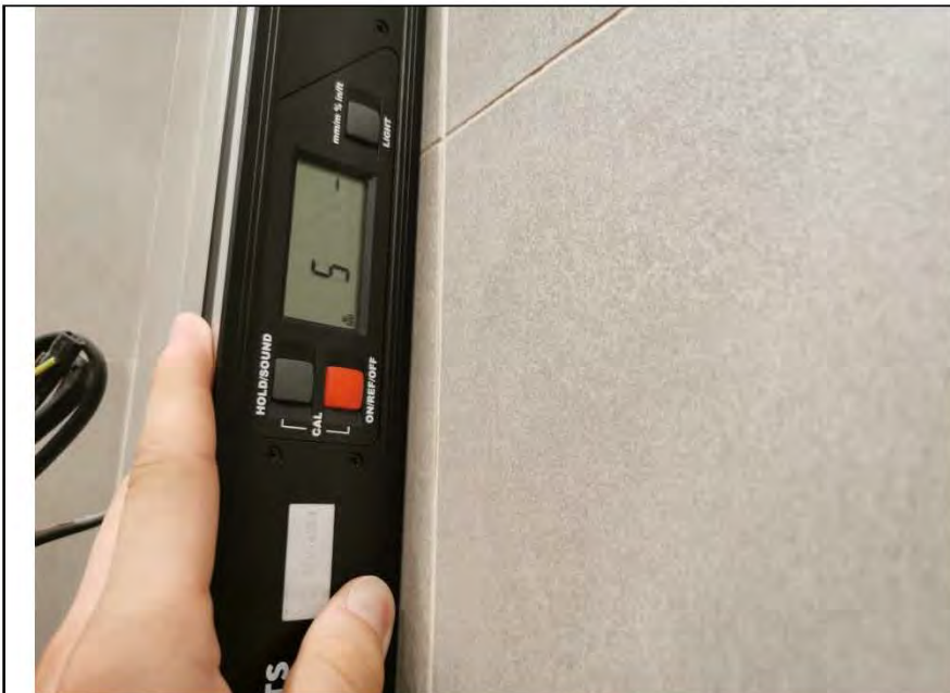
Фото №16. Измерение уровня стен в ванной комнате.
