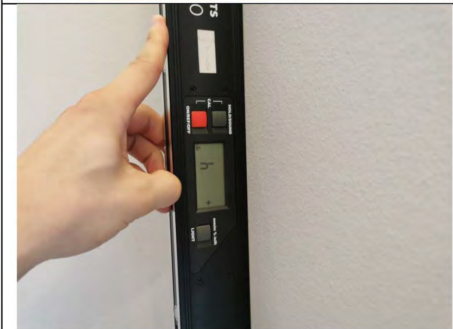
Фото №11. Измерение уровня стен в спальне.
