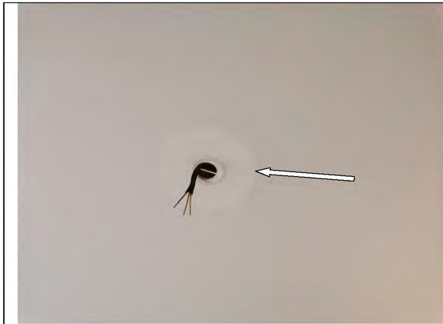
Фото №49. На полотне натяжного потолка в кухне видны инженерные сети.
