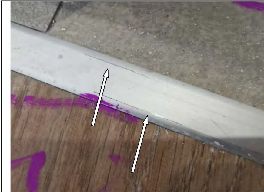
Фото №40. Царапины на металлическом порожке в коридоре.
