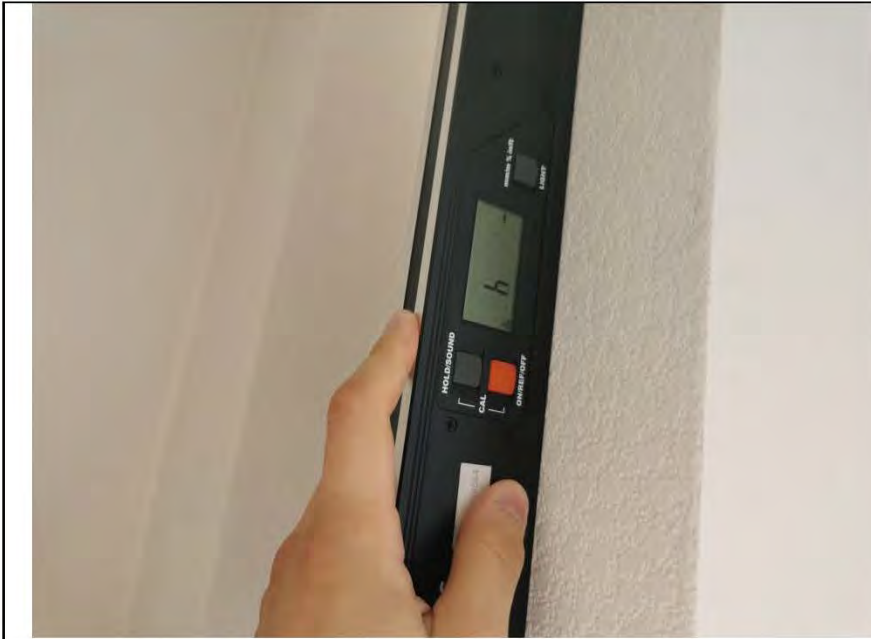
Фото №13. Измерение уровня стен в кухне.
