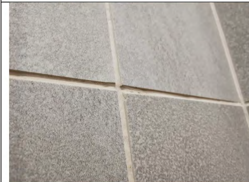
Фото №17. Неполное заполнение шовного пространства настенной керамической плитки затирочным составом в ванной комнате.
