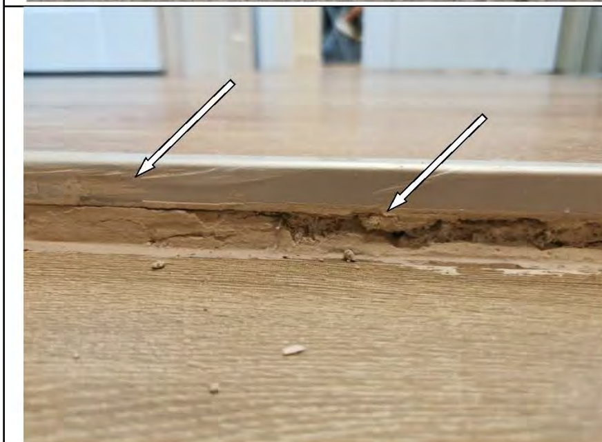
Фото №35. Неполное заполнение шовного пространства затирочным составом на месте стыка плитки и металлического порожка в ванной комнате. Загрязнение металлического порожка.
