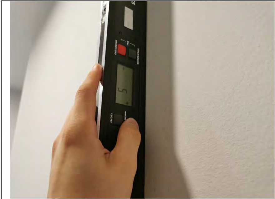
Фото №10. Измерение уровня стен в коридоре.
