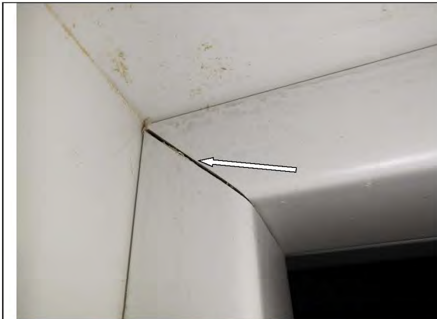
Фото №76. Ненадежное соединение элементов дверного блока (короба) в детской.
