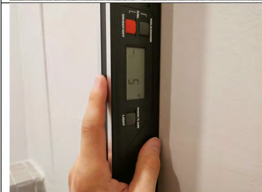
Фото №18. Измерение уровня стен в санузле.
