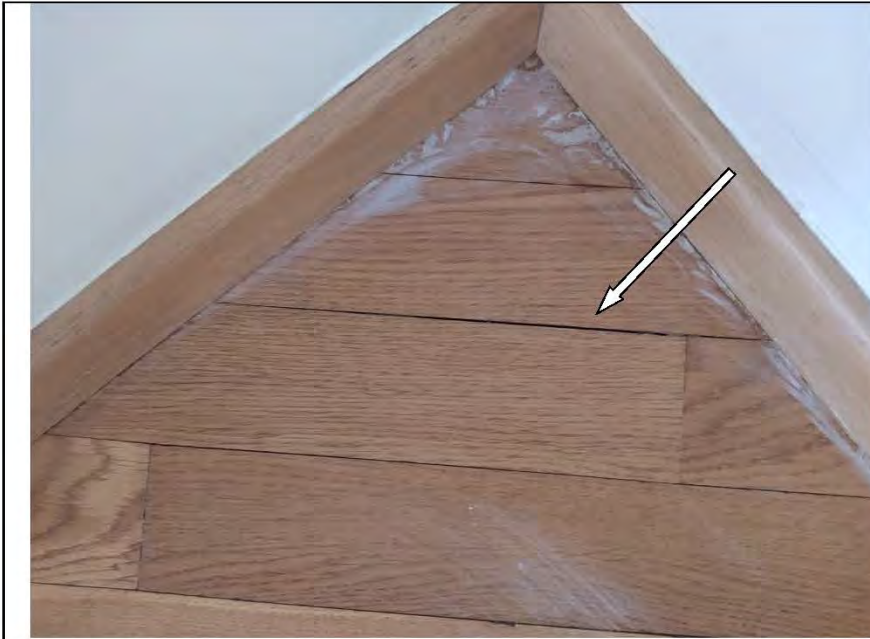
Фото №28. Зазор между соседними досками паркета в зале возникшие в результате залива.
