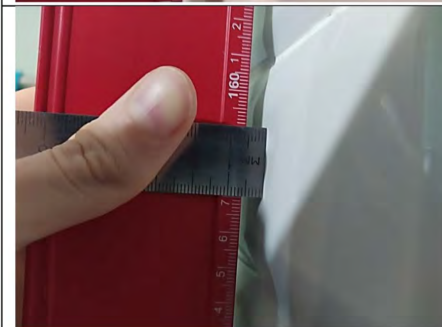
Фото №15. Измерения уровня стен в ванной комнате.
