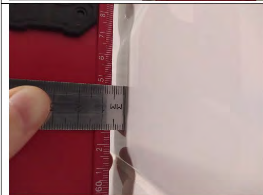
Фото №14. Измерения уровня стен в санузле.
