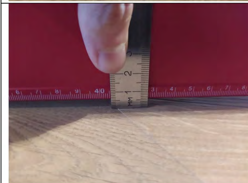
Фото №17. Измерения уровня напольного покрытия в спальне.
