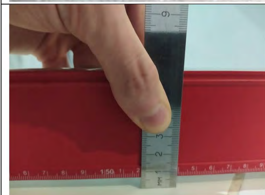
Фото №21. Измерения уровня напольного покрытия в ванной комнате (плитка).
