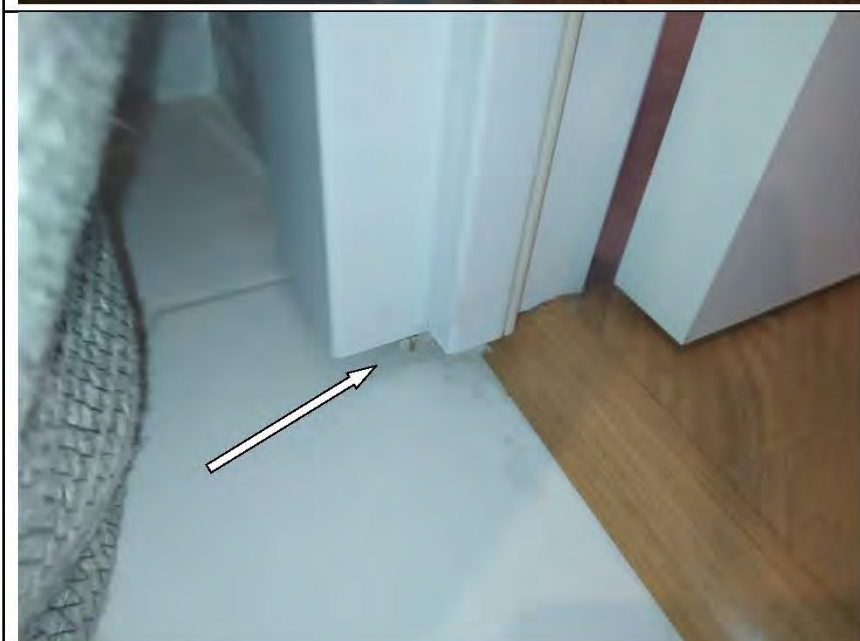
Фото №54. Коротко подрезан наличник деревянного дверного блока в санузле.
