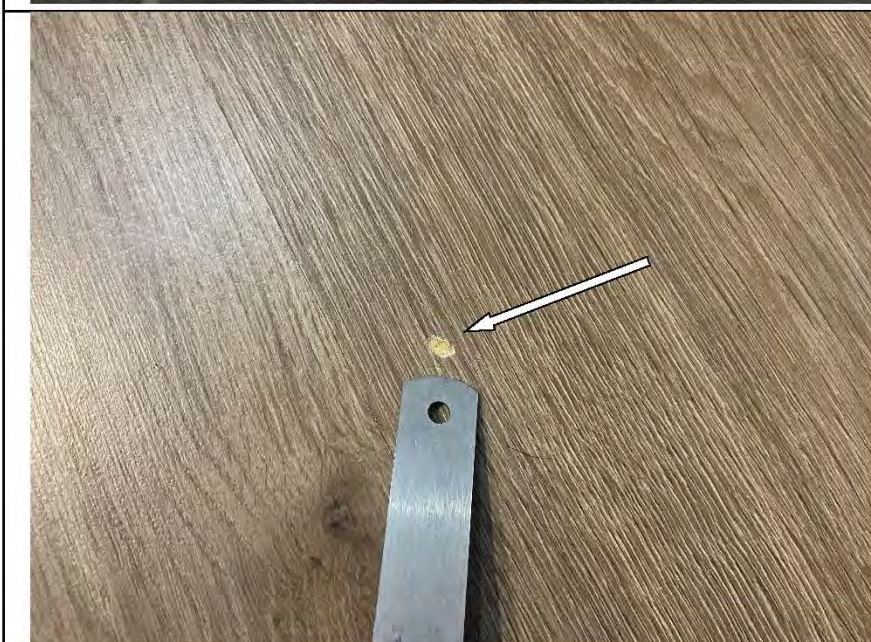
Фото №41. Дефект на напольном покрытии из ламината в коридоре.
