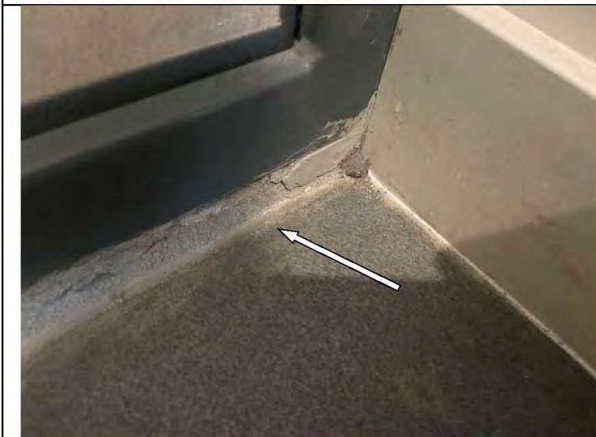
Фото №29. Загрязнения на напольной керамической плитке в коридоре.
