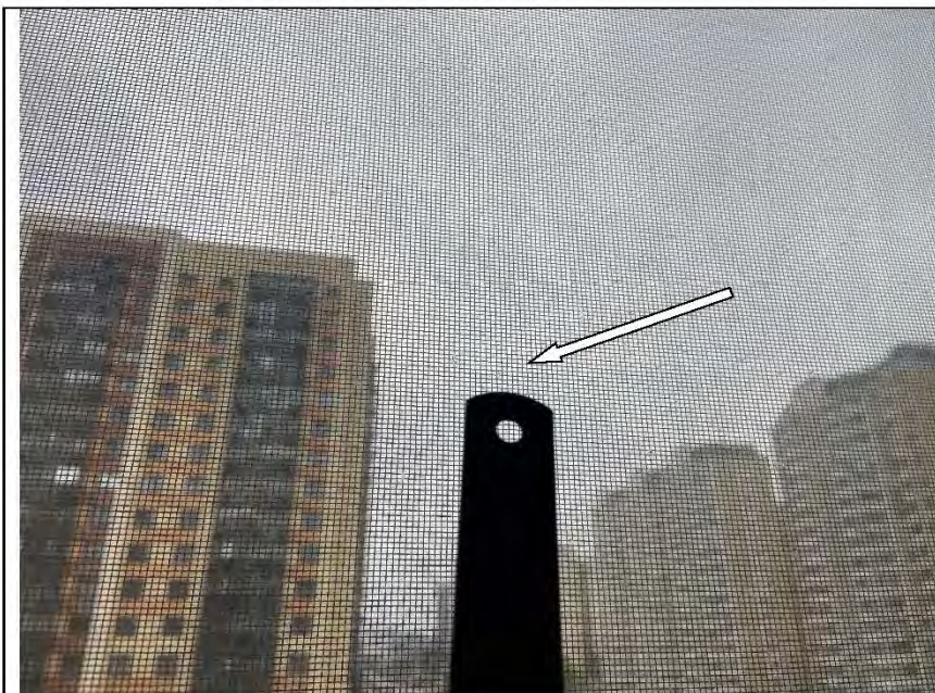
Фото №52. Царапина на стеклопакете оконного блока ПВХ в детской.
