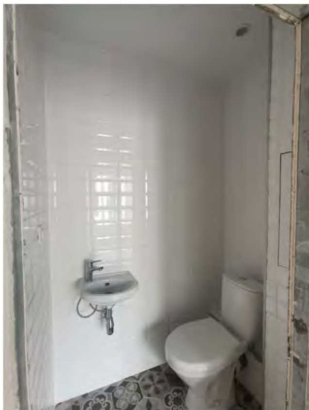
Фото 8. Санузел (1,3 кв.м.). Общий вид помещения.
