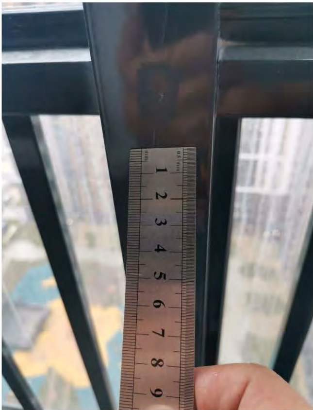
Фото 129-130. Лоджия (4,0 кв.м.) 8.1 Отклонение участка стены от вертикали 10,5 мм
