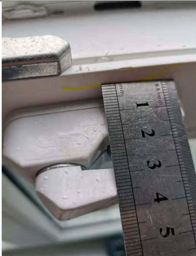
Фото 85-87. Комната 1 (9,8 кв.м.) 5.5 Наличие царапины и сколов на поверхности оконного блока
