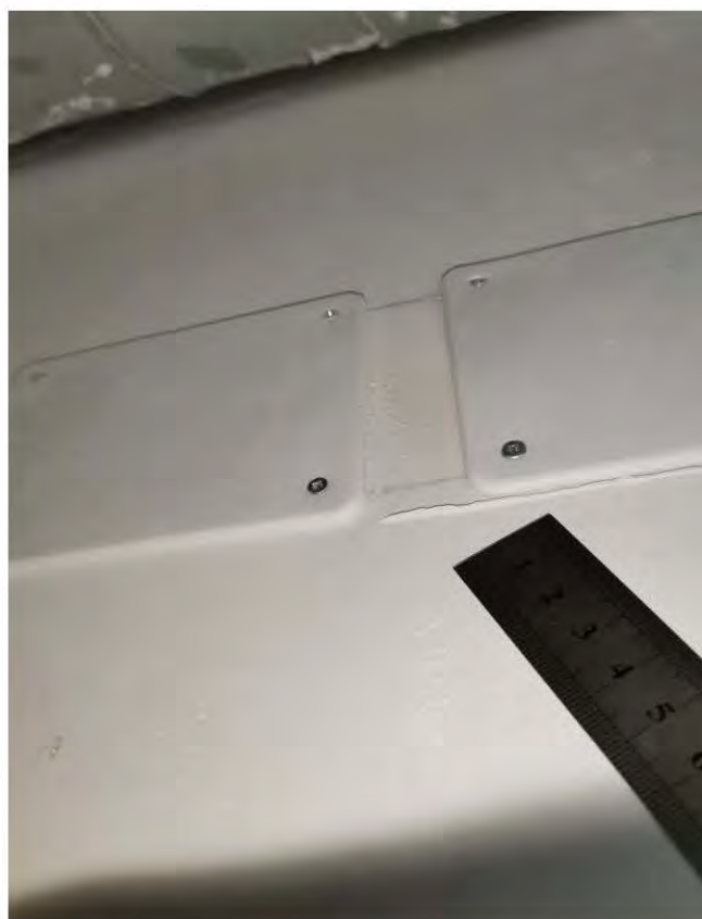
Фото 23-25. Коридор (7,8 кв.м.) 1.2 Некачественная подготовка дверных откосов
