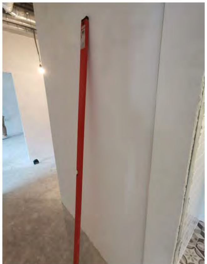
Фото 26-32. Коридор (7,8 кв.м.) 1.3 Некачественная подготовка стен
