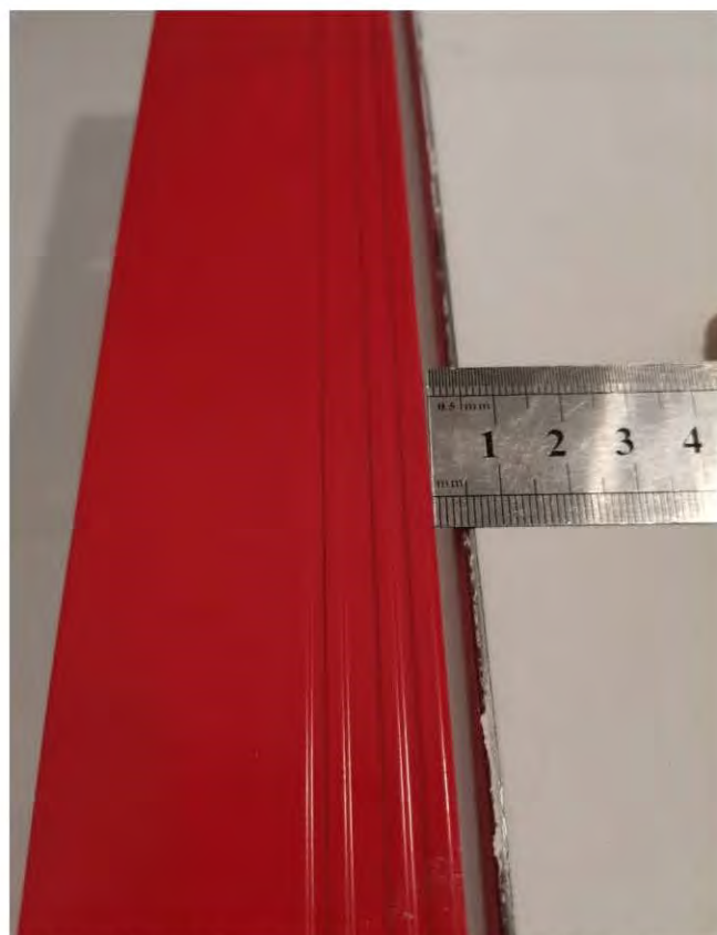
Фото 38-41. Гардеробная (2,1 кв.м.) 2.1 Отклонение участка стены от горизонтали 4,5 мм, 3,5 мм
