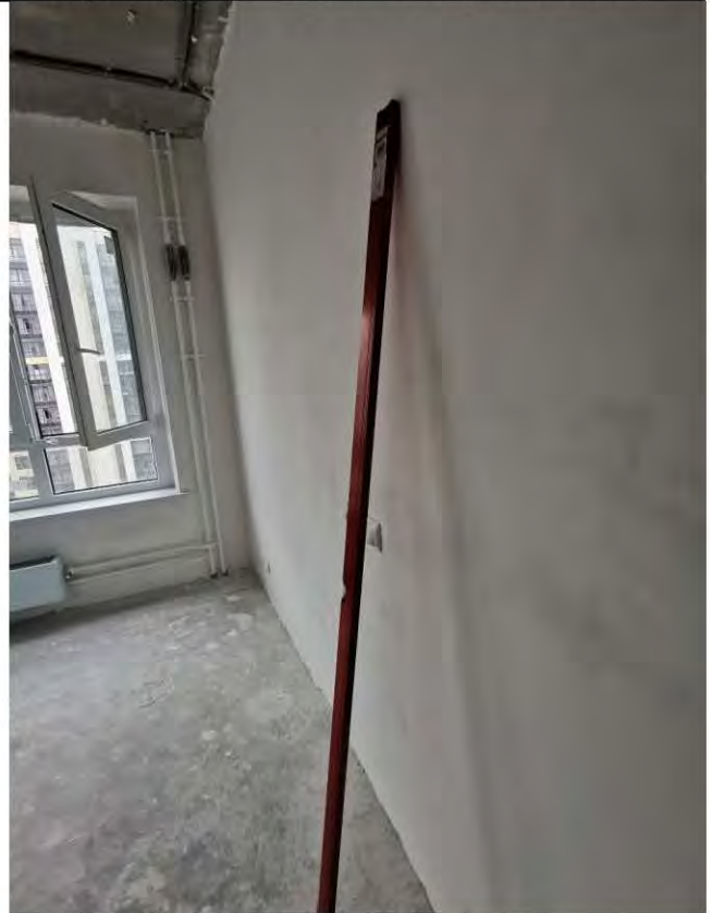
Фото 72-77. Комната 1 (9,8 кв.м.) 5.1 Отклонение участка стены от горизонтали 6,5 мм, 5 мм, 4,5 мм
