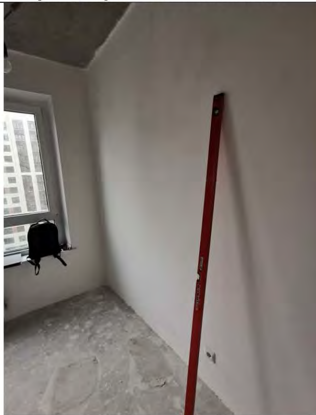
Фото 100-101. Кухня (10,7 кв.м.) 6.2 Отклонение участка стены от вертикали 10 мм
