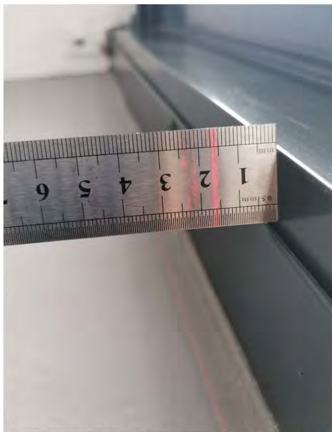
Фото 134-135. Лоджия (4,0 кв.м.) 8.3 Отклонение оконного блока от вертикали 8 мм
