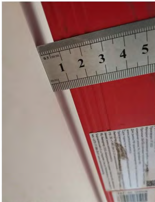
Фото 33-37. Коридор (7,8 кв.м.) 1.4 Отклонение участка стены от горизонтали 4 мм, 5,5 мм, 9 мм
