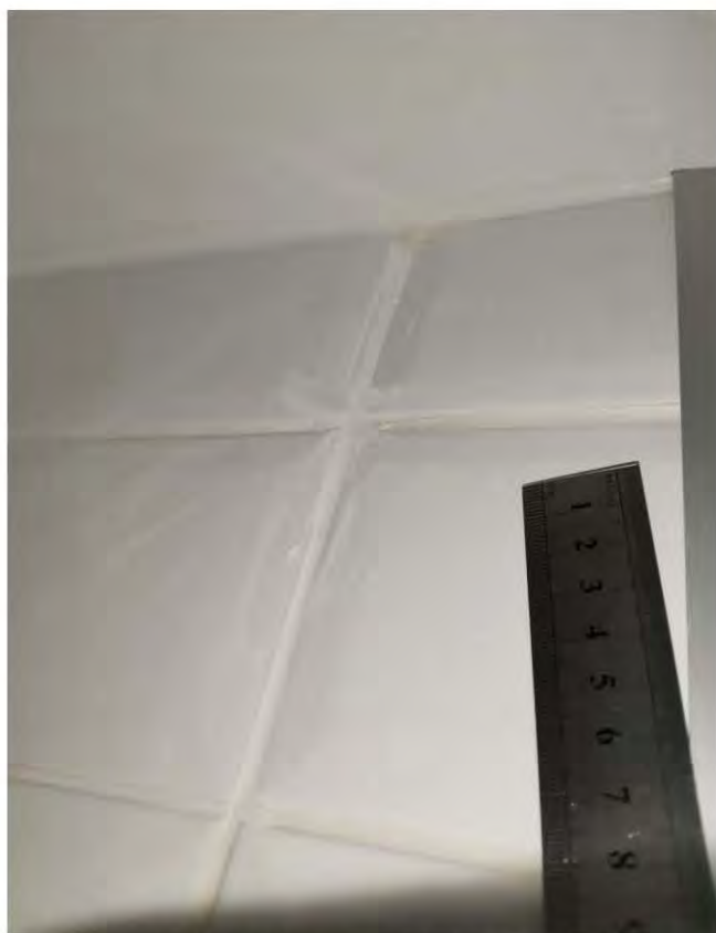
Фото 54-55. Санузел (1,3 кв.м.) 3.4 Некачественная затирка швов на настенной плитке
