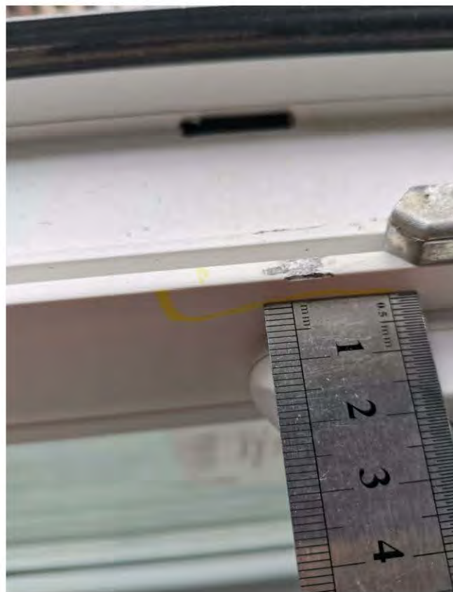
Фото 82-84. Комната 1 (9,8 кв.м.) 5.4 Наличие царапины, загрязнения на стеклопакетах
