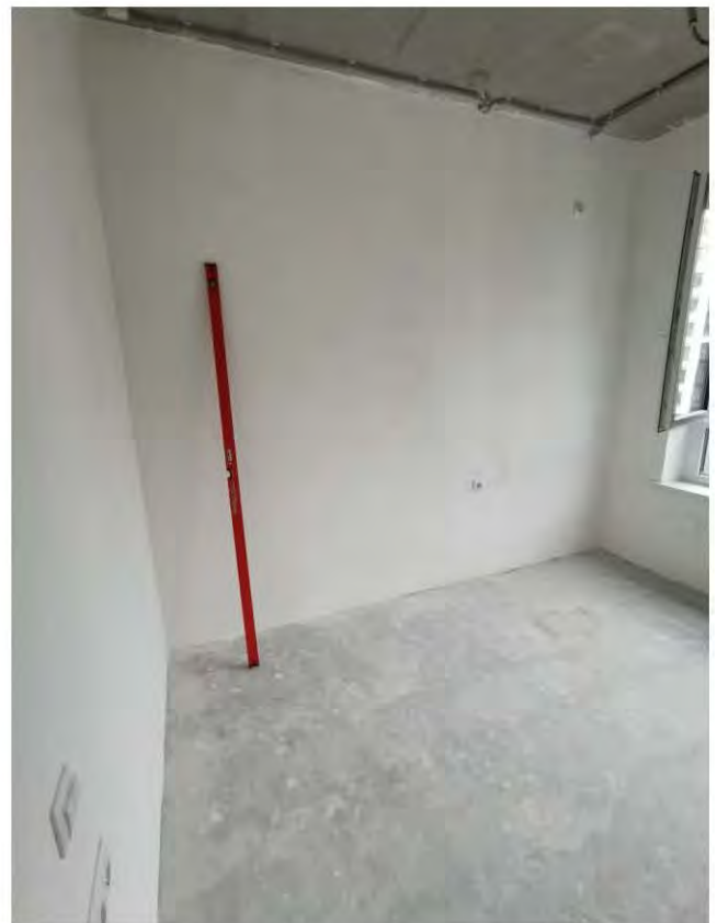
Фото 78-79. Комната 1 (9,8 кв.м.) 5.2 Отклонение участка стены от вертикали 9 мм
