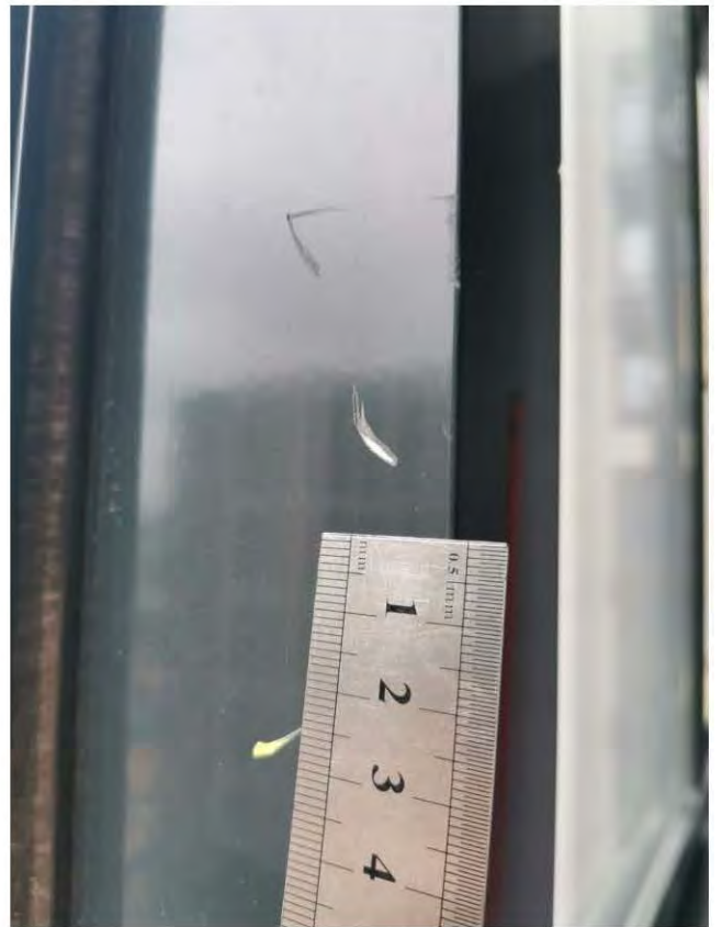
Фото 129-130. Лоджия (4,0 кв.м.) 8.1 Отклонение участка стены от вертикали 10,5 мм
