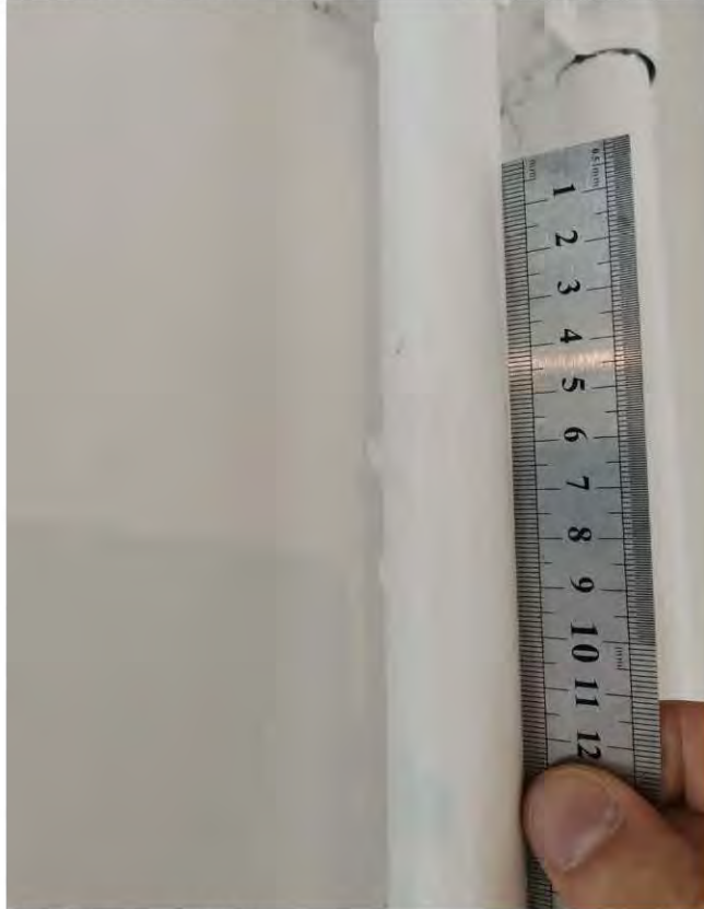
Фото 93. Комната 1 (9,8 кв.м.) 5.8 Некачественная окраска труб отопления: разводы
