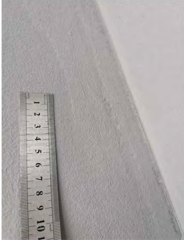
Фото 138. Лоджия (4,0 кв.м.) 8.6 Некачественная подготовка стен
