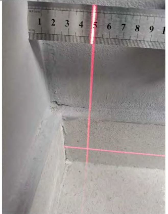
Фото 129-130. Лоджия (4,0 кв.м.) 8.1 Отклонение участка стены от вертикали 10,5 мм
