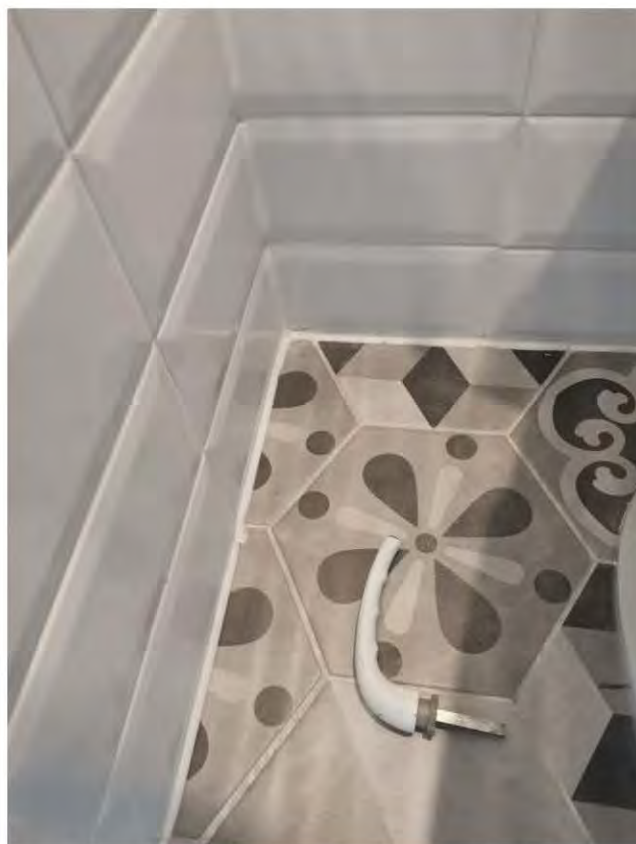
Фото 50-51. Санузел (1,3 кв.м.) 3.2 Изменение характера звука при простукивании плитки (пустоты)
