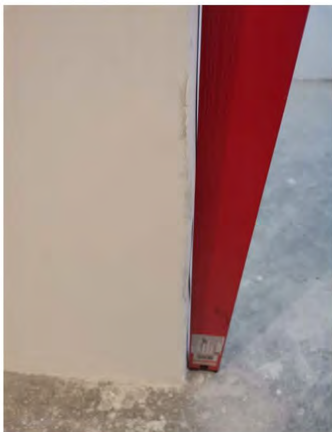
Фото 23-25. Коридор (7,8 кв.м.) 1.2 Некачественная подготовка дверных откосов
