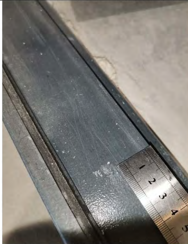
Фото 18-22. Коридор (7,8 кв.м.) 1.1 На входной двери имеются царапины, сколы
