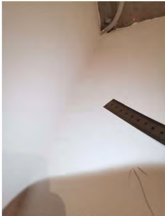
Фото 44. Гардеробная (2,1 кв.м.) 2.3 Некачественная подготовка стен
