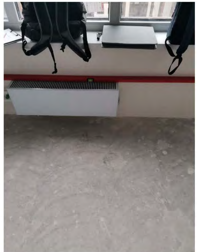
Фото 94-99. Кухня (10,7 кв.м.) 6.1 Отклонение участка стены от горизонтали 5 мм, 6 мм, 4,5 мм
