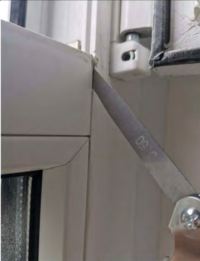
Фото 112-113. Кухня (10,7 кв.м.) 6.9 Зазор 0,5 мм, 0,5 мм между элементами оконного блока
