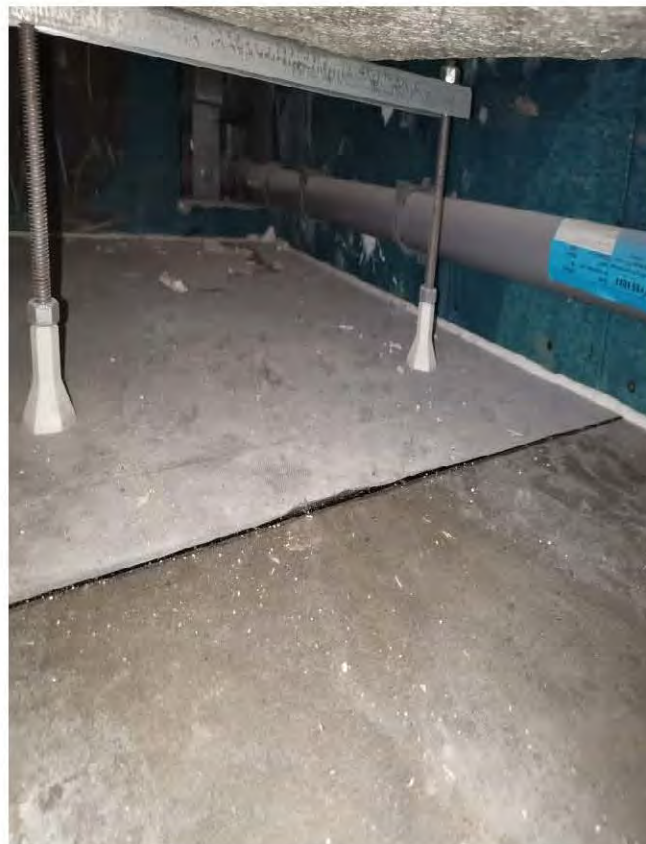
Фото 61-62. Санузел/ванная (3,5 кв.м.) 4.3 Следы коррозии на ножках ванны
