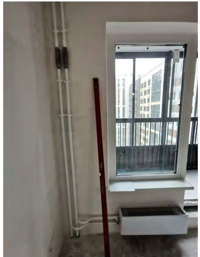
Фото 114-115. Комната 2 (15,5 кв.м.) 7.1 Отклонение участка стены от вертикали 12 мм
