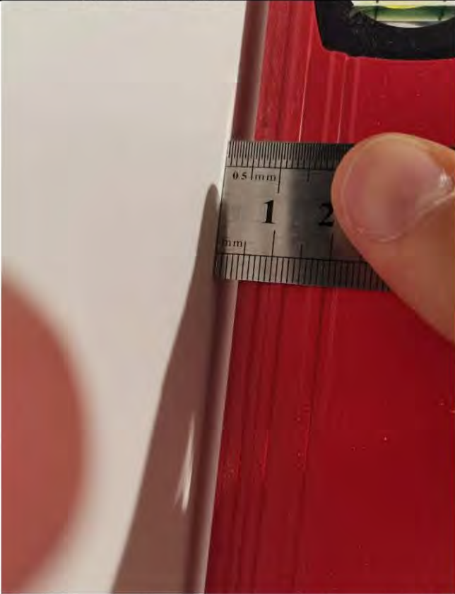
Фото 42-43. Гардеробная (2,1 кв.м.) 2.2 Отклонение участка стены от вертикали 4,5 мм
