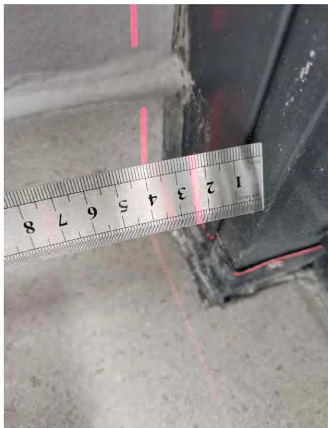
Фото 134-135. Лоджия (4,0 кв.м.) 8.3 Отклонение оконного блока от вертикали 8 мм
