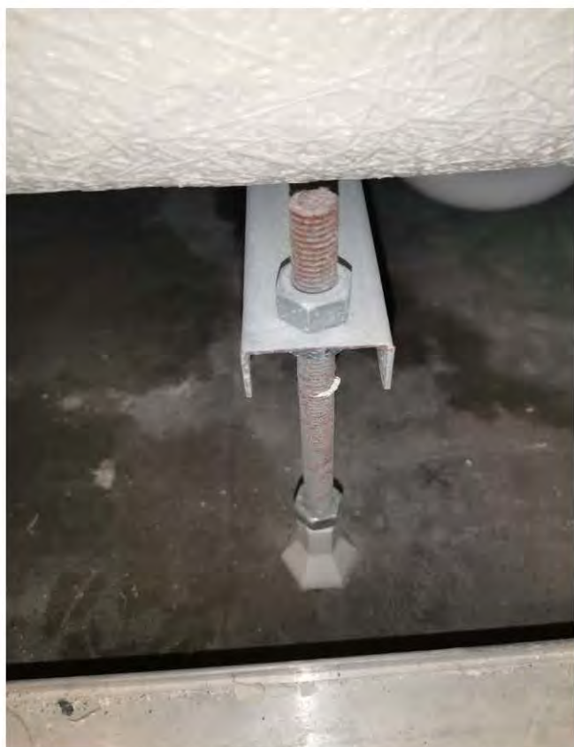
Фото 61-62. Санузел/ванная (3,5 кв.м.) 4.3 Следы коррозии на ножках ванны
