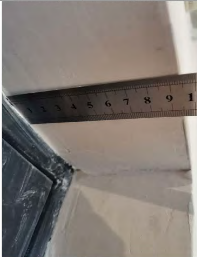
Фото 23-25. Коридор (7,8 кв.м.) 1.2 Некачественная подготовка дверных откосов
