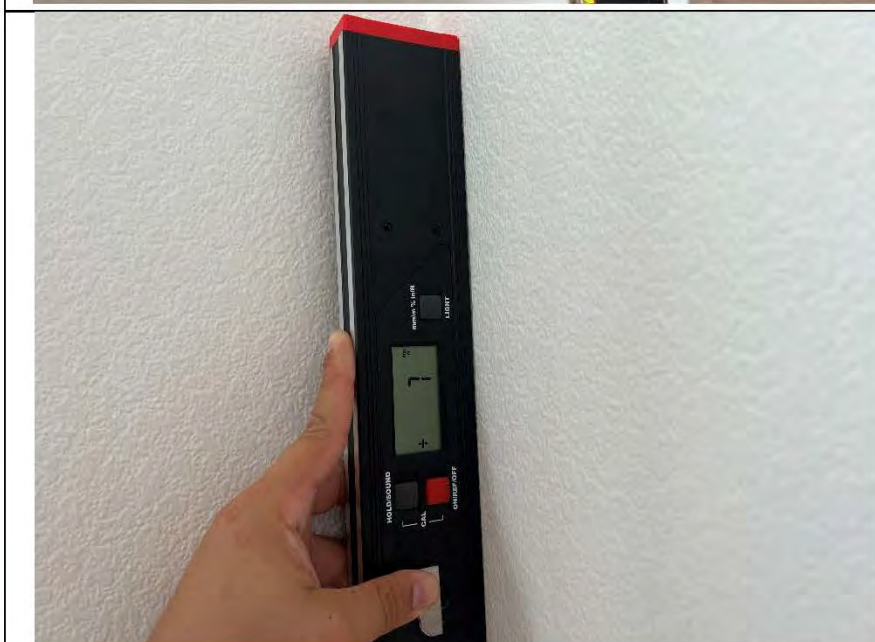
Фото №11. Измерение уровня стен в кухне.
