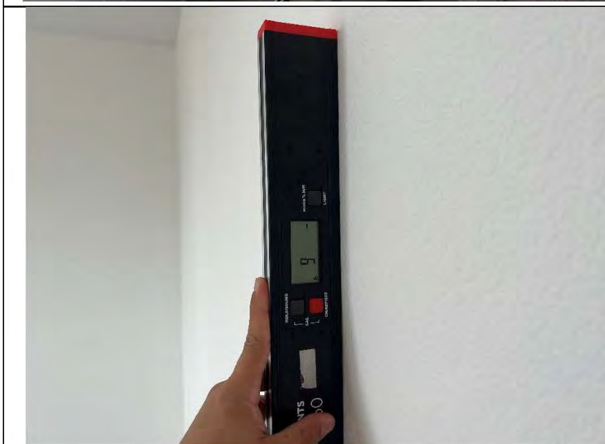
Фото №9. Измерение уровня стен в спальне.
