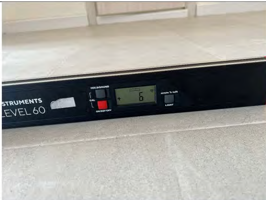
Фото №31. Измерение уровня напольного покрытия в коридоре.
