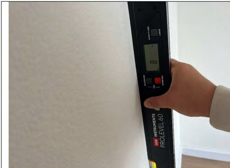
Фото №10. Измерение уровня стен в гостиной.
