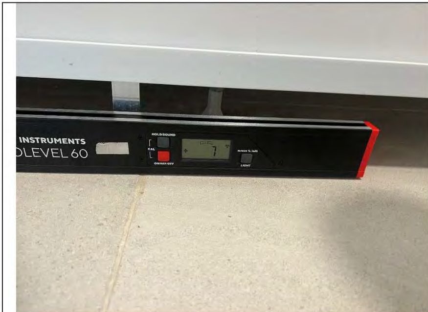
Фото №28. Измерение уровня напольного покрытия в ванной комнате.
