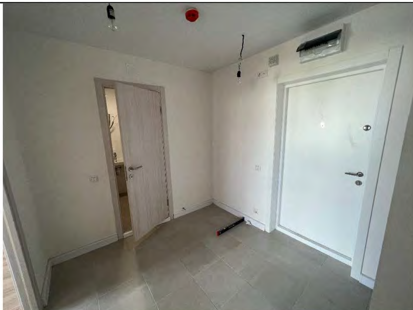
Фото №1. Общий вид коридора.
