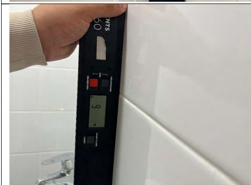
Фото №18. Измерение уровня стен в санузле.
