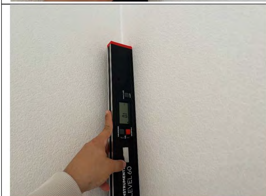
Фото №12. Измерение уровня стен в коридоре.
