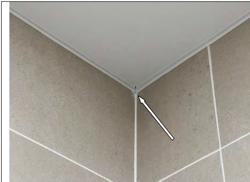
Фото №34. Зазор в стыках декоративного молдинга в ванной комнате.
