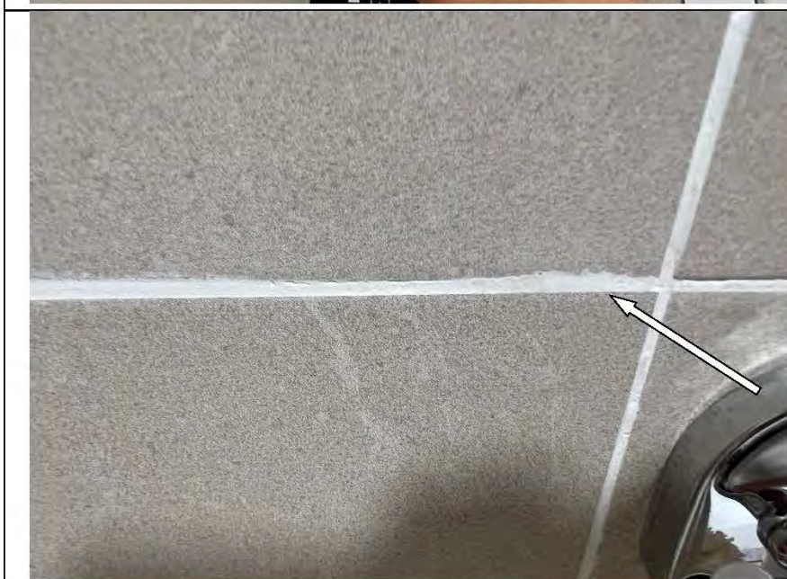
Фото №15. Наплывы затирочного раствора настенной керамической плитки.
