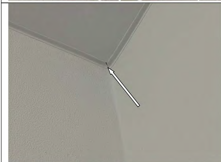
Фото №35. Зазор в стыках декоративного молдинга в кухне.
