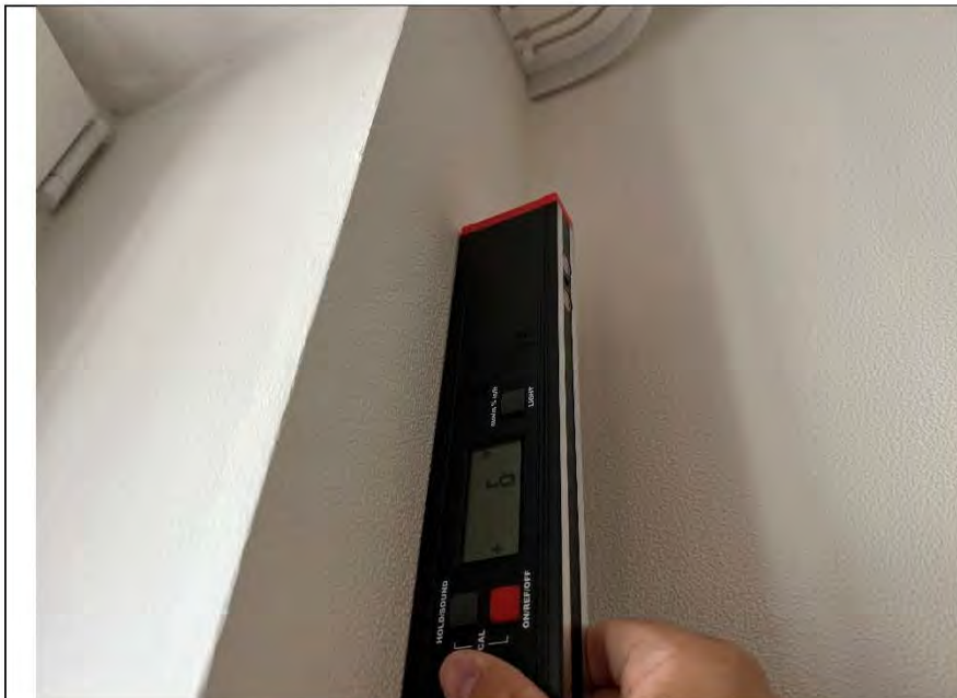
Фото №10. Измерение уровня стен в кухне.
