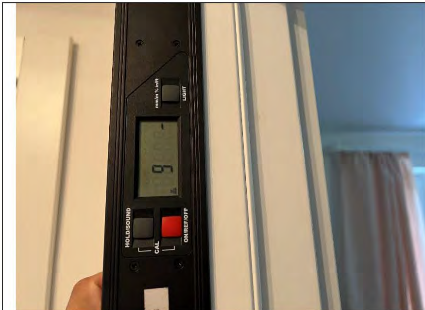
Фото №40. Отклонение коробки от плоскости и прямолинейности дверного блока в кухне равняется 6 мм.
