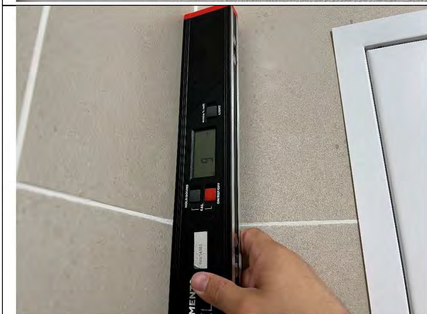
Фото №14. Измерение уровня стен в ванной комнате.
