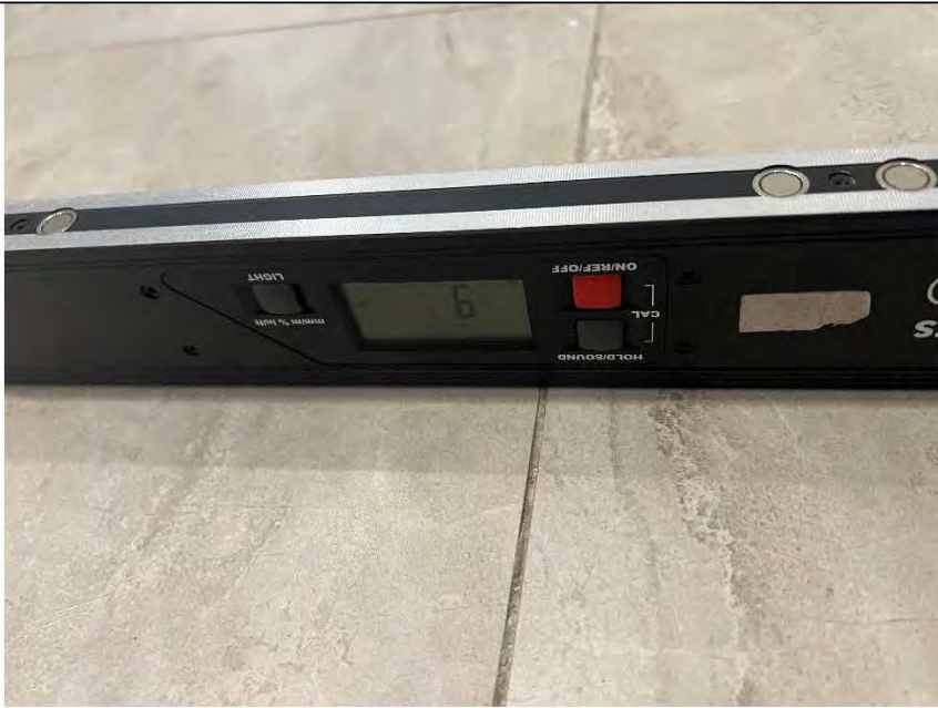
Фото №28. Измерение уровня напольного покрытия в коридоре.
