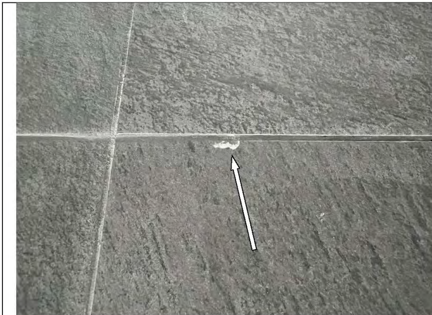
Фото №25. Скол настенной керамической плитки в ванной комнате.
