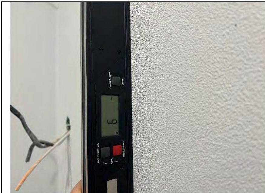
Фото №10. Измерение уровня стен в коридоре.
