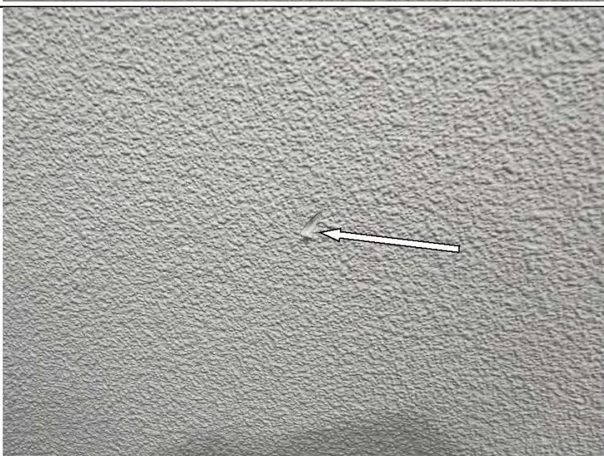
Фото №18. Скол обойного полотна в коридоре.
