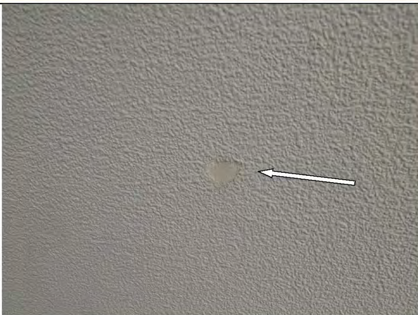
Фото №17. Скол обойного полотна в гардеробной.
