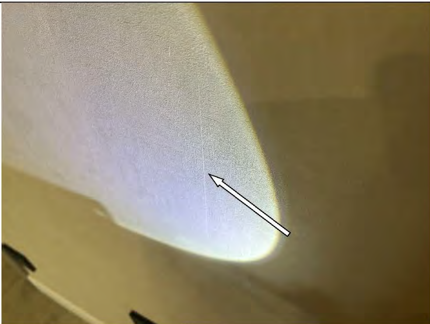
Фото №15. Читаемые обойные стыки в кухне.
