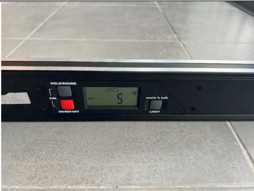
Фото №29. Измерение уровня напольного покрытия на балконе.
