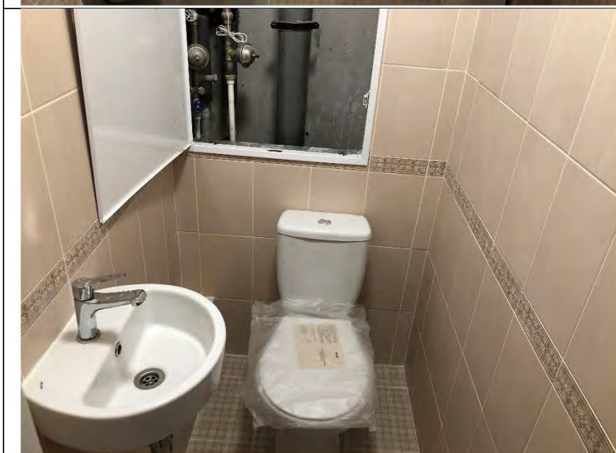
Фото №6. Общий вид санузла в квартире.
