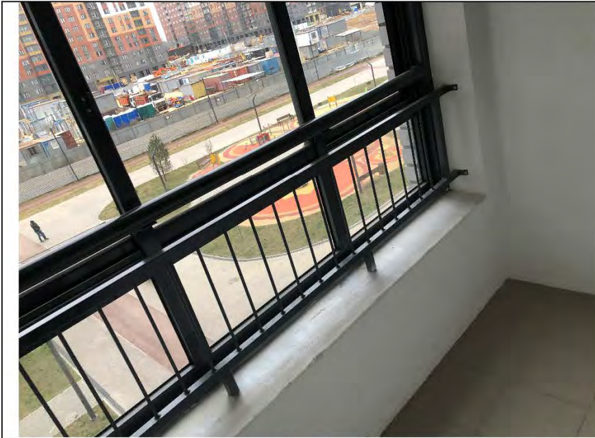
Фото №7. Общий вид лоджии в квартире.
