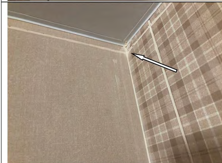
Фото №53. Загрязнение настенной керамической плитки в ванной комнате в квартире.
