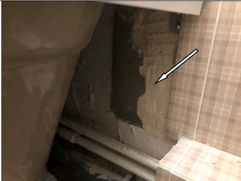
Фото №61. Частично не хватает настенной керамической плитки в ванной комнате в квартире.
