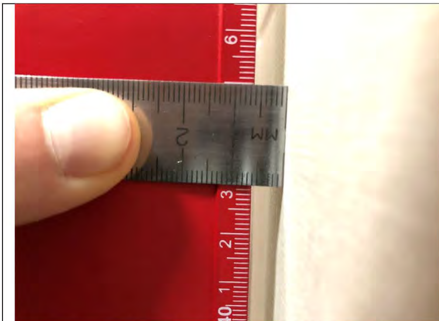
Фото №70. Измерение стен санузла в квартире.
