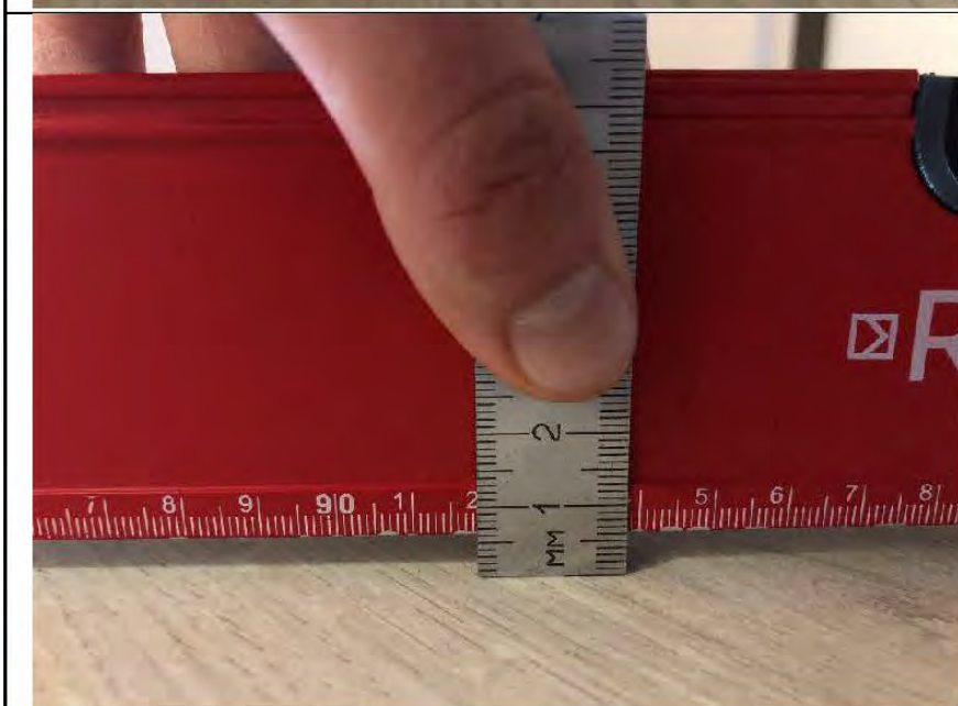
Фото №15. Измерение напольного покрытия коридора в квартире.
