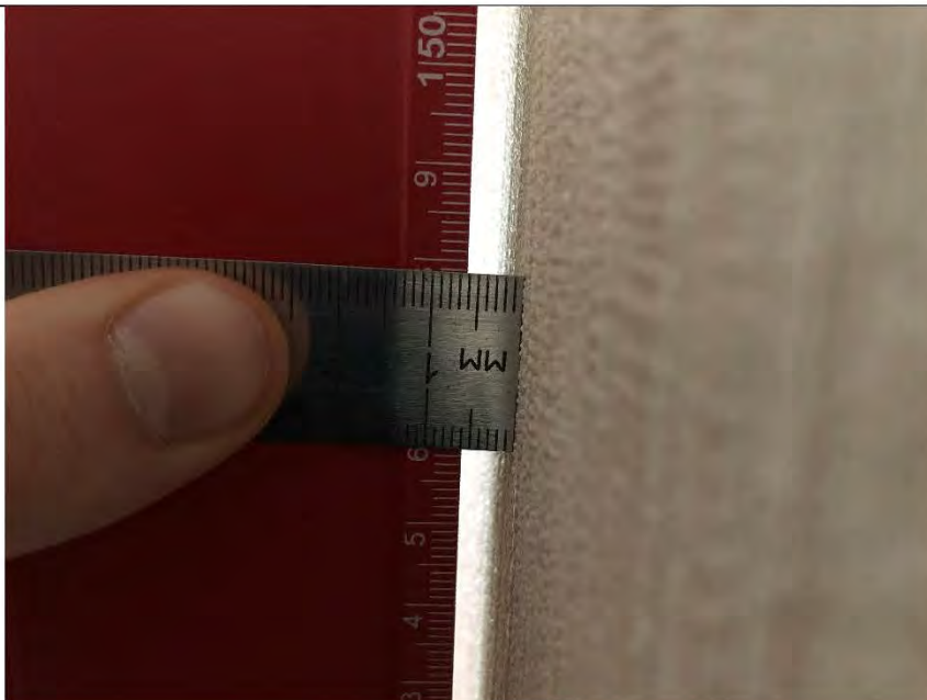
Фото №10. Измерение стен кухни в квартире.
