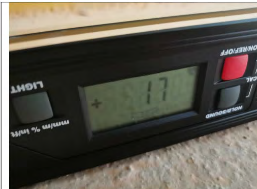
Фото №16. Измерение уровня пола в ванной комнате.
