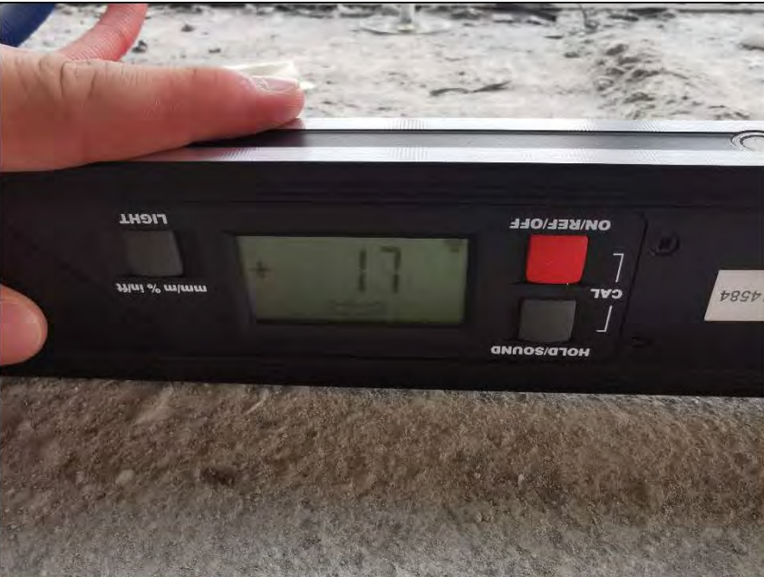
Фото №14. Измерение уровня пола в кухне.
