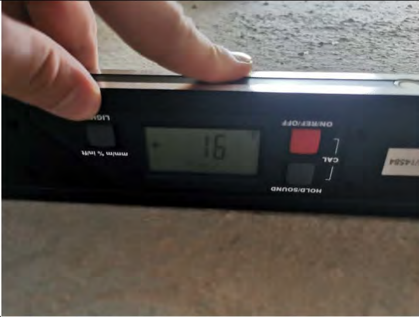
Фото №13. Измерение уровня пола в первом санузле.
