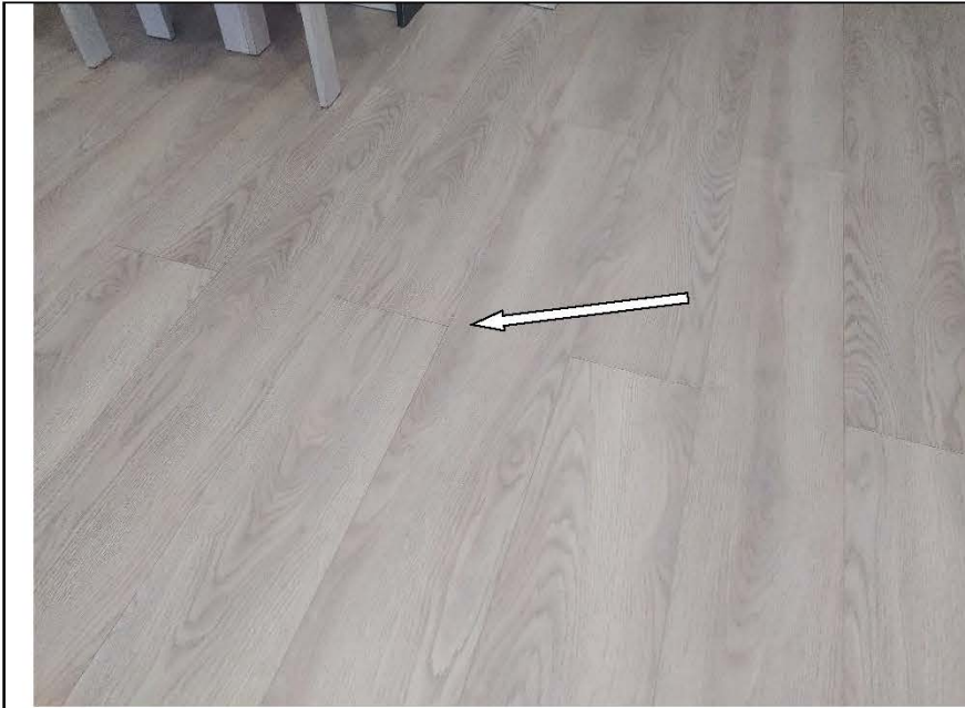
Фото №7. Вздутие ламината характерное последствием залива в прихожей.
