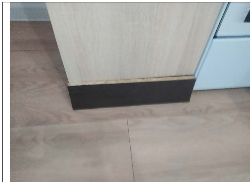
Фото №1. Общий вид ЛДСП панелей цоколя кухонного гарнитура.
