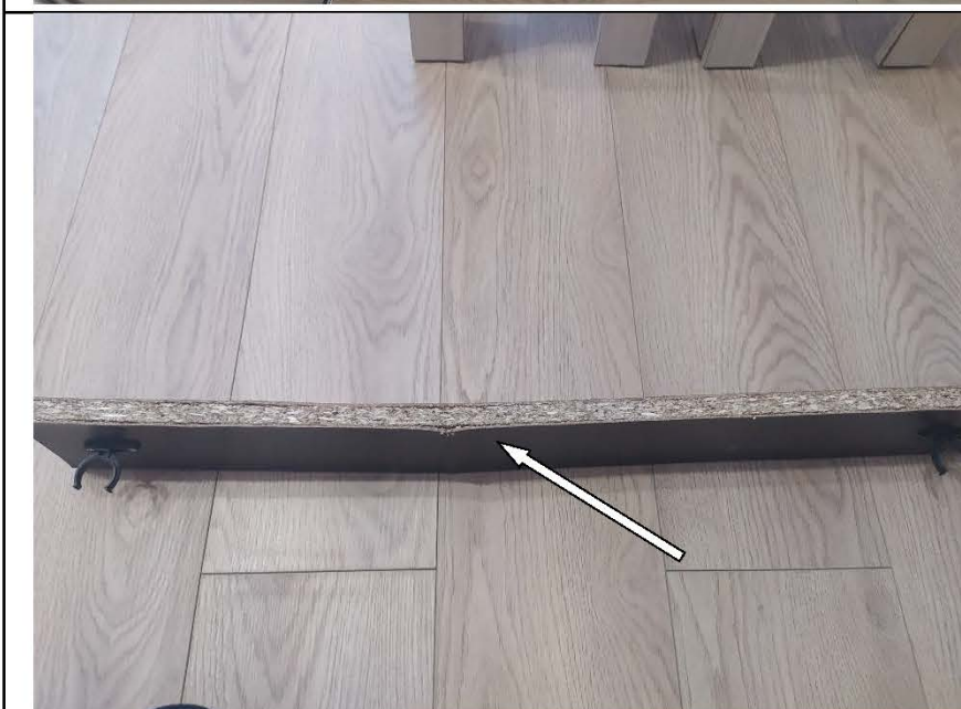
Фото №8. Набухание, отслоение ламинации на ЛДСП панелях цоколя кухонного гарнитура характерные последствиям залития.
