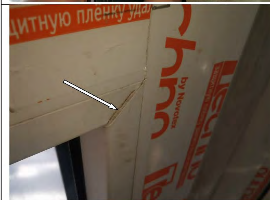
Фото №24. Зазоры в месте стыка профилей ПВХ оконного блока в гостиной.
