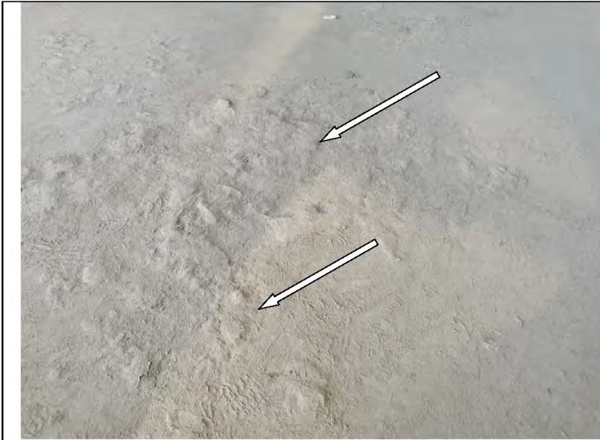
Фото №13. Железобетонные элементы конструкции пола в гостиной имеют дефекты (отсутствие однородности внешнего вида).
