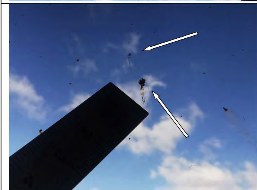
Фото №42. Окалины на стеклопакете оконного блока ПВХ на лоджии.
