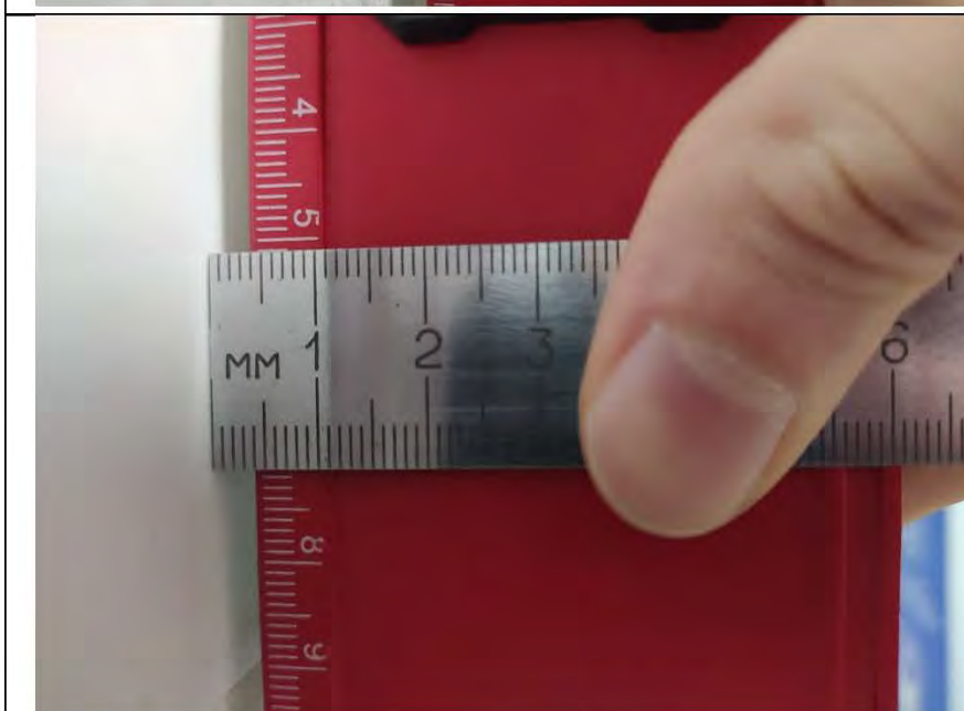
Фото №11. Измерения уровня стен в санузле.
