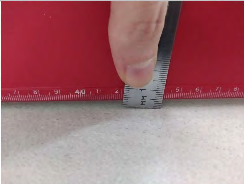
Фото №14. Измерения уровня напольного покрытия в прихожей.
