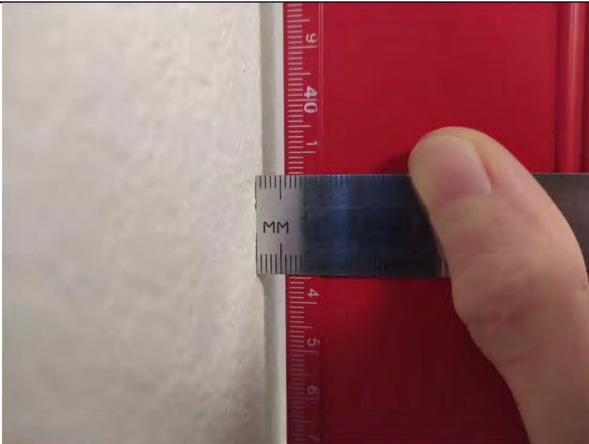
Фото №8. Измерения уровня стен в спальне.
