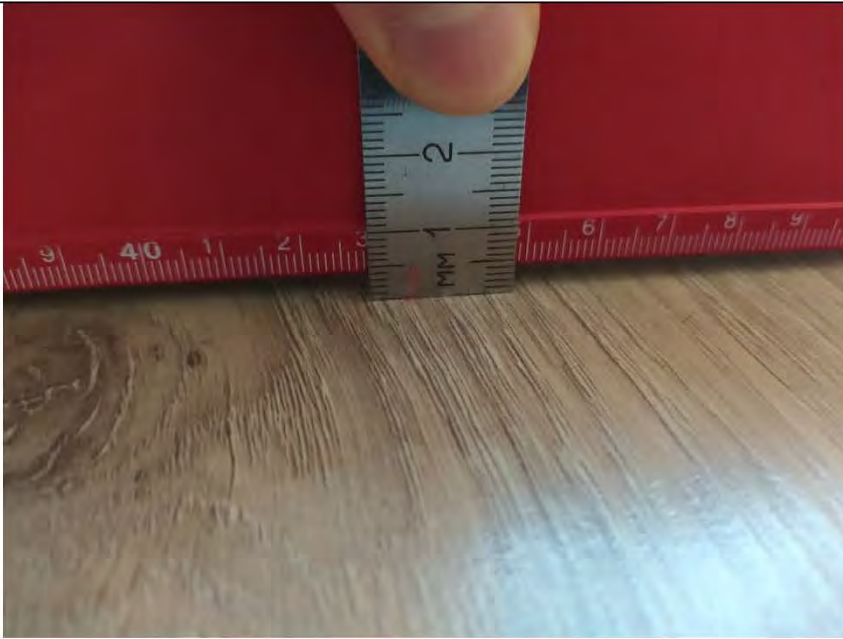
Фото №13. Измерения уровня напольного покрытия в спальне.
