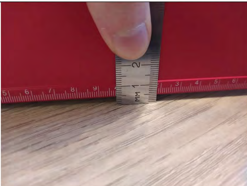
Фото №15. Измерения уровня напольного покрытия в кухне (ламинат).
