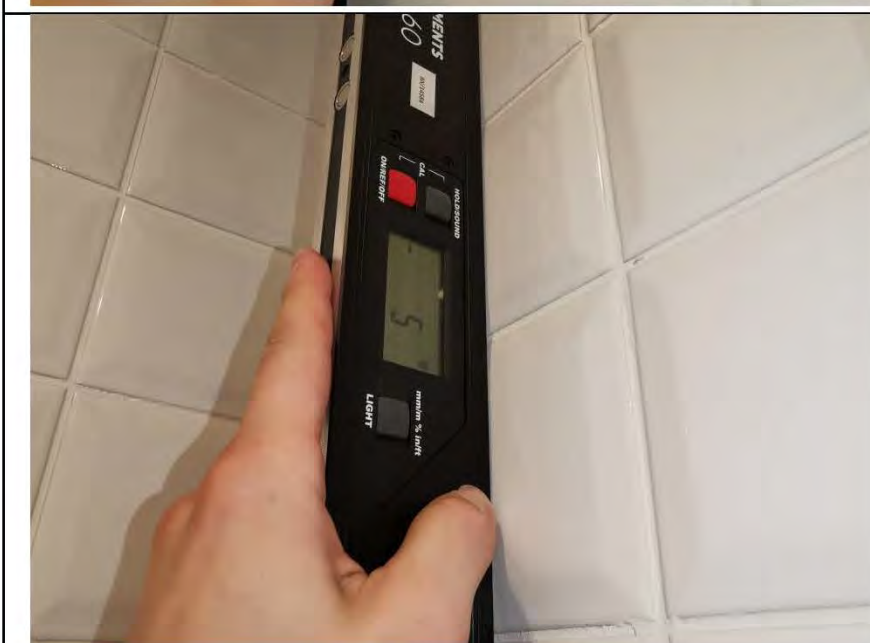
Фото №27. Измерение уровня стен в санузле.
