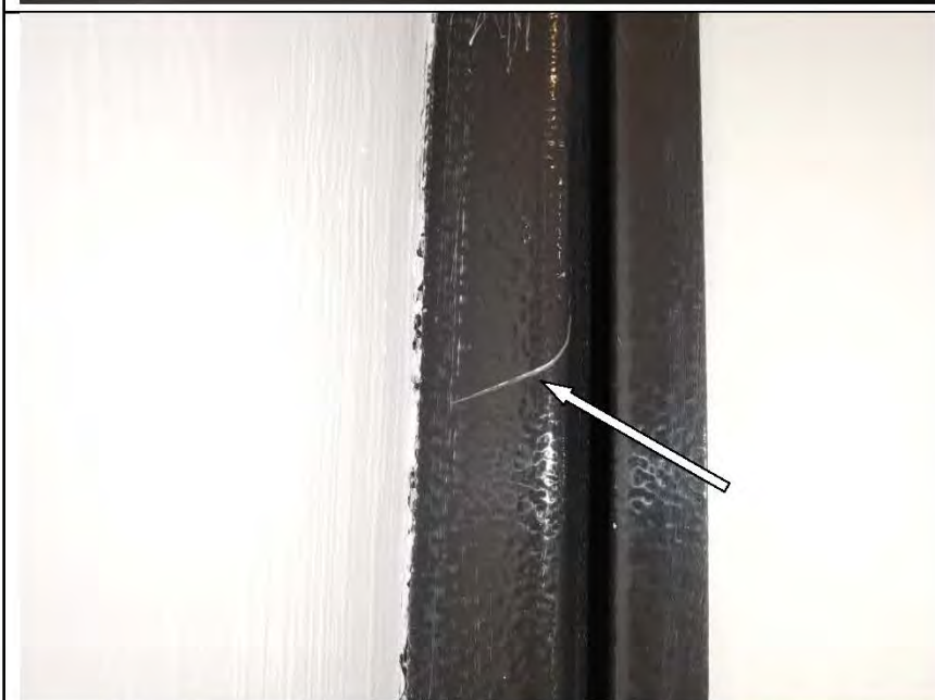
Фото №83. Царапины на коробе входного дверного блока.
