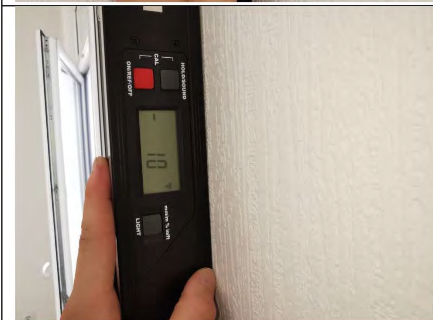
Фото №24. Измерение уровня стен в спальне.
