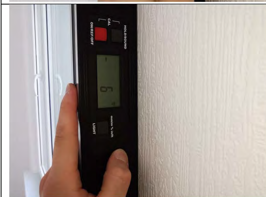
Фото №21. Измерение уровня стен в кухне.
