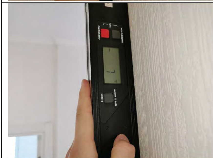
Фото №17. Измерение уровня стен в коридоре.
