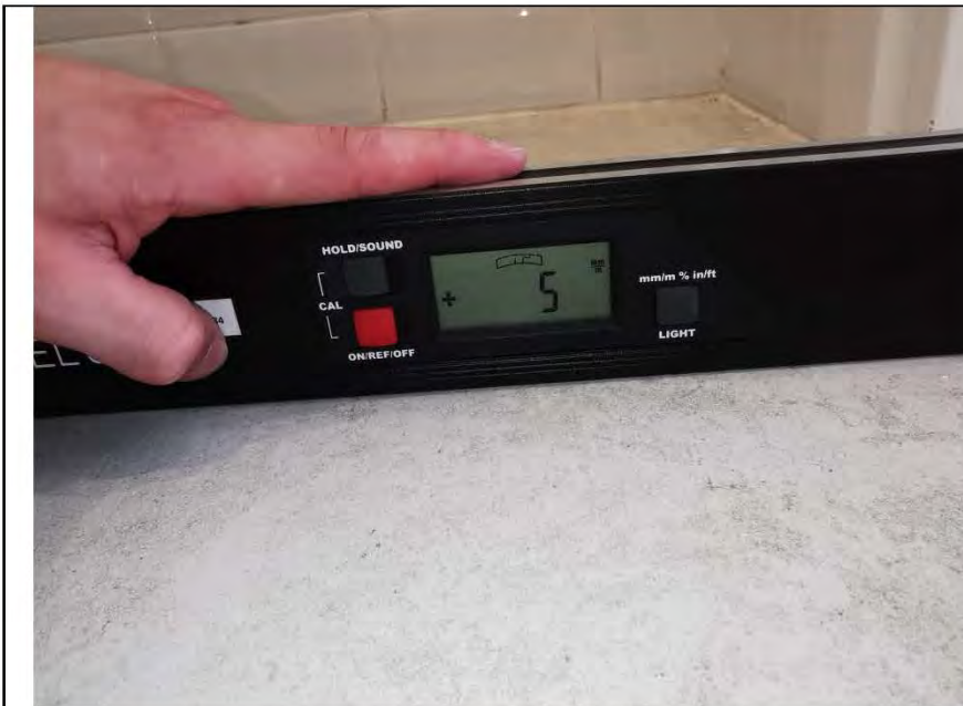
Фото №43. Измерение уровня пола в санузле.
