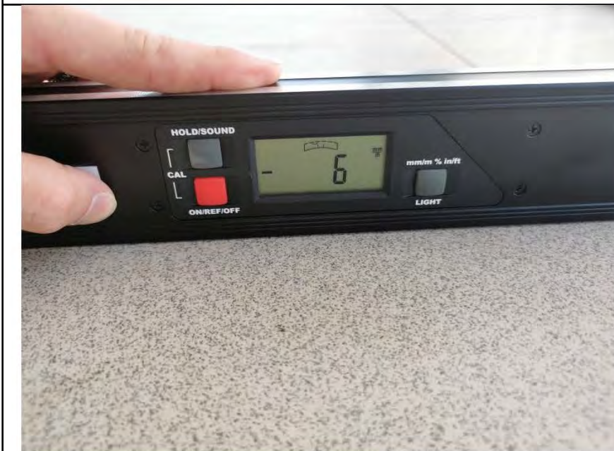
Фото №45. Измерение уровня пола на лоджии.
