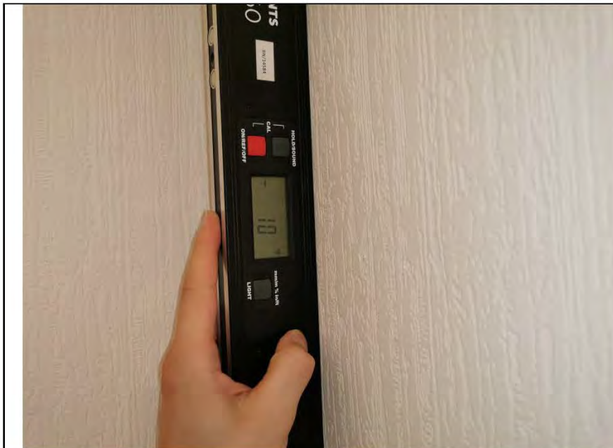
Фото №16. Измерение уровня стен в прихожей.
