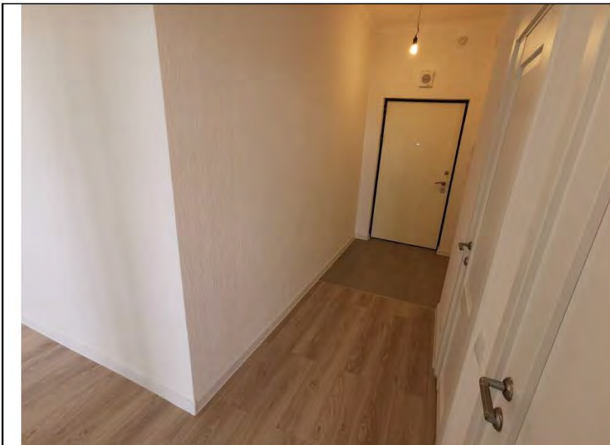
Фото №4. Общий вид коридора.
