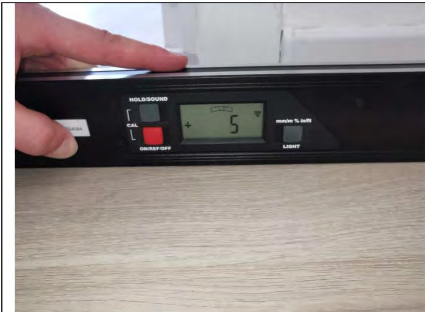
Фото №37. Измерение уровня пола в коридоре.
