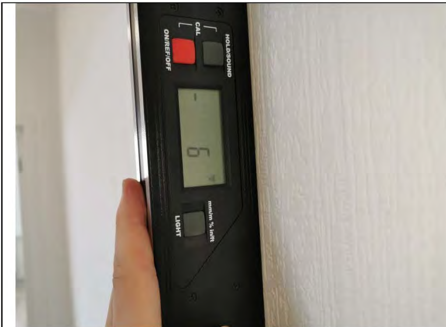
Фото №19. Измерение уровня стен в коридоре.
