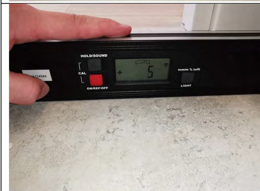
Фото №42. Измерение уровня пола в ванной комнате.
