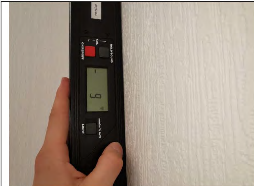
Фото №25. Измерение уровня стен в спальне.
