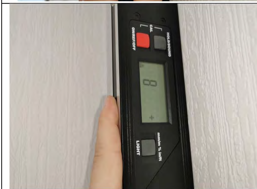
Фото №18. Измерение уровня стен в коридоре.
