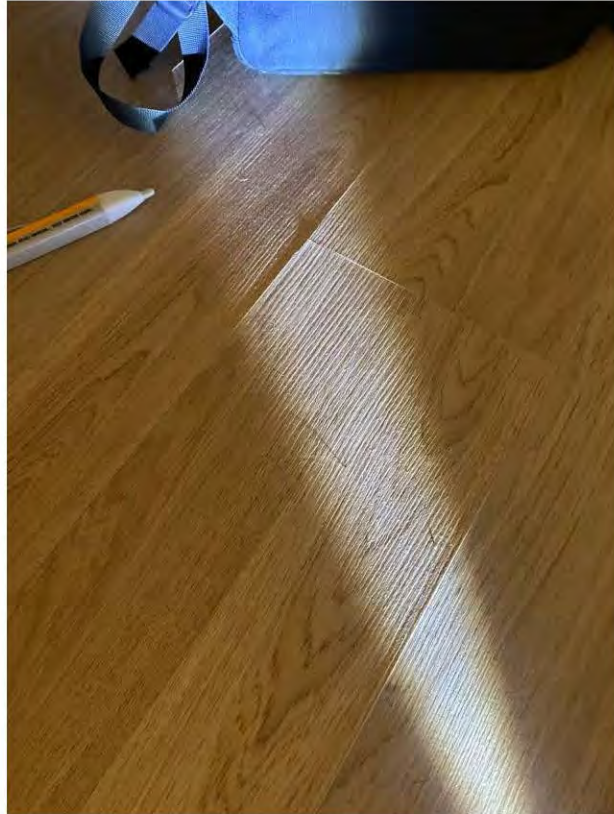
1.3 Уступы между смежными ламинированными досками 1 мм (Коридор)
