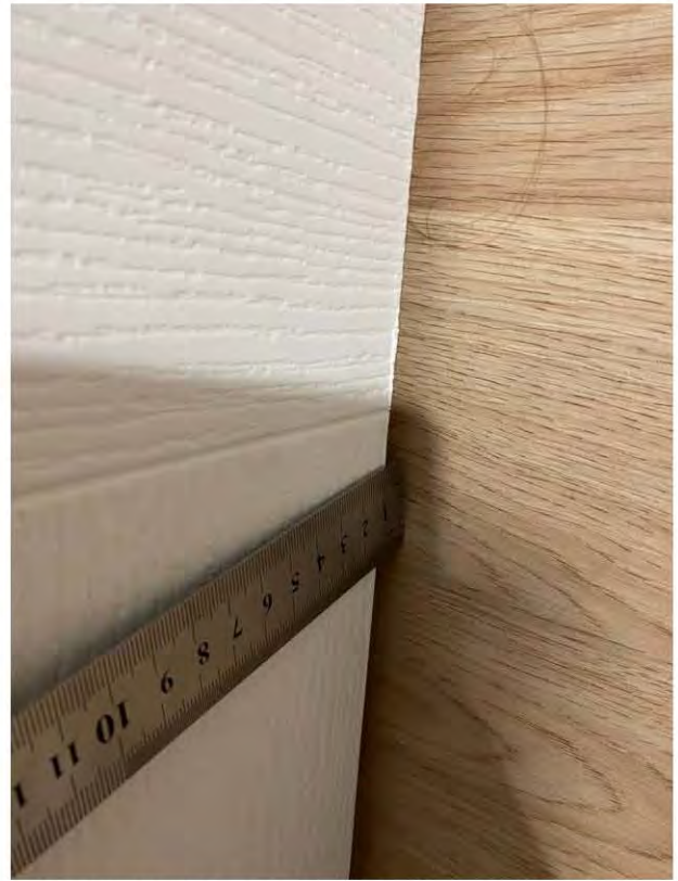
2.2 На дверном блоке имеется зазор 1 мм между смежными элементами в результате криволинейного монтажа (Комната 1)
