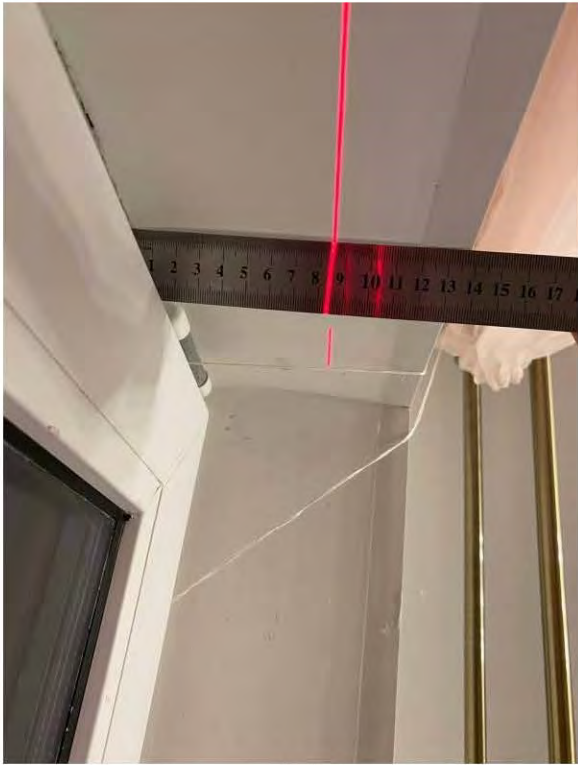
3.5 Отклонение оконного блока от вертикали 5 мм (Кухня)
