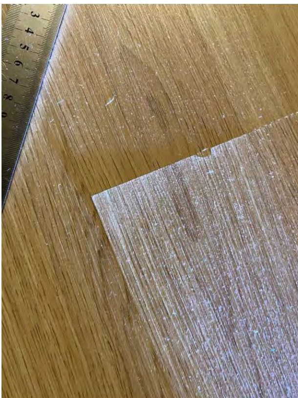
1.3 Уступы между смежными ламинированными досками 1 мм (Коридор)
