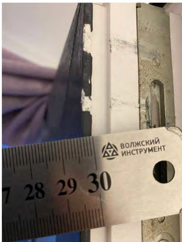
2.11 Множественные повреждения на оконном блоке: царапины, сколы (Комната 1)
