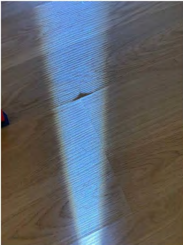
1.3 Уступы между смежными ламинированными досками 1 мм (Коридор)
