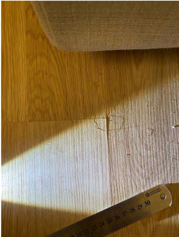
3.3 Уступы между смежными ламинированными досками 1 мм (Кухня)
