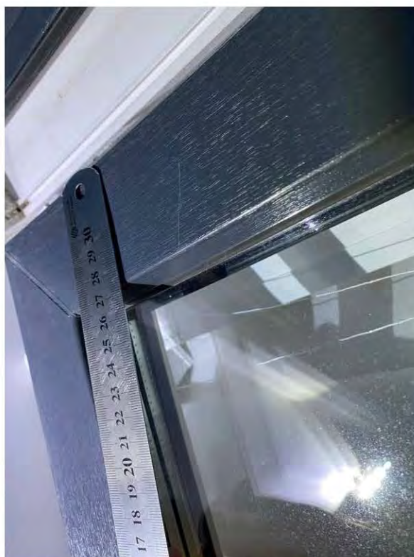
2.11 Множественные повреждения на оконном блоке: царапины, сколы (Комната 1)
