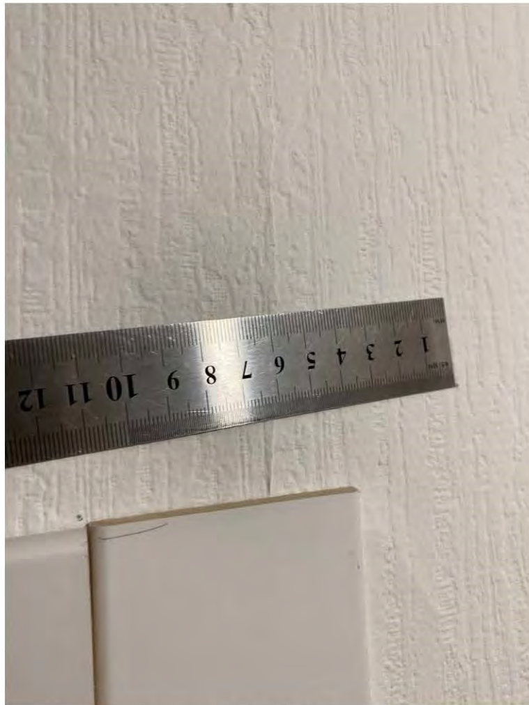
1.1 Локальные участки имеют: замятины, пятна, загрязнения, отслоения обоев (Коридор)
