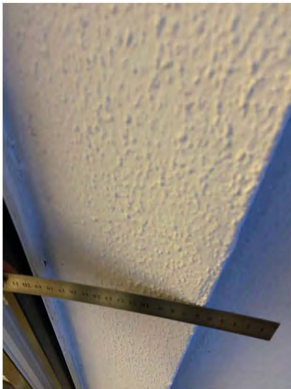
4.1 Некачественная окраска стен, трещины (Лоджия)
