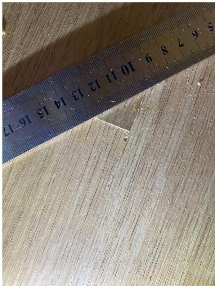
1.4 Сколы на напольном покрытии из ламинированной доски (Коридор)
