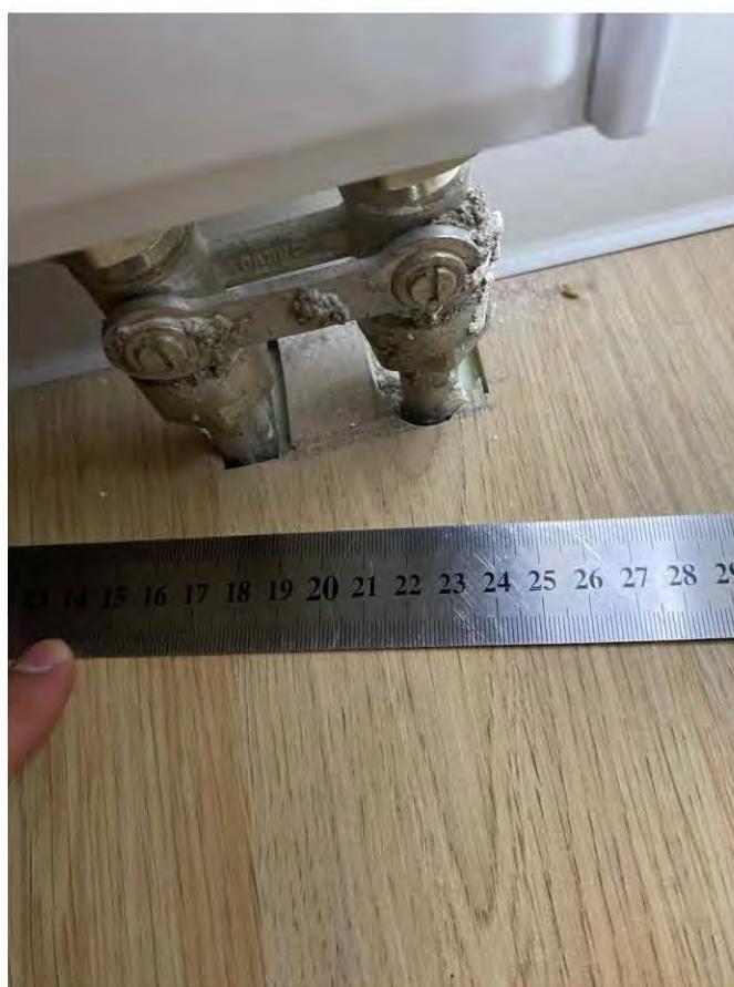
2.9 Зазоры между смежными ламинированными досками до 20 мм (Комната 1)
