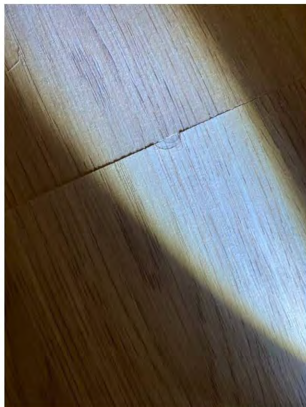
1.3 Уступы между смежными ламинированными досками 1 мм (Коридор)
