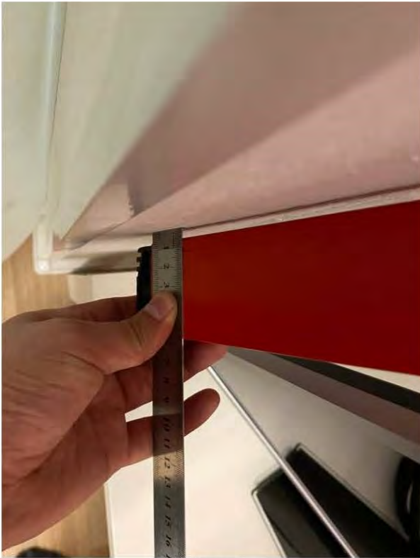
3.1 Отклонения участков стен от горизонтали 6,5 мм, 5,5 мм (Кухня)
