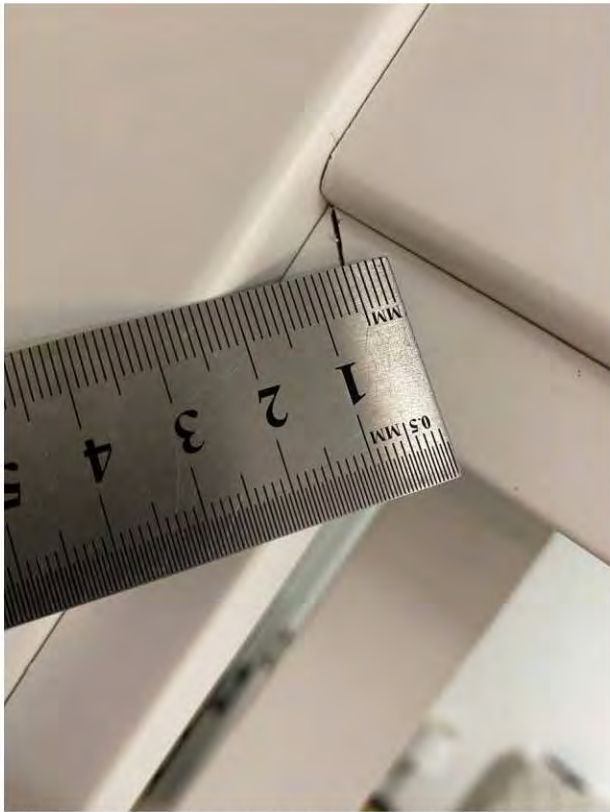
2.2 На дверном блоке имеется зазор 1 мм между смежными элементами в результате криволинейного монтажа (Комната 1)
