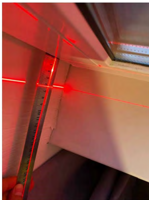
2.7 Отклонение оконного блока от вертикали 5 мм (Комната 1)
