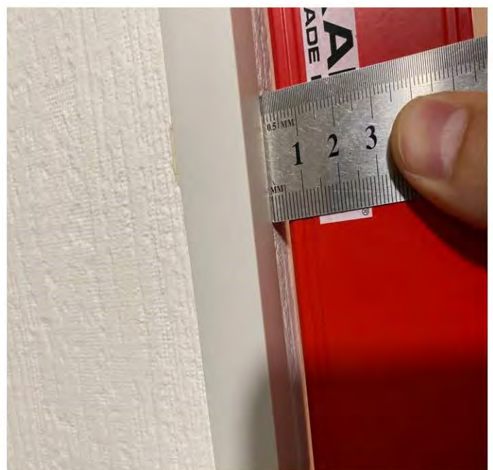
1.2 Отклонения участков стен от горизонтали 15 мм, 5 мм (Коридор)
