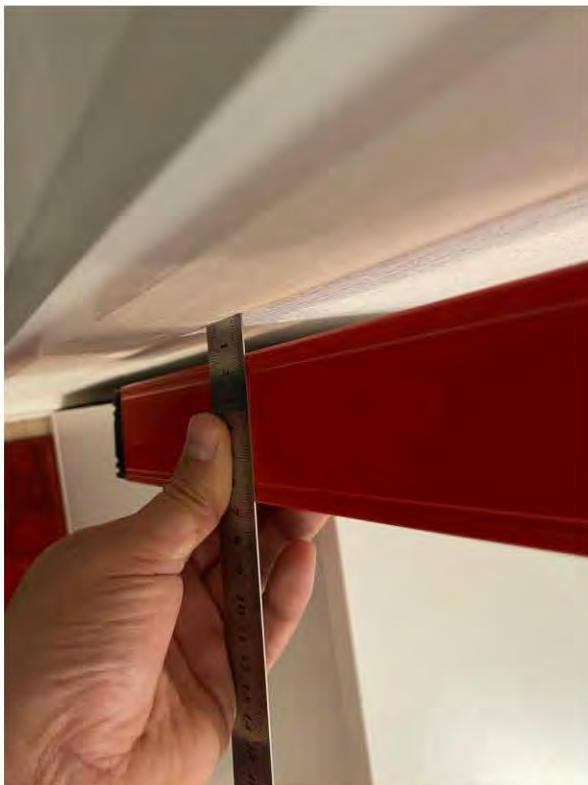
1.2 Отклонения участков стен от горизонтали 15 мм, 5 мм (Коридор)
