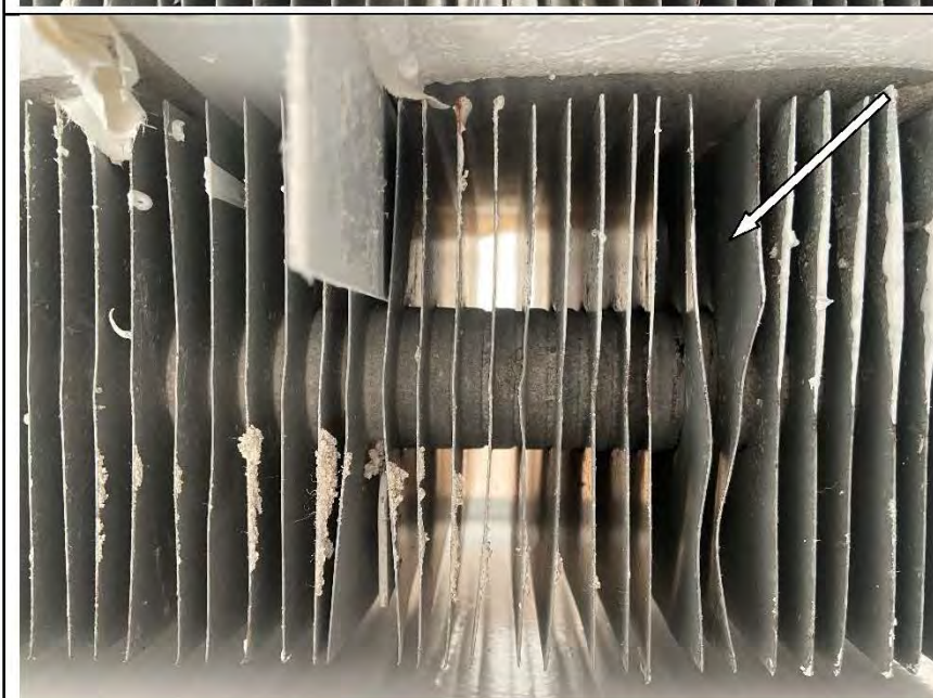
Фото №95. Замятие на радиаторе в кабинете.
