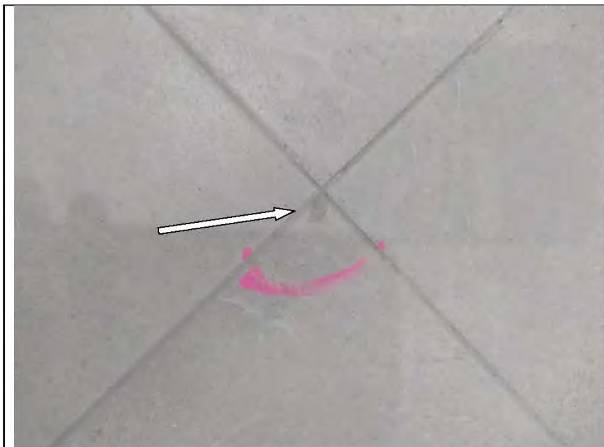
Фото №37. Напольная керамическая плитка в прихожей имеет отбитости
