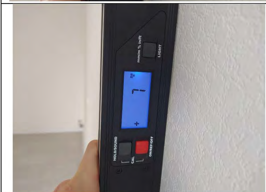
Фото №6. Измерение уровня стен в кухне.
