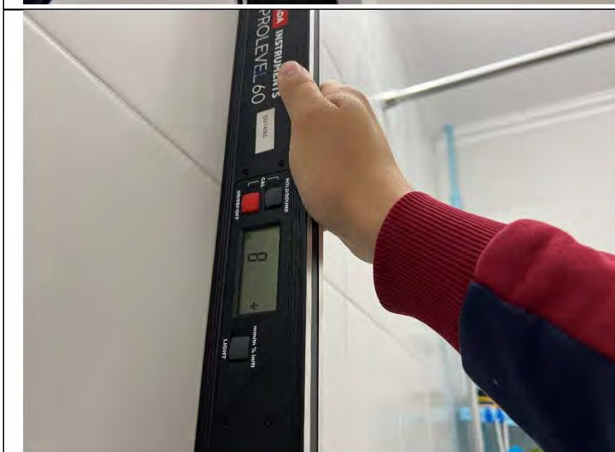
Фото №24. Измерение уровня стен в ванной комнате.
