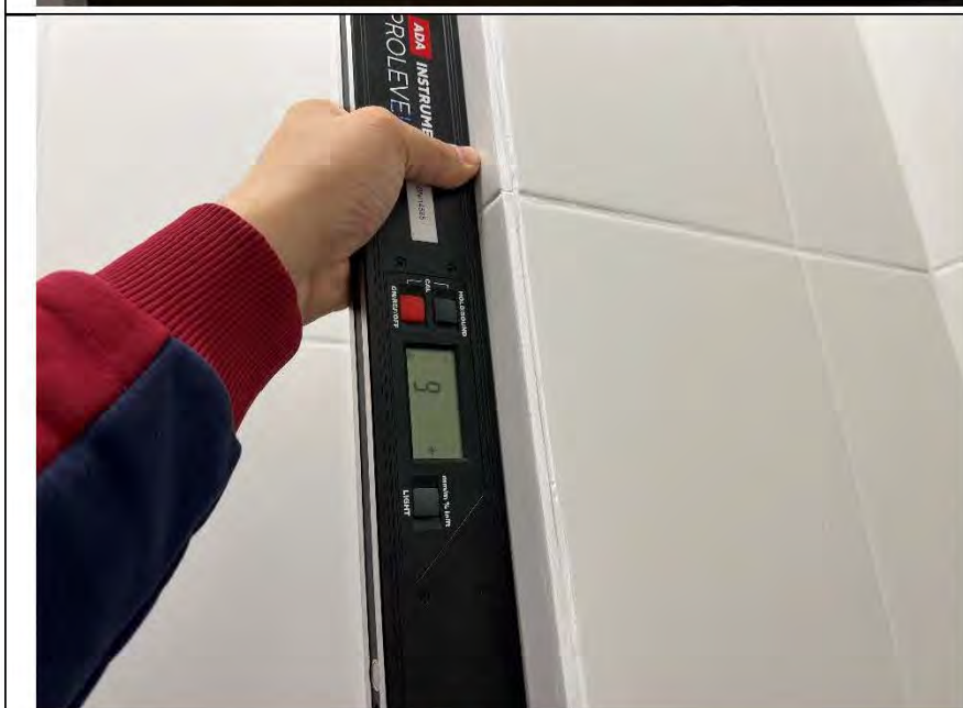
Фото №23. Измерение уровня стен в санузле.
