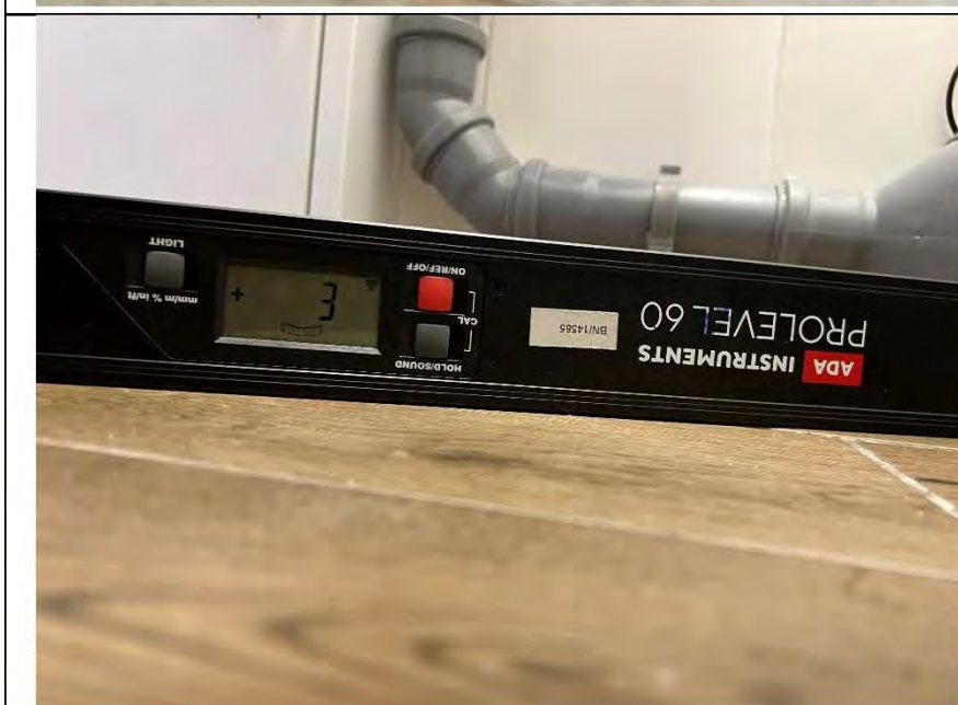
Фото №32. Измерение уровня напольного покрытия в санузле.
