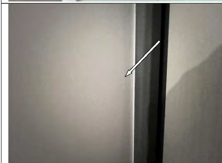
Фото №38. Подтеки краски на откосе входного дверного блока.
