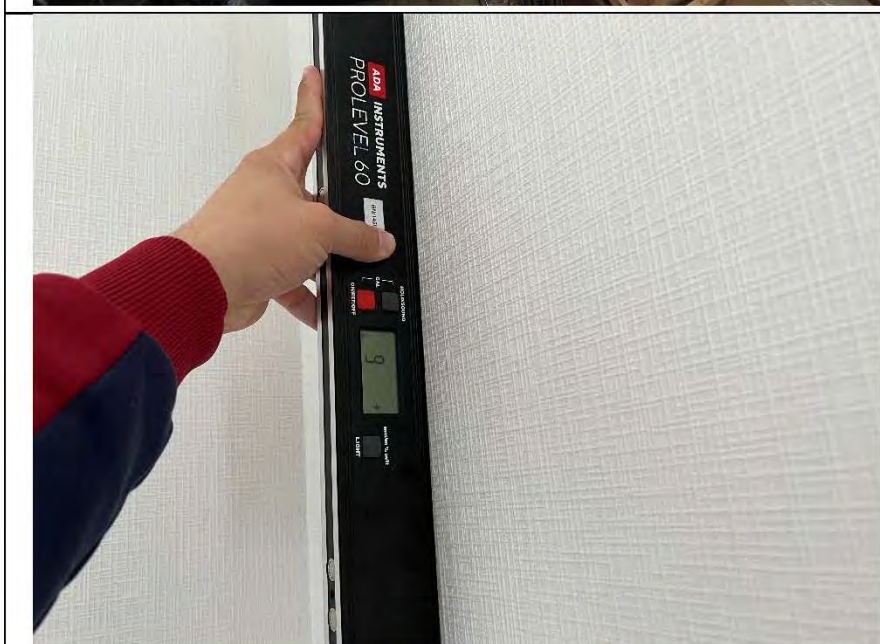
Фото №11. Измерение уровня стен в кухне.
