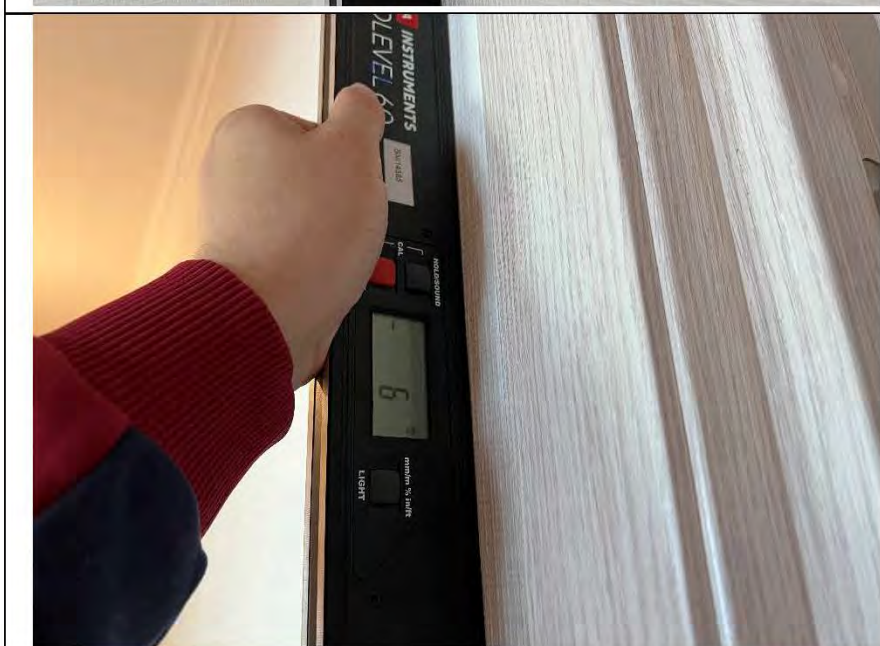
Фото №12. Измерение уровня стен в коридоре.
