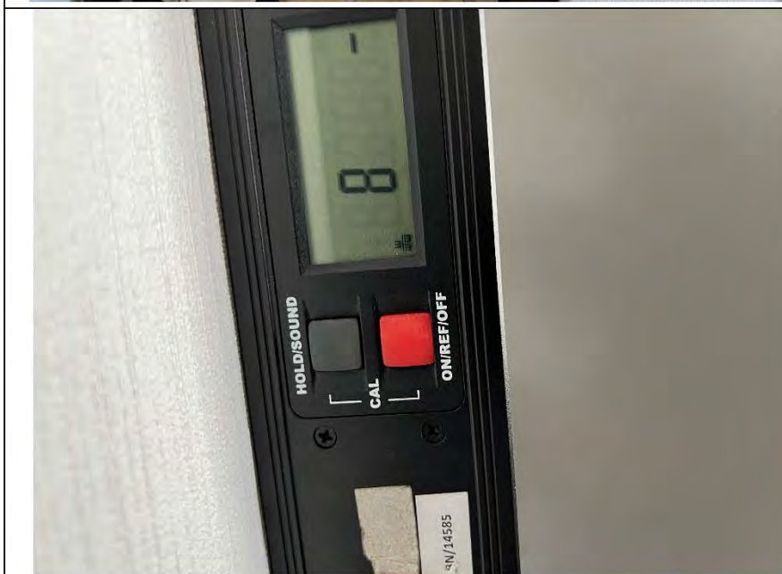
Фото №9. Измерение уровня стен в кухне.
