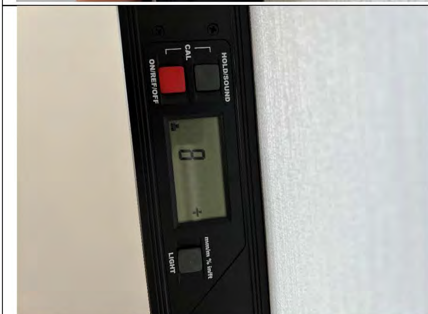
Фото №11. Измерение уровня стен в спальне.
