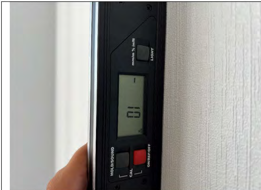
Фото №10. Измерение уровня стен в гостиной.
