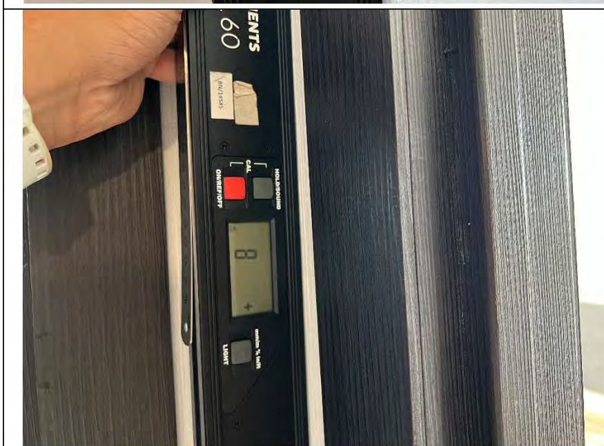
Фото №12. Измерение уровня стен в коридоре.
