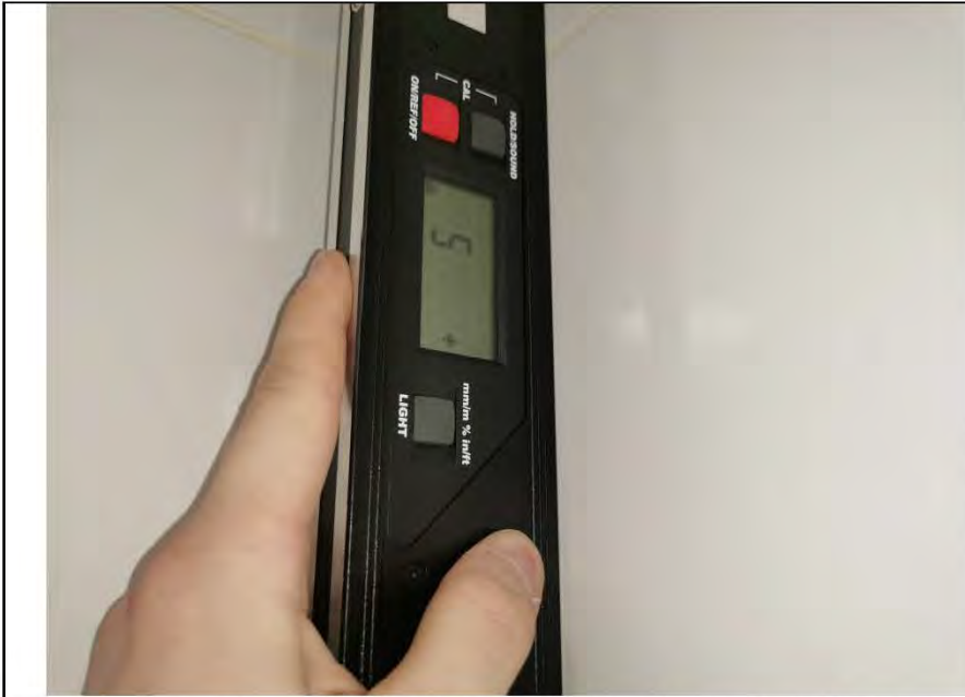
Фото №13. Измерение уровня стен в ванной комнате.
