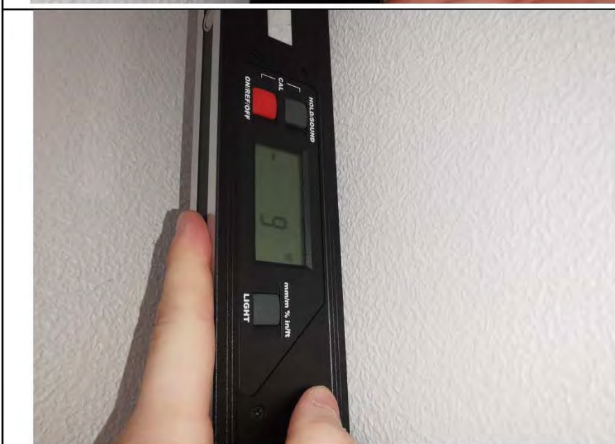
Фото №12. Измерение уровня стен в кухне.
