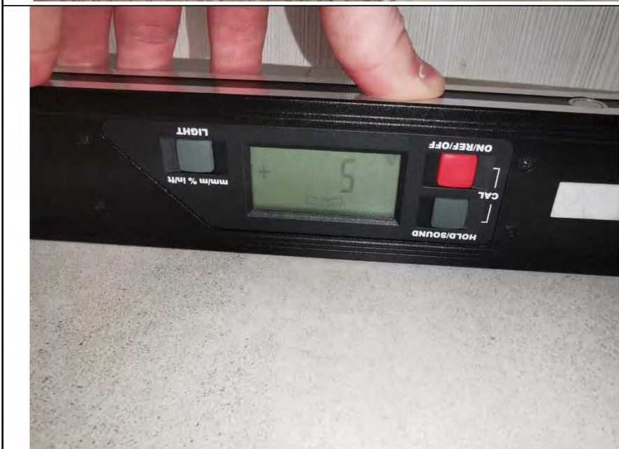
Фото №24. Измерение уровня пола в ванной комнате.
