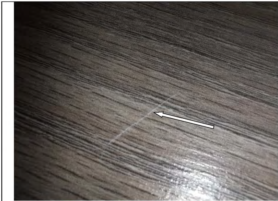
Фото №19. Царапины на напольном покрытии из ламината в спальне.
