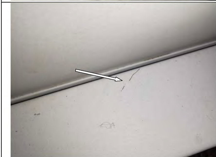
Фото №51. Царапины на коробе входного дверного блока.
