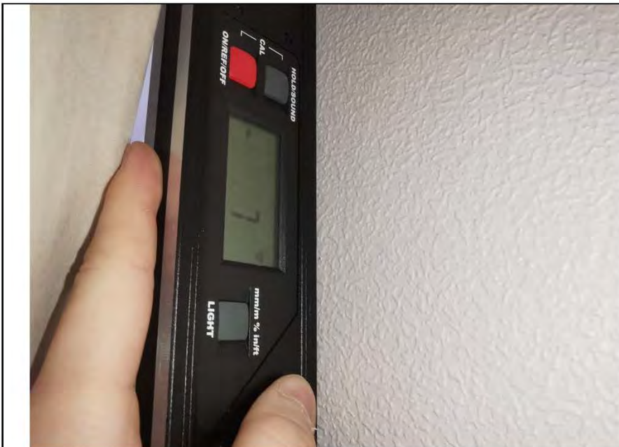
Фото №10. Измерение уровня стен в спальне.
