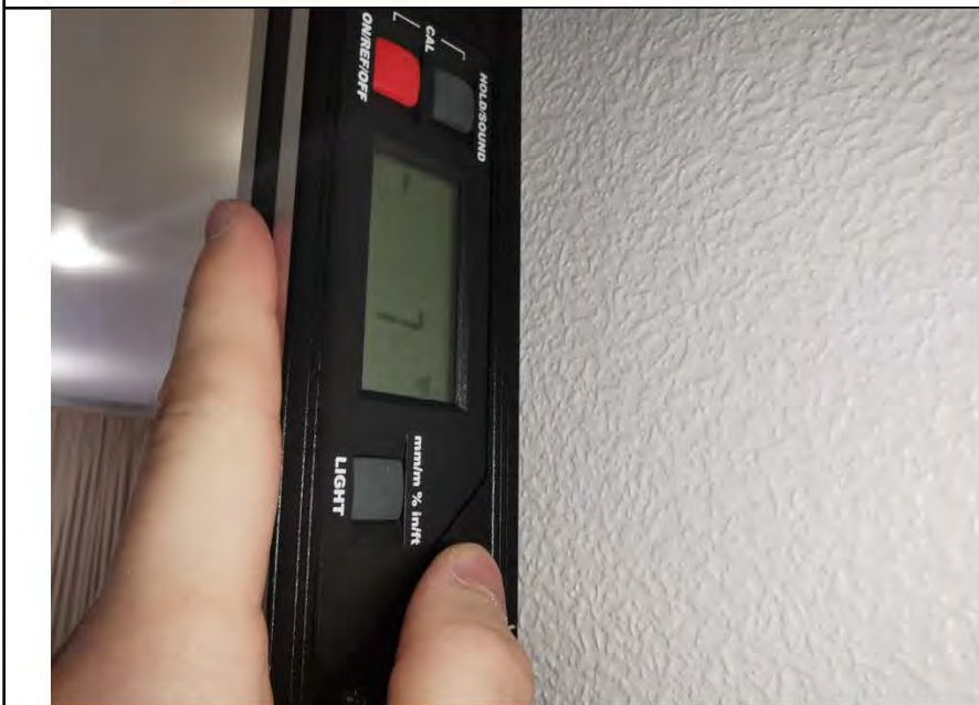
Фото №8. Измерение уровня стен в коридоре.
