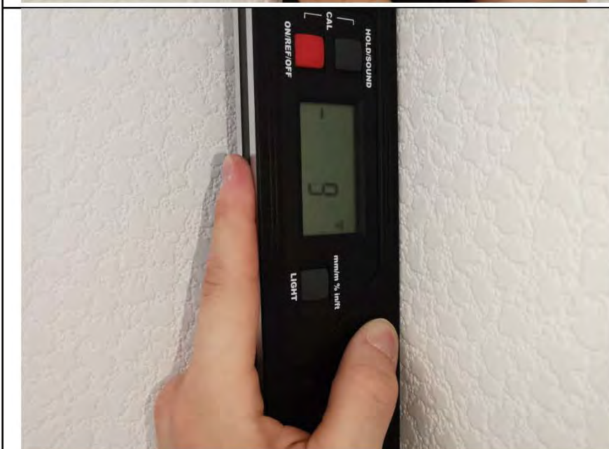
Фото №17. Измерение уровня стен в гостиной.
