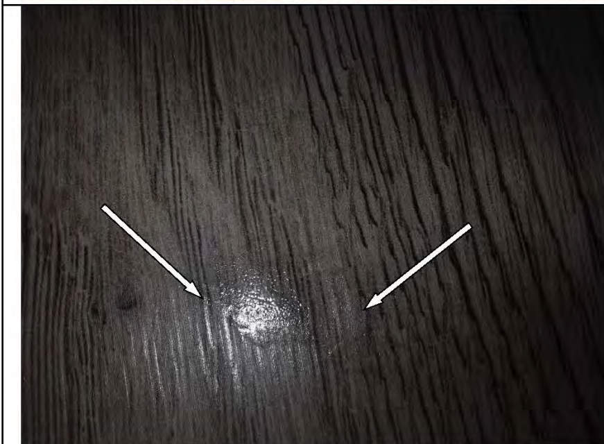
Фото №47. Загрязнение ламината в кухне.
