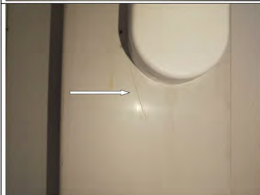
Фото №63. Потертости на профиле оконного блока ПВХ в гостиной.
