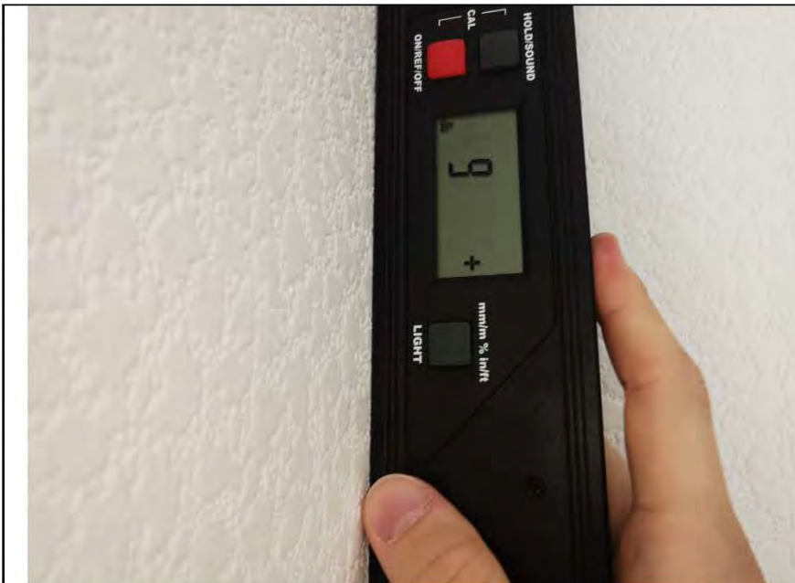
Фото №16. Измерение уровня стен в гостиной.
