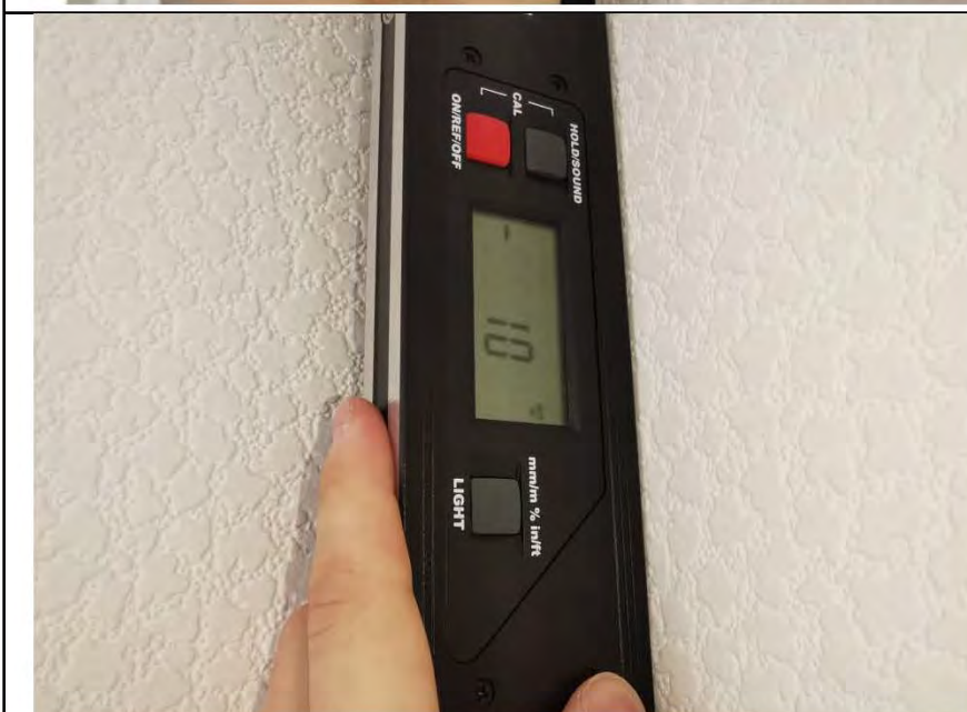
Фото №15. Измерение уровня стен в спальне.
