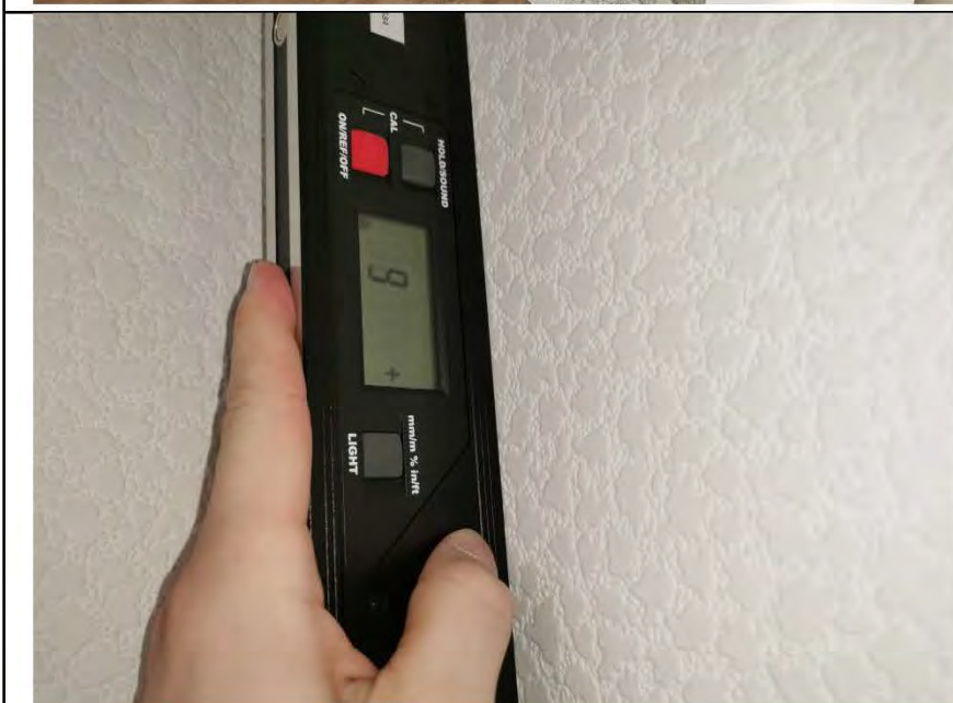
Фото №11. Измерение уровня стен в коридоре.
