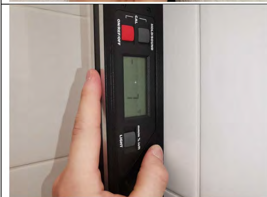
Фото №18. Измерение уровня стен в санузле.
