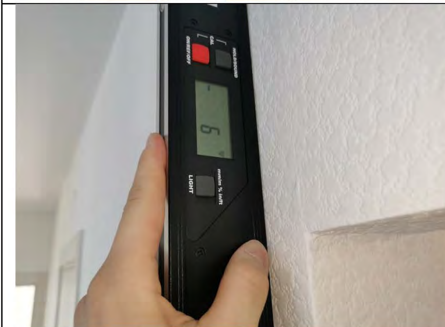
Фото №14. Измерение уровня стен в кухне.
