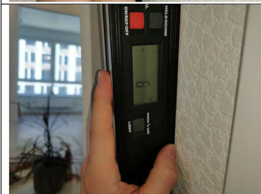
Фото №12. Измерение уровня стен в коридоре.
