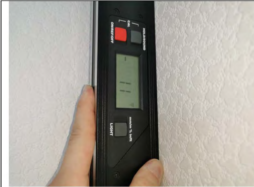
Фото №13. Измерение уровня стен в кухне.
