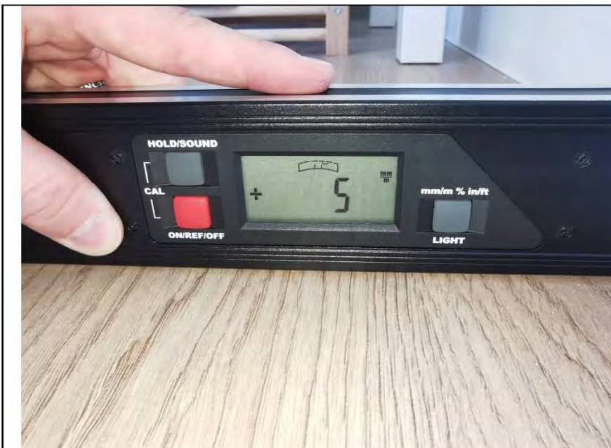
Фото №37. Измерение уровня пола в кухне.
