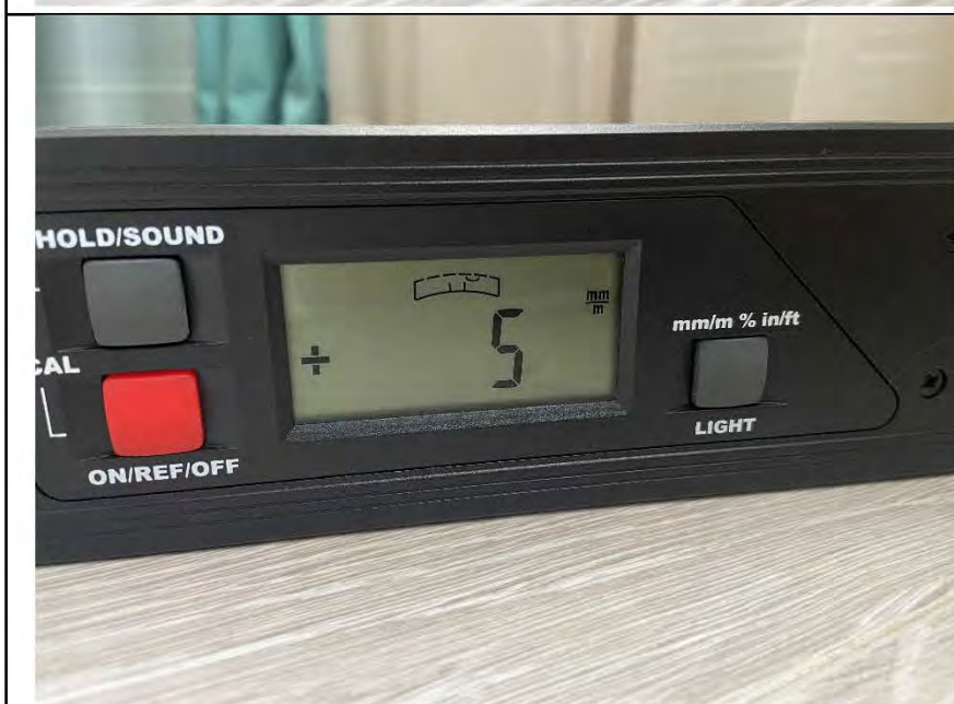
Фото №17. Отклонения поверхности напольного покрытия из ламината в кухне.
