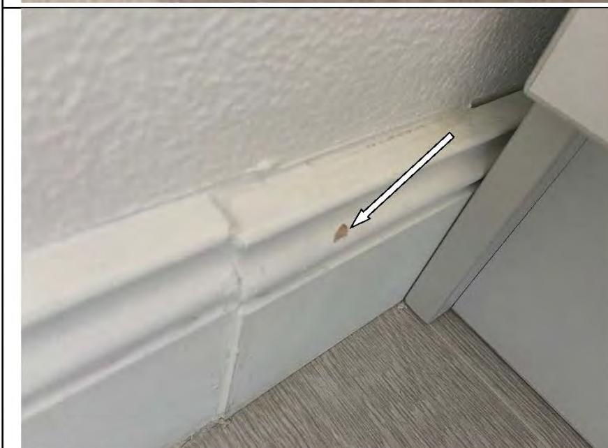
Фото №29. Дефект на напольном деревянном плинтусе в зимнем саду.
