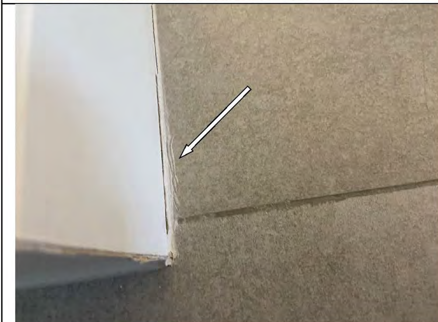
Фото №23. Загрязнения на напольной керамической плитке кухне.
