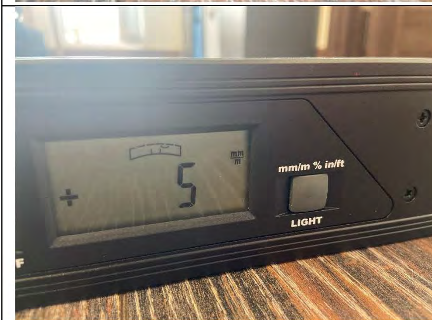
Фото №24. Отклонения поверхности напольного покрытия из ламината в кухне.
