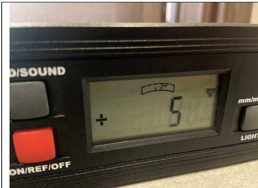
Фото №31. Отклонения поверхности напольного покрытия из керамической плитки в ванной комнате.
