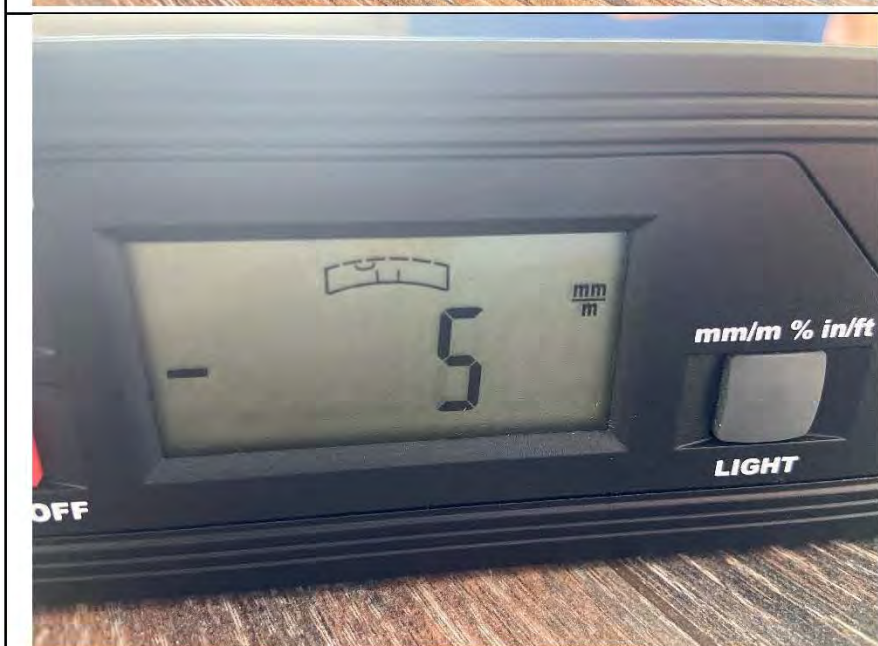
Фото №27. Отклонения поверхности напольного покрытия из ламината в спальне.
