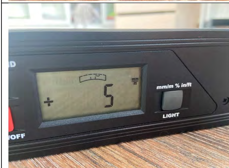
Фото №26. Отклонения поверхности напольного покрытия из ламината в кабинете.
