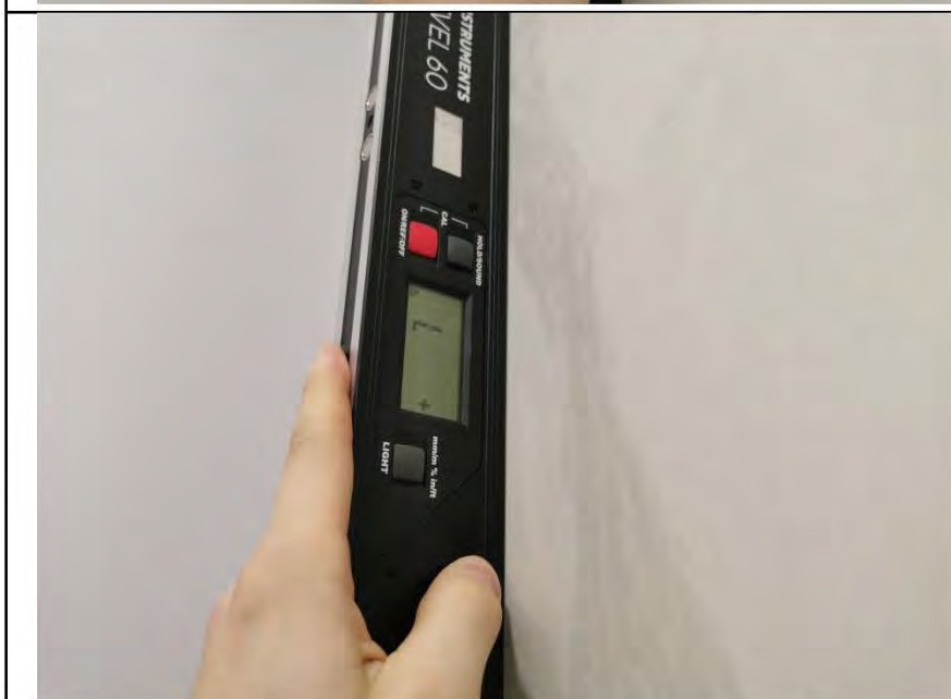
Фото №8. Измерение уровня стен в санузле.
