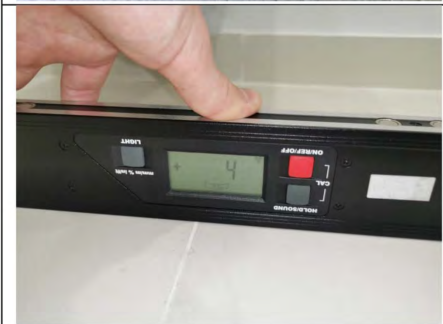
Фото №18. Измерение уровня пола в санузле.
