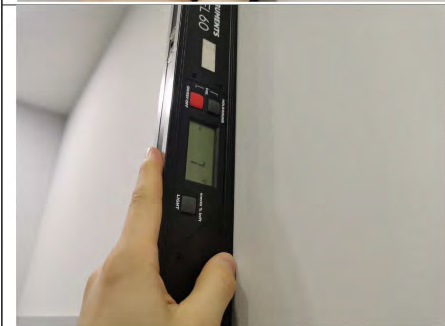
Фото №6. Измерение уровня стен в санузле.
