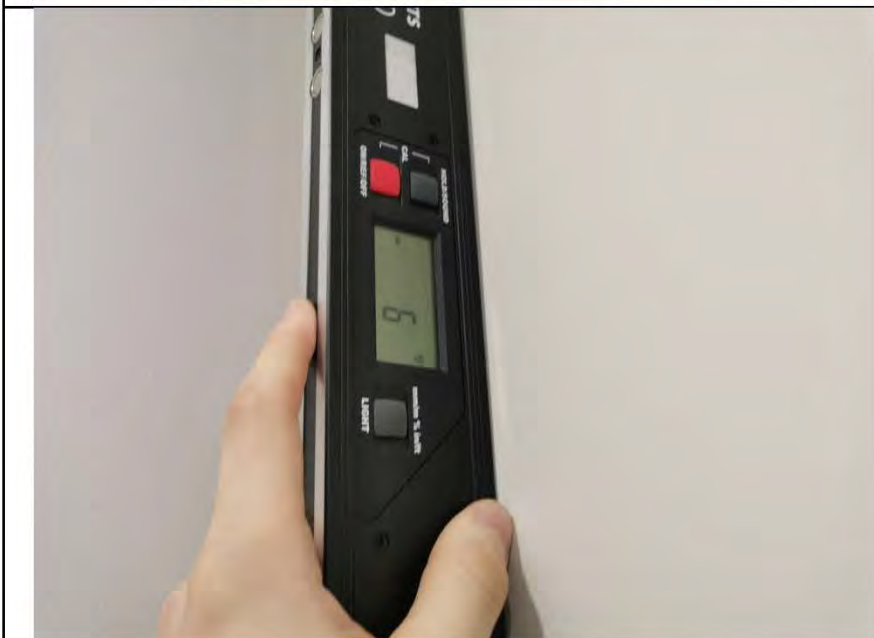
Фото №5. Измерение уровня стен в коридоре.
