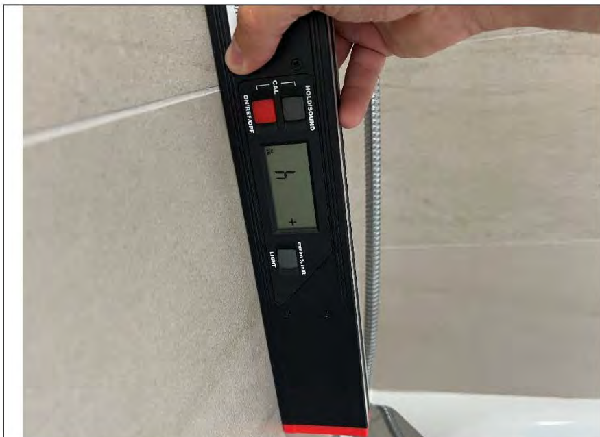
Фото №22. Измерение уровня стен в ванной комнате.
