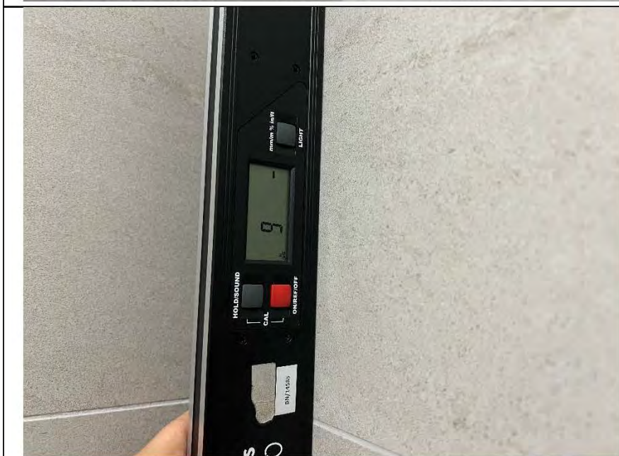
Фото №21. Измерение уровня стен в санузле.
