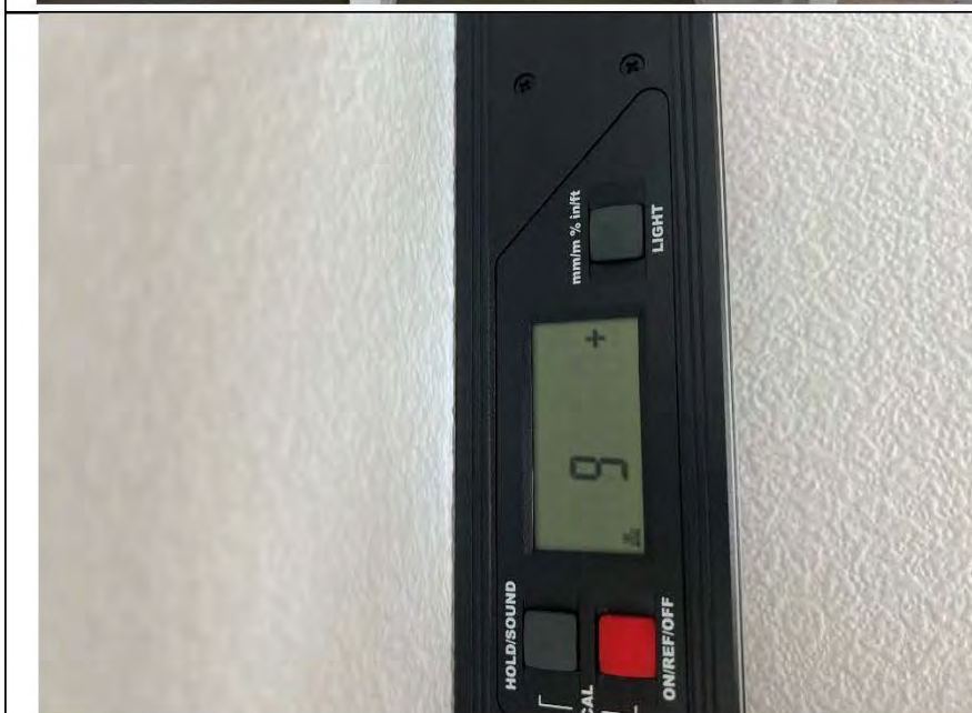
Фото №11. Измерение уровня стен в кухне.
