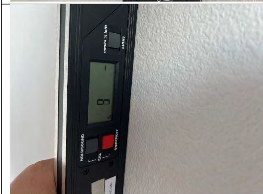
Фото №12. Измерение уровня стен в спальне.
