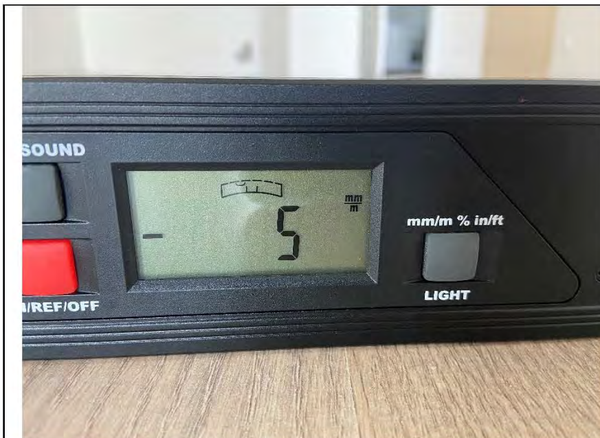
Фото №22. Отклонения поверхности напольного покрытия из ламината в кухне.
