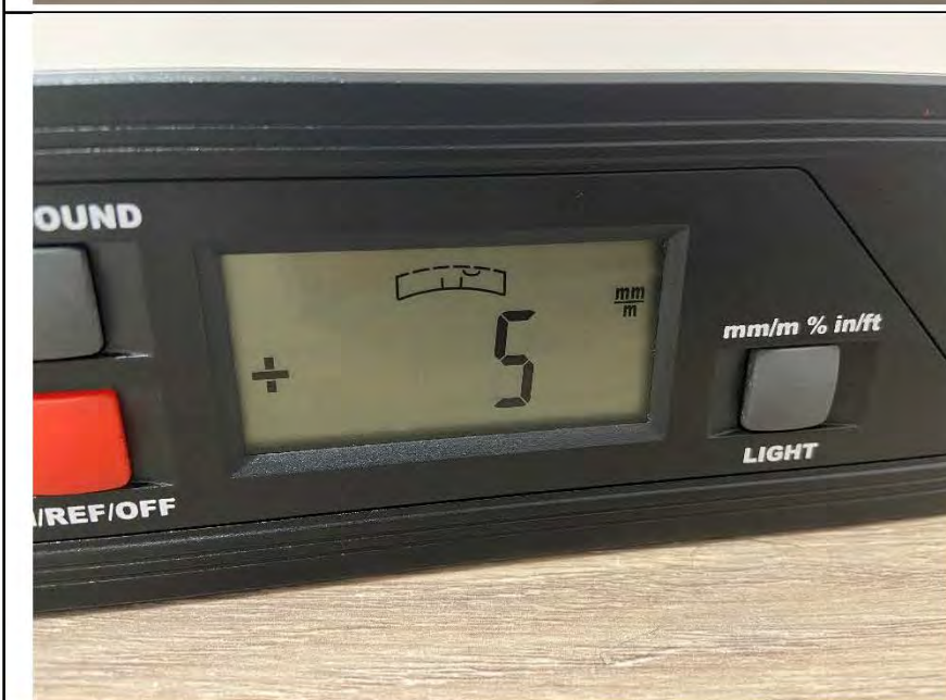
Фото №21. Отклонения поверхности напольного покрытия из ламината в коридоре.
