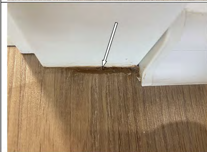
Фото №42. Коротко подрезан ламинат на стыке элементов в коридоре.
