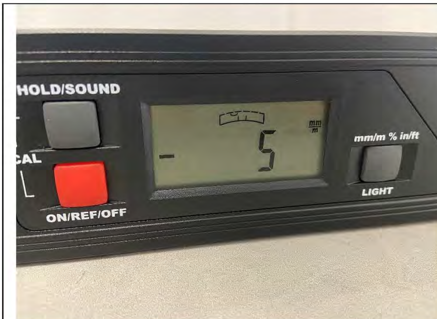
Фото №25. Отклонения поверхности напольного покрытия из керамической плитки в ванной комнате.
